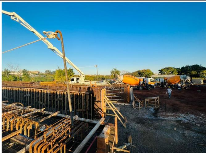
Bombeamento de concreto em vigas longarinas de concreto.
