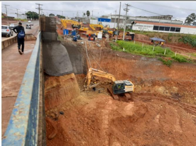
Execução de concreto projetado com chumbadores para proteger execução de noda fundação do novo viaduto
