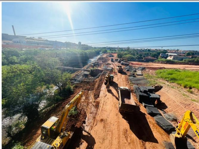
Equipamentos de terraplenagem e construção de muro de gabião
