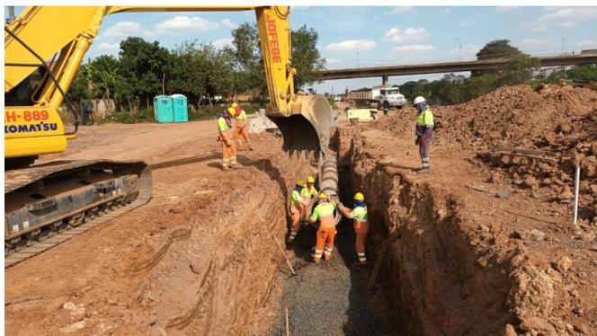
Drenagem com a execução de tubos de concreto
