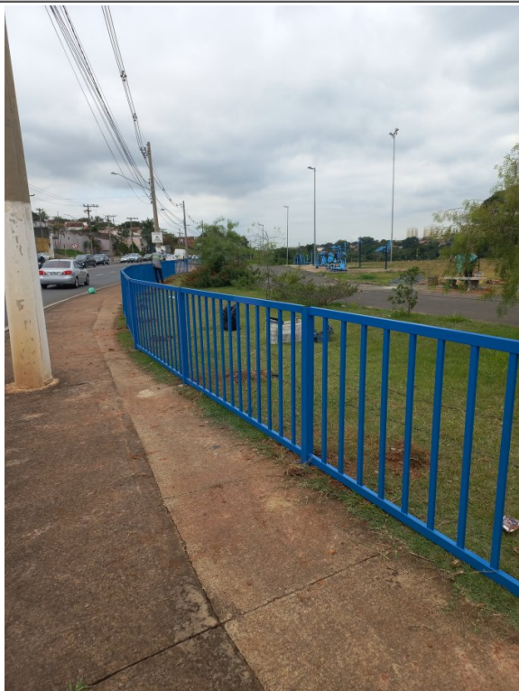
Andamento da instalação do gradil no entorno do playground
