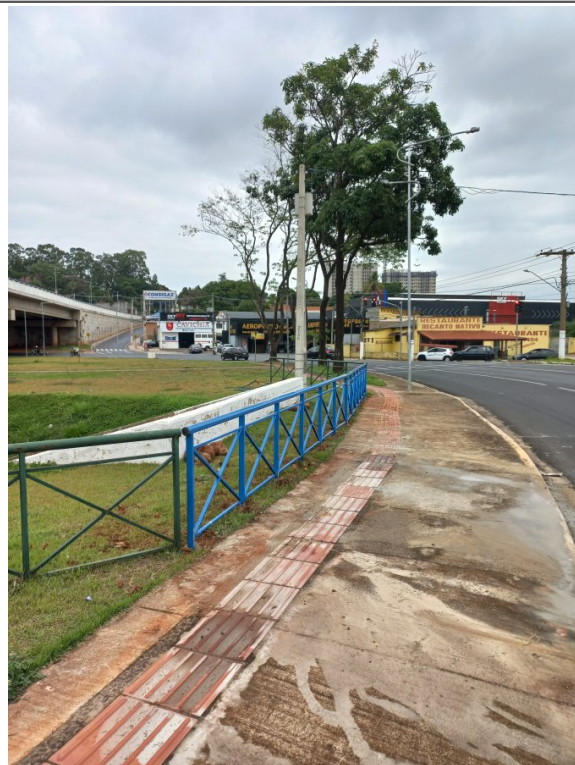
Gradil substituído no interior da rotatória
