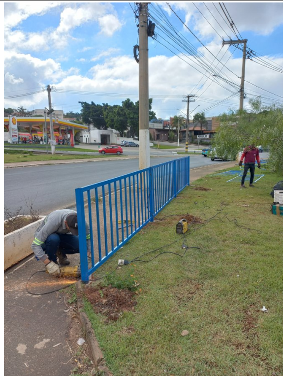
Início da instalação do gradil
