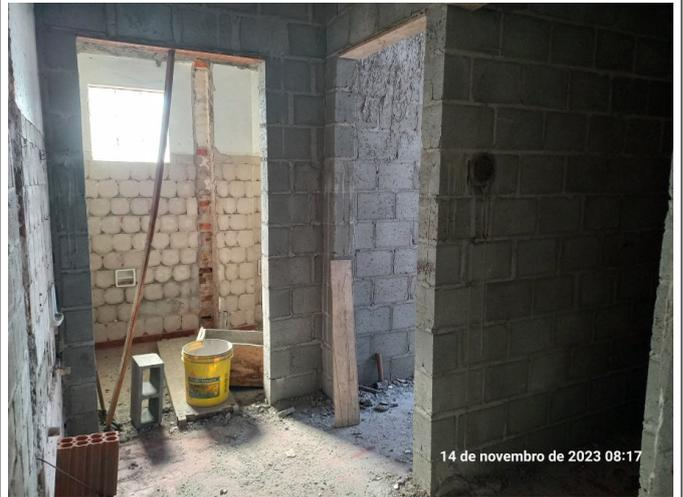
Alvenaria executada no sanitário PCD da Comunicação.
