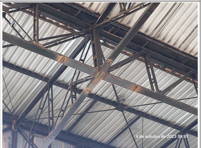
Recuperação estrutural da cobertura.
