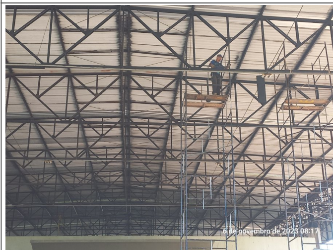
Pintura da estrutura metálica.
