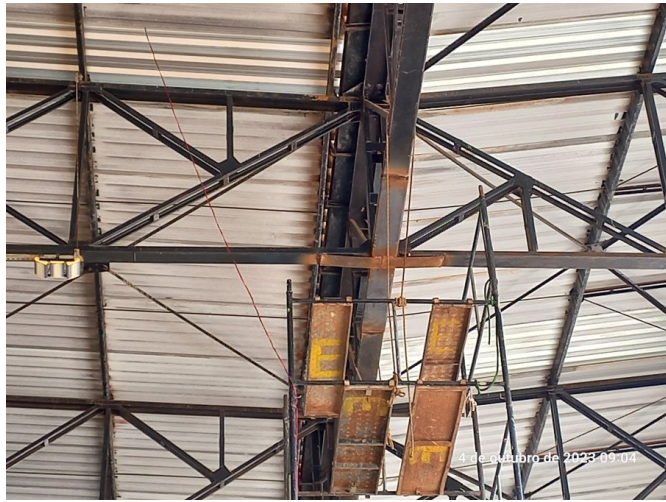
Recuperação estrutural da cobertura.
