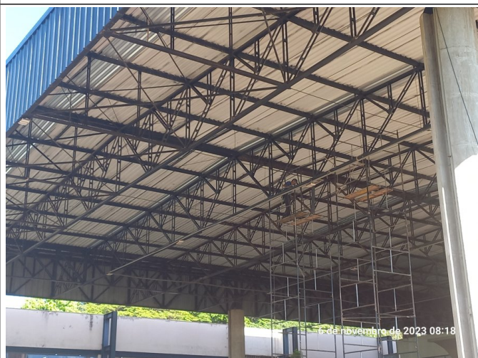
Pintura da estrutura metálica.
