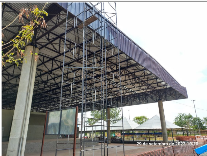
Substituição da calha na cobertura.
