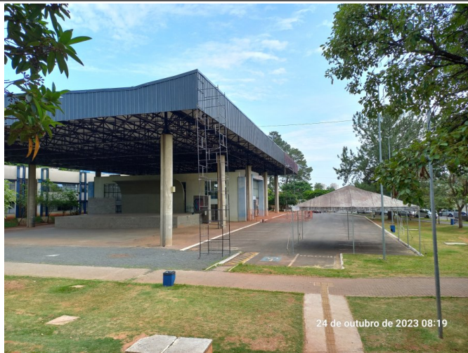
Pintura da telha lateral da cobertura.
