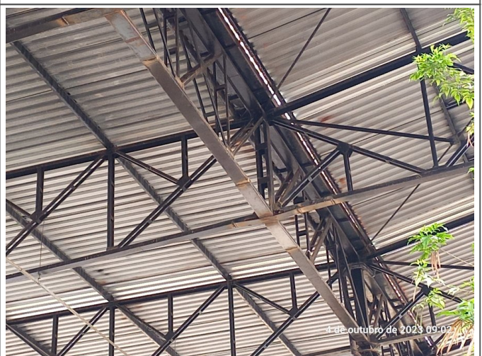
Recuperação estrutural da cobertura.
