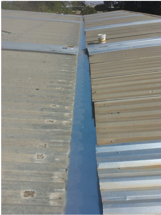
Instalação da calha na cobertura.
