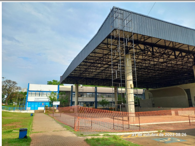
Pintura da telha lateral da cobertura.
