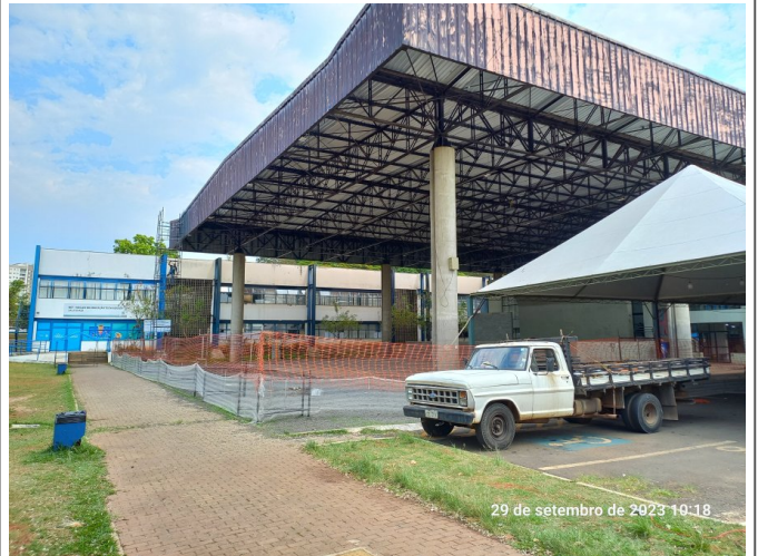
Substituição da calha na cobertura.
