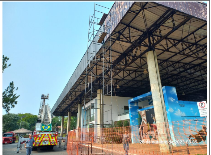
Pintura da telha lateral da cobertura.
