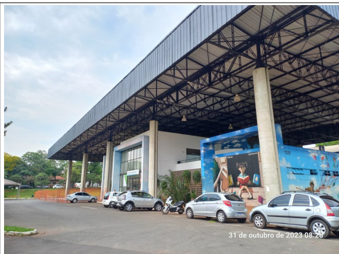
Pintura da telha lateral da cobertura.
