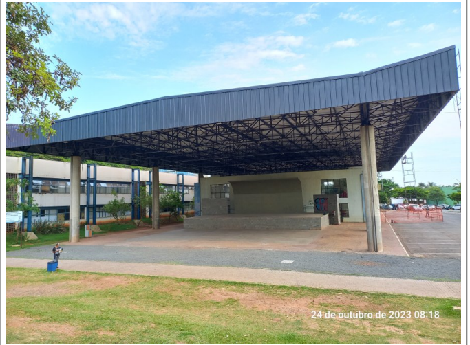
Pintura da telha lateral da cobertura.
