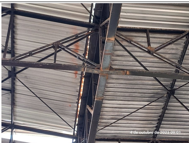
Recuperação estrutural da cobertura.
