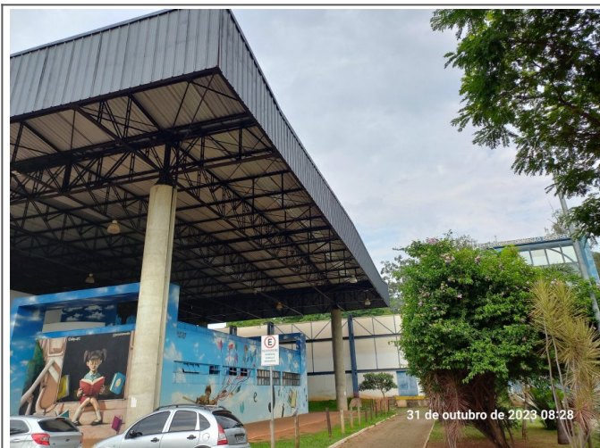
Pintura da telha lateral da cobertura.
