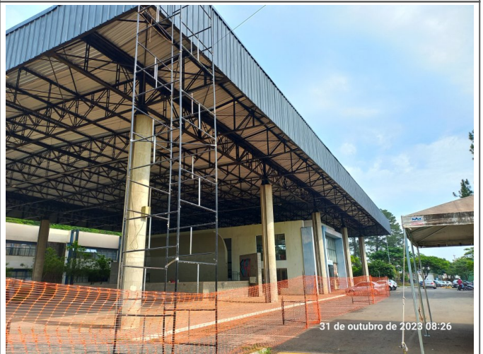
Pintura da telha lateral da cobertura.
