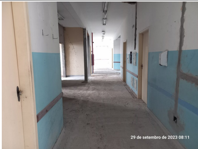
Finalização da execução do granilite no pavimento superior.
