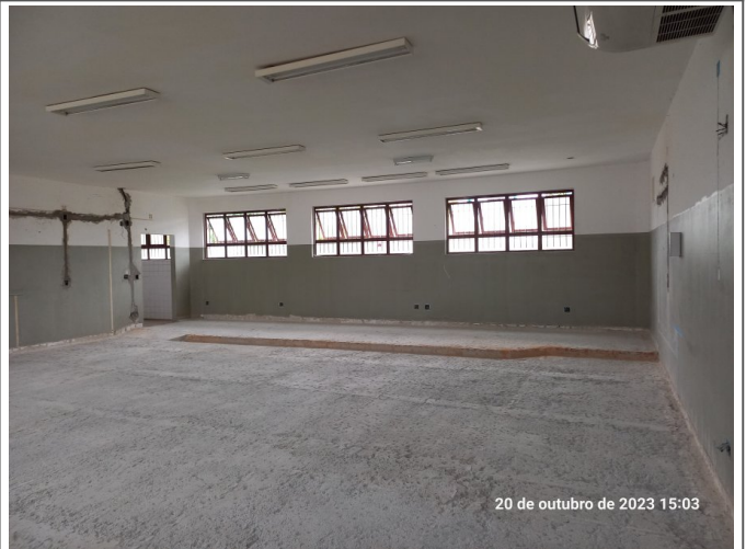
Demolição do granilite da área da farmácia.
