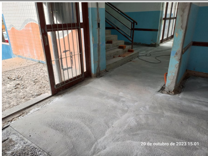
Execução do granilite no pavimento térreo.
