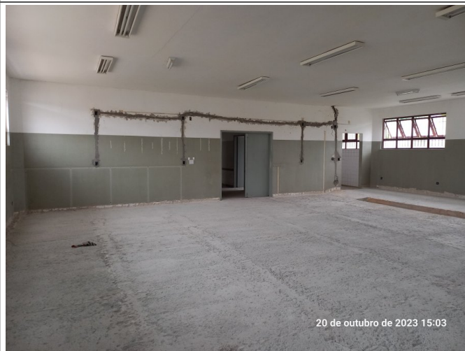
Demolição do granilite da área da farmácia.
