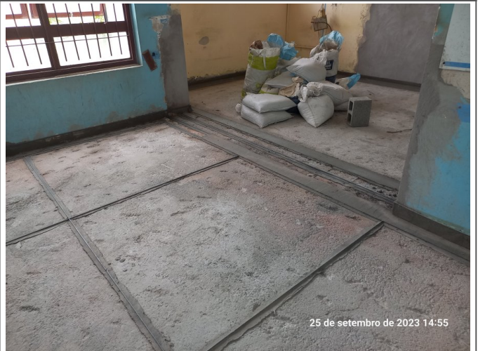
Marcação do pavimento superior para execução do granilite.
