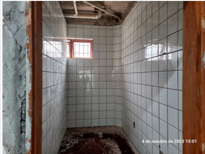
Instalação dos batentes das portas.
