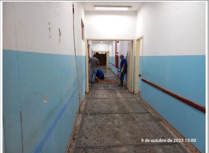
Execução do granilite no pavimento térreo.
