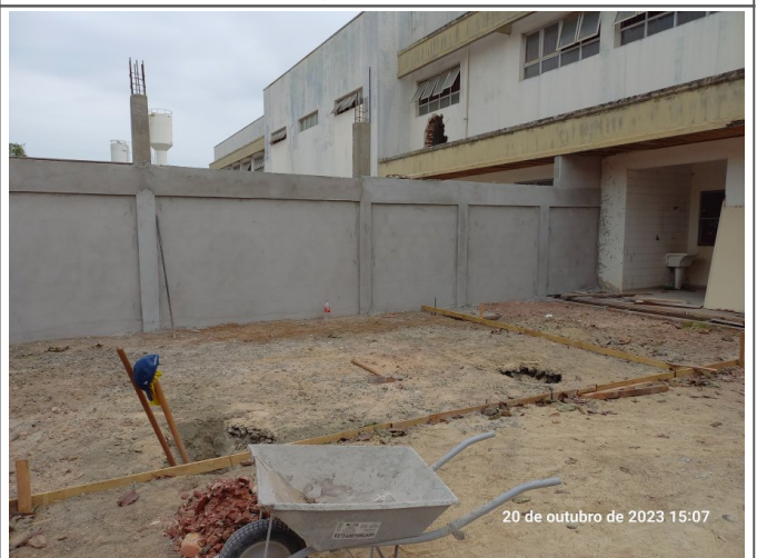
Execução da fundação do pergolado e da cobertura aos fundos.
