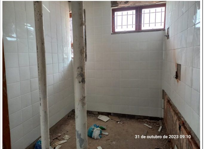
Execução do revestimento cerâmico no banheiro.
