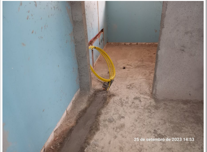
Instalação da tubulação de gás combustível.
