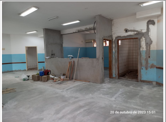
Execução do granilite no pavimento térreo.
