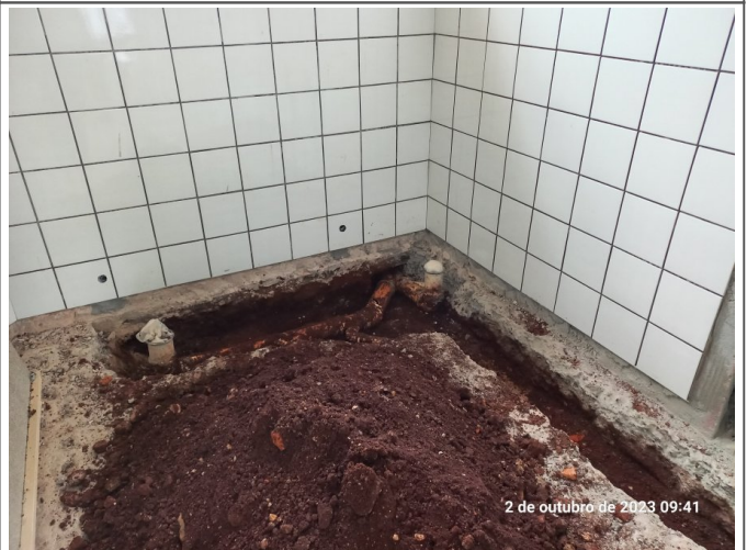
Execução da instalação hidráulica de esgoto no banheiro do pavimento térreo.
