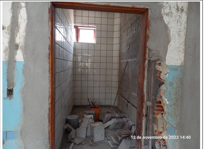
Execução do revestimento cerâmico no banheiro.
