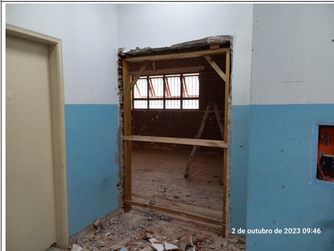
Instalação dos batentes das portas.
