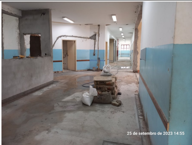
Limpeza do pavimento superior para execução do granilite.
