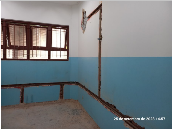
Execução da instalação hidráulica de água fria no pavimento inferior.
