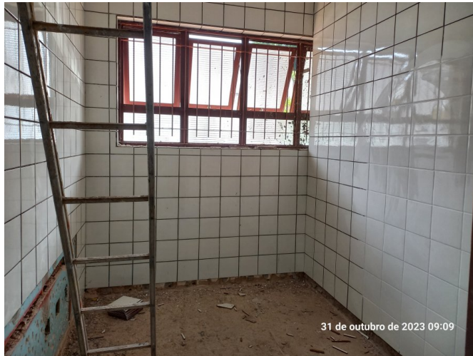
Execução do revestimento cerâmico no banheiro.
