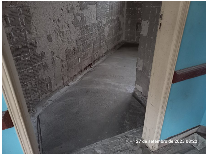
Execução do granilite no pavimento superior.
