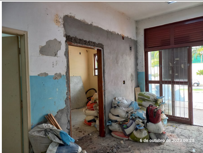
Instalação dos batentes das portas.
