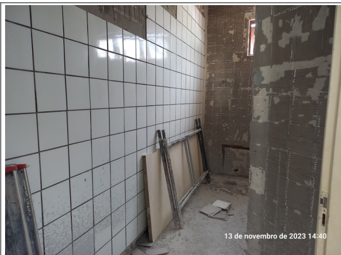
Execução do revestimento cerâmico no banheiro.
