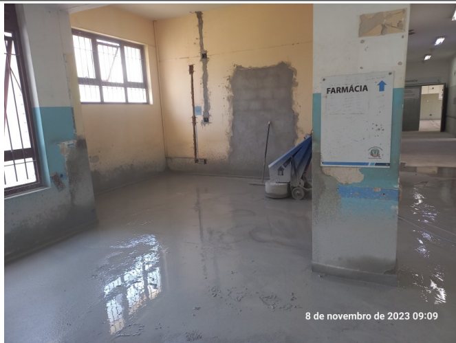
Início do polimento do granilite no pavimento superior.
