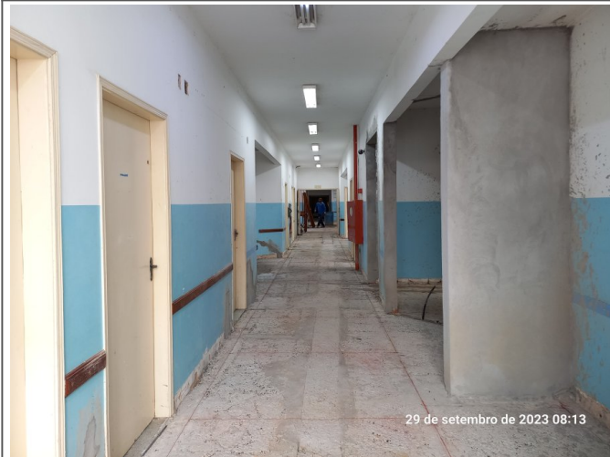
Marcação das juntas para execução do granilite no pavimento térreo.
