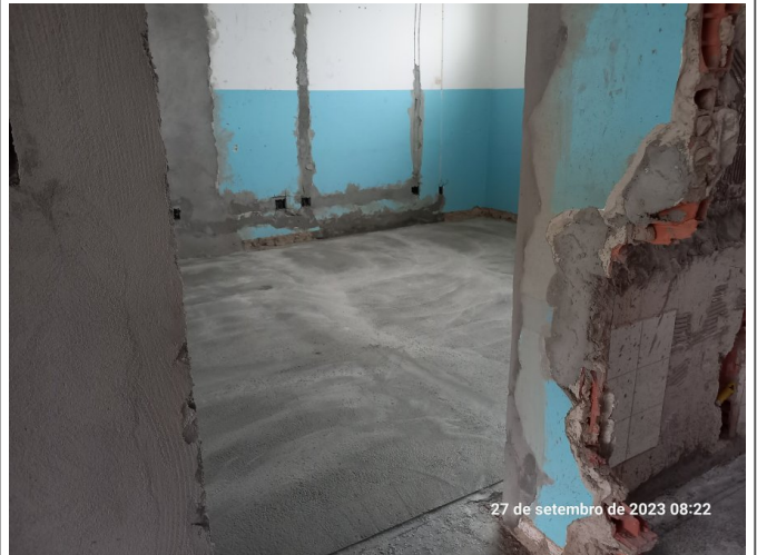
Execução do granilite no pavimento superior.
