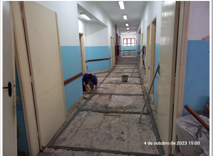
Execução da junta de dilatação do granilite do pavimento térreo.
