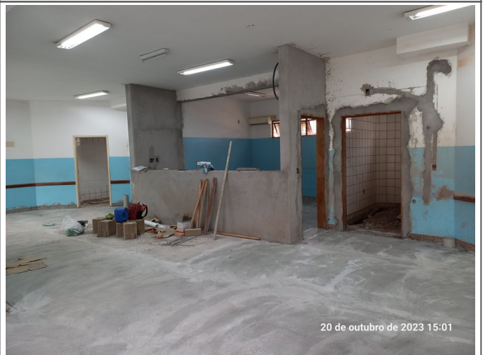
Execução do granilite no pavimento térreo.
