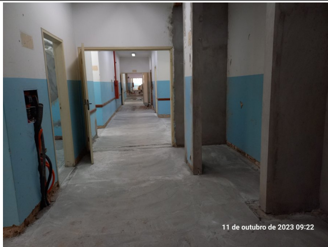
Granilite do pavimento térreo executado.
