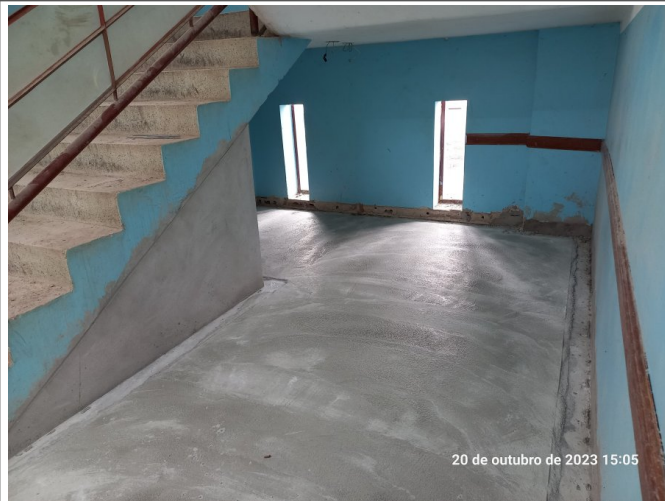
Execução do granilite no pavimento térreo.
