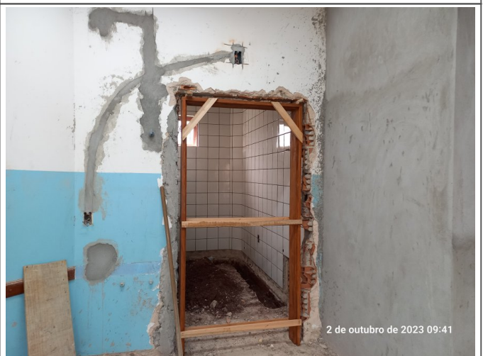
Instalação dos batentes das portas.
