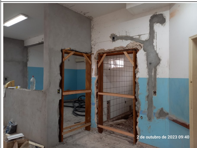
Instalação dos batentes das portas.
