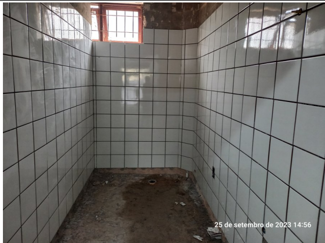
Execução de revestimento cerâmico nos sanitários do pavimento térreo.
