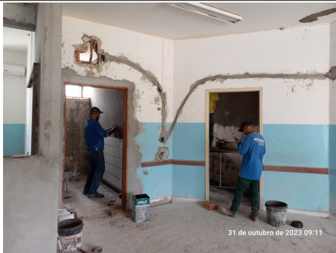
Execução do revestimento cerâmico no banheiro.
