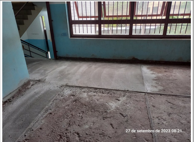
Execução do granilite no pavimento superior.
