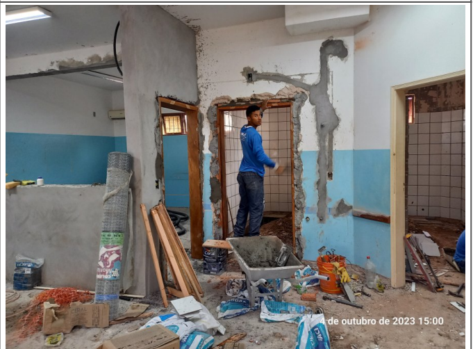
Instalação dos batentes das portas.
