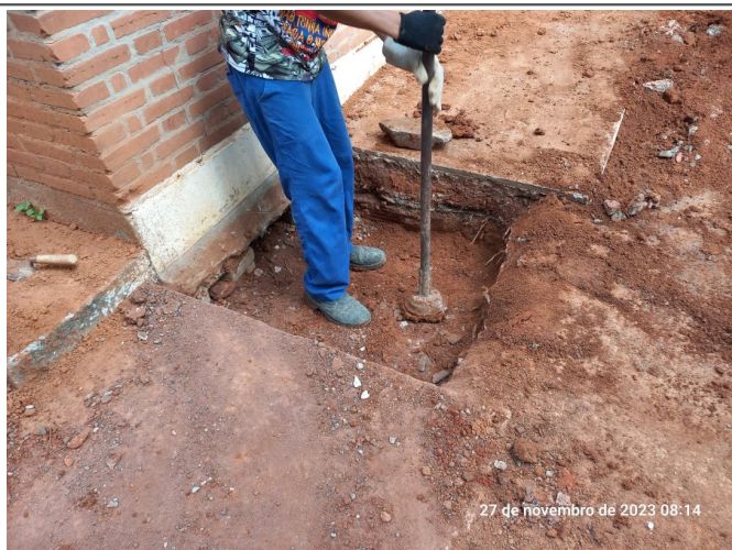
Reaterro e compactação após execução da estaca do tipo mega.
