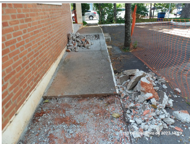
Demolição de calçada de concreto para abertura de vala para execução de estaca do tipo mega.
