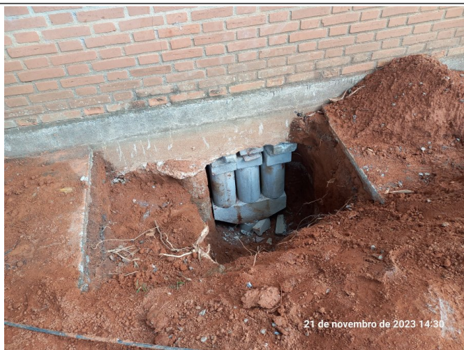
Estaca do tipo mega já cravada.
