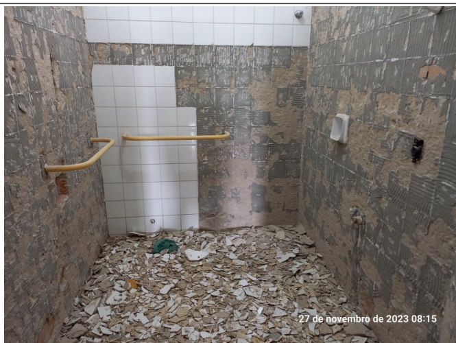
Remoção do revestimento cerâmico no sanitário PCD.
