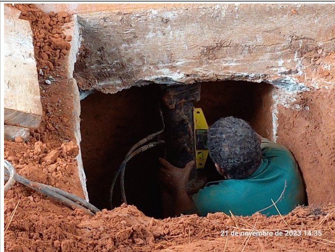
Verificação de nível durante o "macaqueamento" da estaca do tipo mega.
