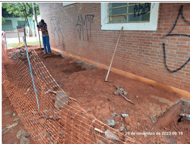
Execução da compactação das valas.
