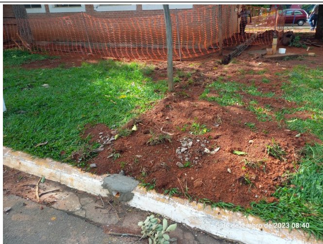
Instalação de dreno aos fundos.
