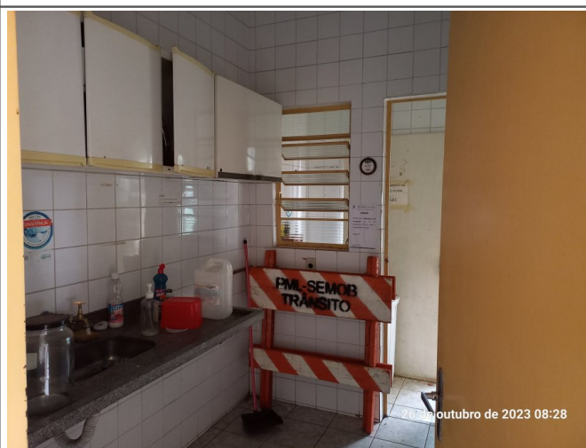
Situação atual do prédio do Departamento de Extensão Rural: cozinha.
