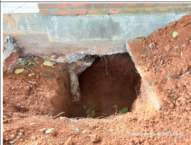
Detalhe de vala com presença de fundação do tipo estaca.
