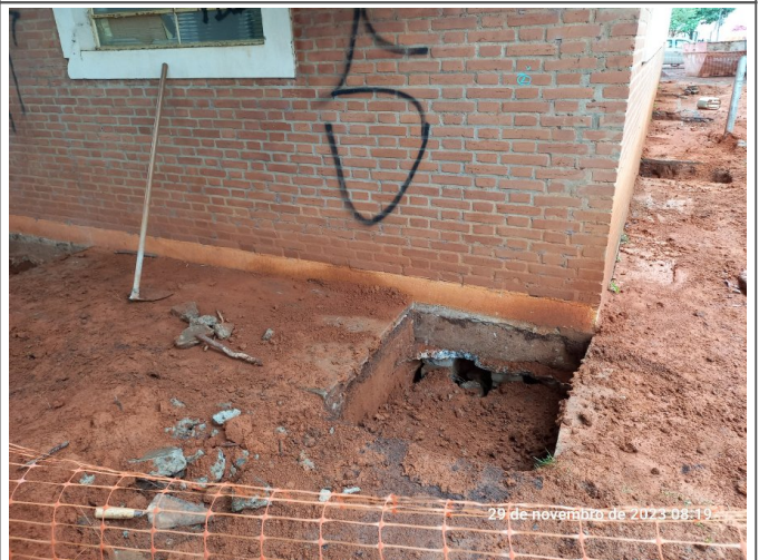
Execução da compactação das valas.
