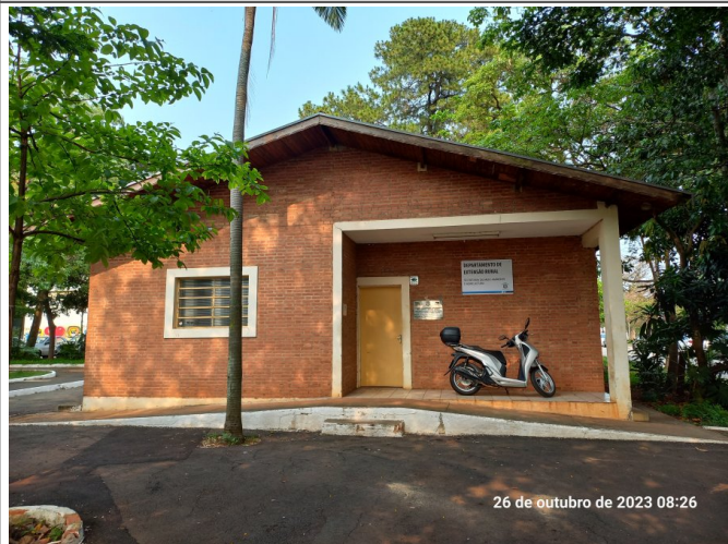
Situação atual do prédio do Departamento de Extensão Rural: fachada frontal.
