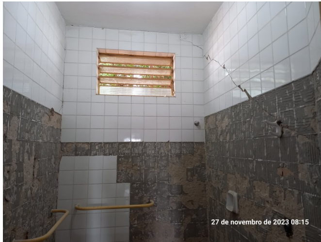
Remoção do revestimento cerâmico no sanitário PCD.
