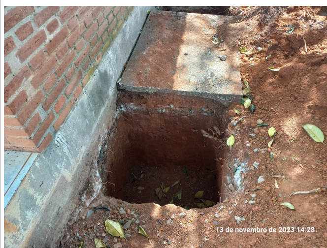
Abertura de vala para execução de estaca do tipo mega.
