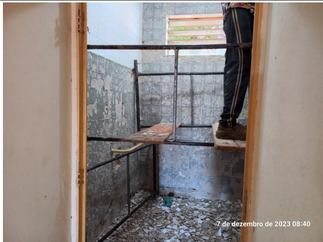
Demolição do revestimento cerâmico no sanitário PCD.
