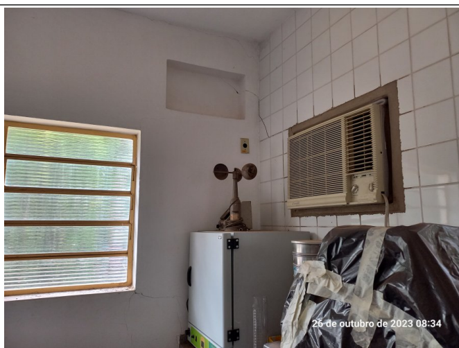
Trinca presente no laboratório.
