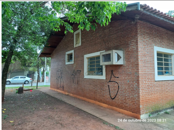
Situação atual do prédio do Departamento de Extensão Rural: fachada de fundo.
