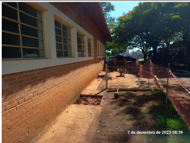
Montagem de forma para concretagem da calçada lateral.
