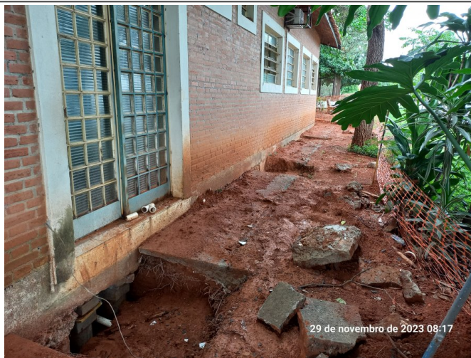
Execução da compactação das valas.
