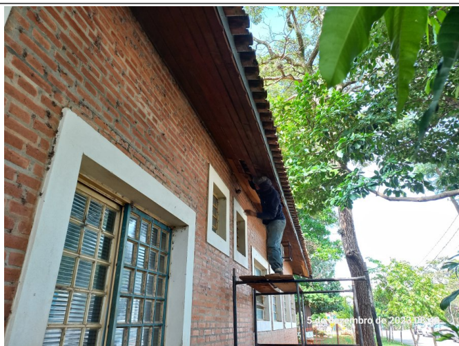
Substituição de forro de madeira deteriorado.
