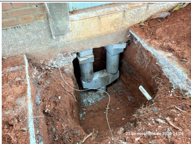
Estaca do tipo mega já cravada.
