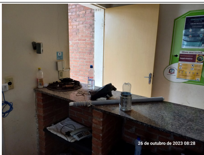
Situação atual do prédio do Departamento de Extensão Rural: recepção.
