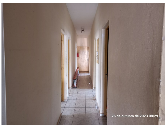
Situação atual do prédio do Departamento de Extensão Rural: corredor.
