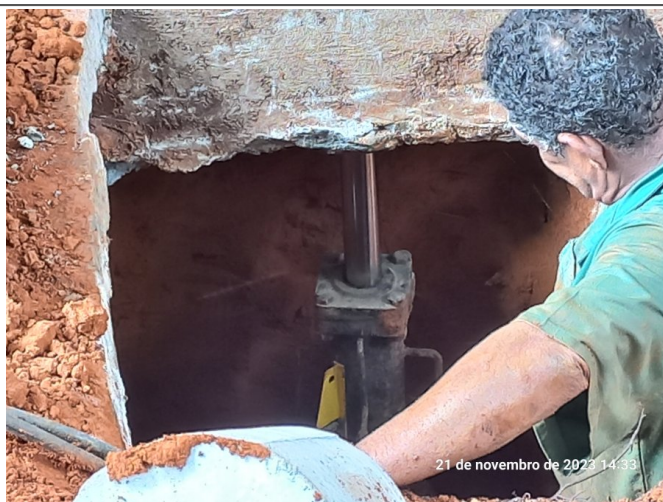
"Macaqueamento" da estaca do tipo mega.
