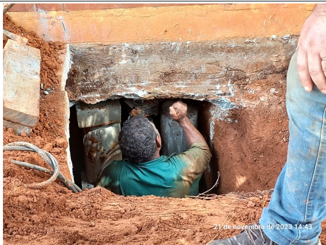
Travamento da estaca do tipo mega.
