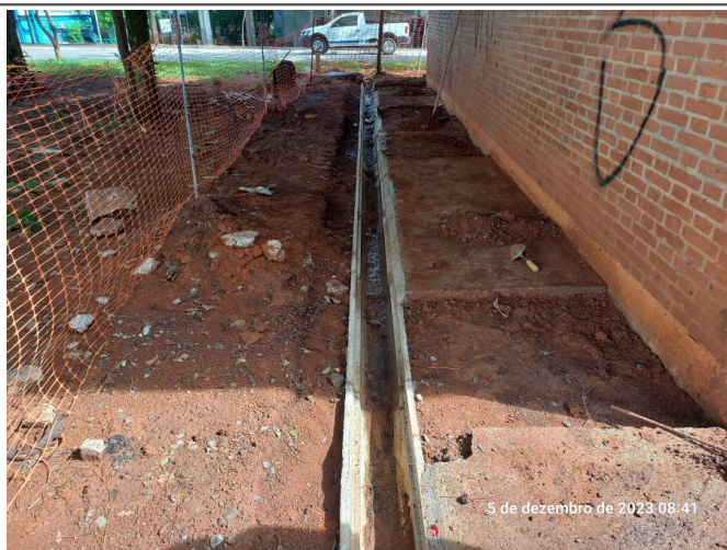
Instalação de dreno aos fundos.
