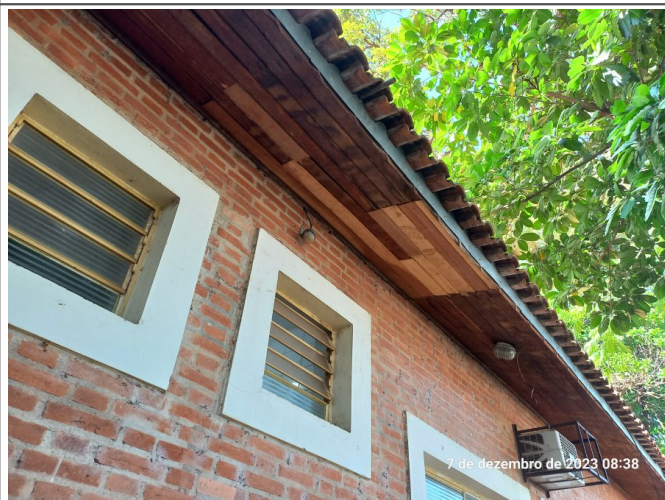
Substituição do forro de madeira que estava danificado.
