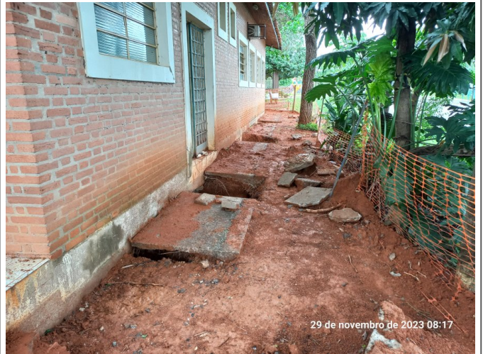
Execução da compactação das valas.
