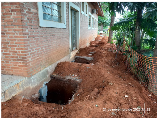
Início da cravação da estaca do tipo mega.
