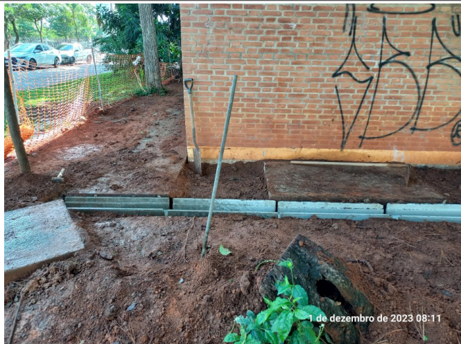
Instalação de dreno aos fundos.
