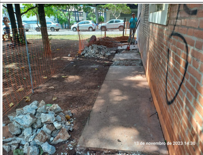
Demolição de calçada de concreto para abertura de vala para execução de estaca do tipo mega.
