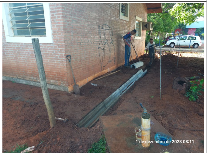
Instalação de dreno aos fundos.
