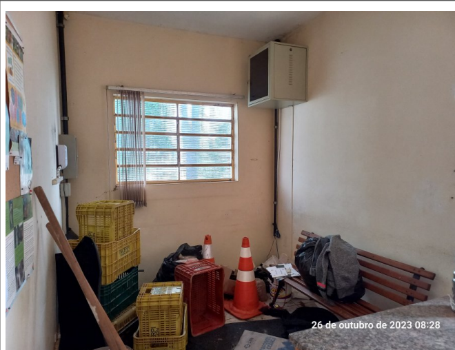
Situação atual do prédio do Departamento de Extensão Rural: recepção.
