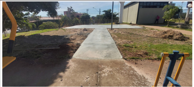
Rua José Aparecido Campanini (Centro Esportivo)- Jd. Roseira - (Concretagem da base)
