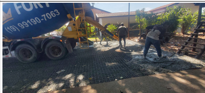
Rua Chico Mendes - Jd. Ernesto Kuhl - (Espalhamento do Concreto)
