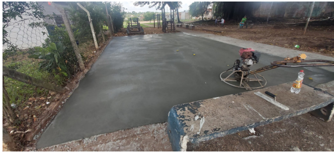
Rua Chico Mendes - Jd. Ernesto Kuhl - (Nivelamento e acabamento do piso com acabadora de superfície)
