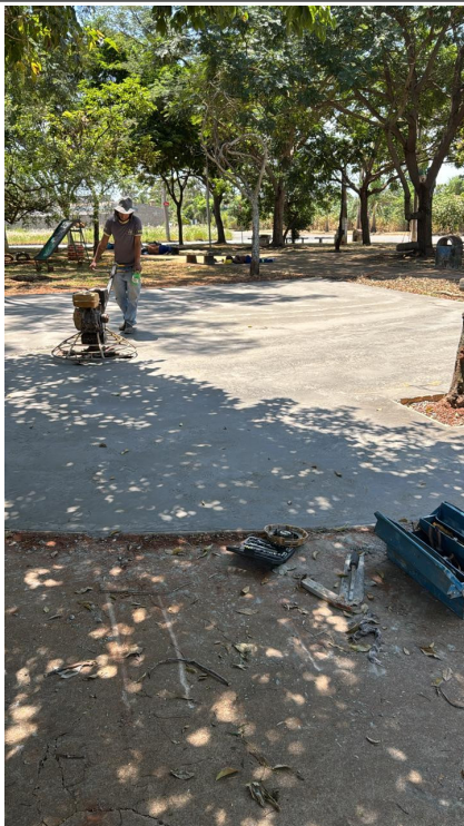
Rua Marina Moraes Elias - Jd. Palmeira Real - (Execução de nivelamento e acabamento do piso com acabadora de superfície)
