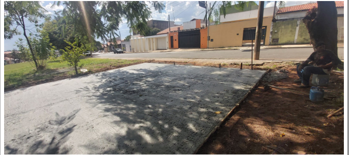
Rua Hia Rosenthal Spilberg - Jd. Graminha - (Execução de concretagem da base)
