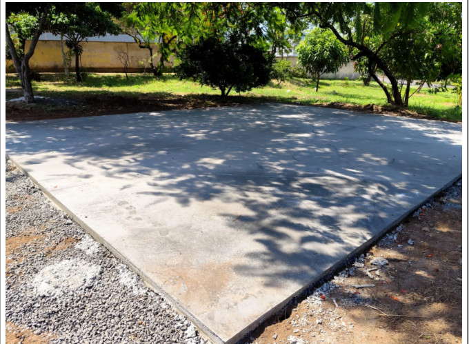
Rua Hia Rosenthal Spilberg - Jd. Graminha - (Execução de junta de dilatação)
