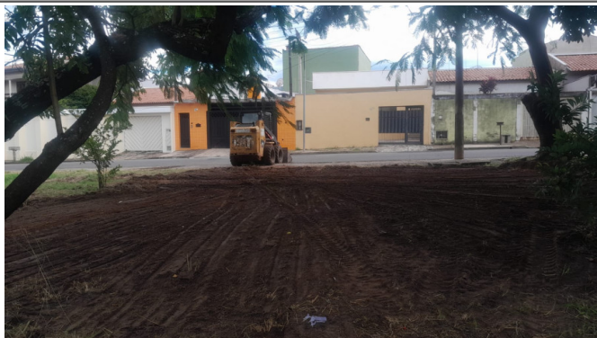
Rua Hia Rosenthal Spilberg - Jd. Graminha - (Execução de limpeza e regularização do terreno)
