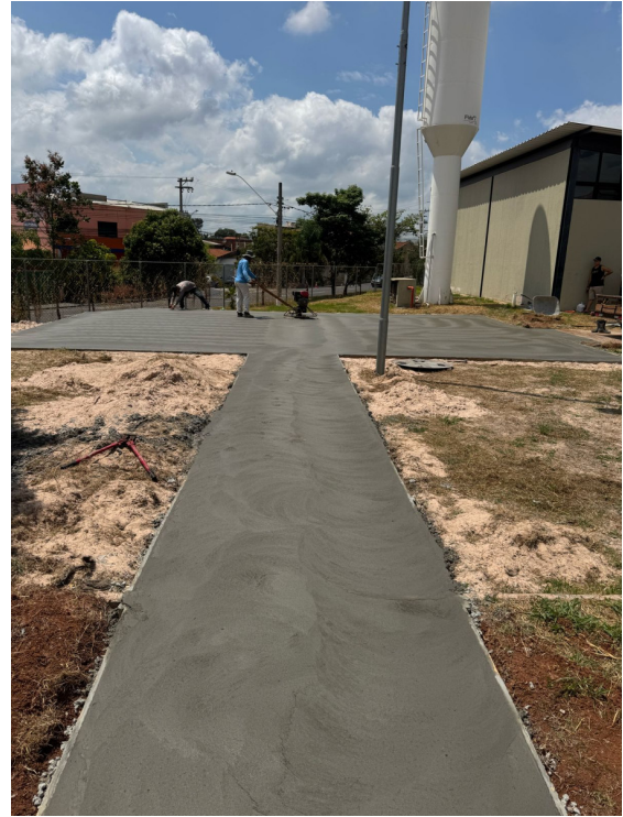
Rua José Aparecido Campanini (Centro Esportivo)- Jd. Roseira - (Concretagem da base)
