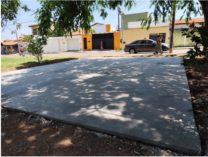
Rua Hia Rosenthal Spilberg - Jd. Graminha - (Execução de concretagem da base)
