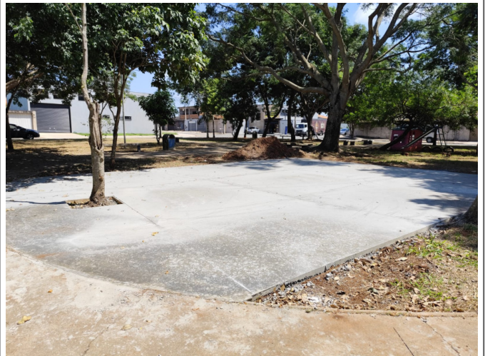
Rua Marina Moraes Elias - Jd. Palmeira Real - (Execução de junta de dilatação)
