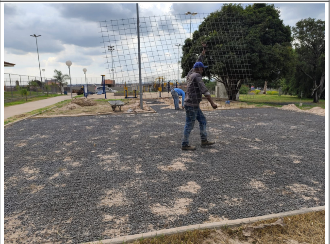
Rua José Aparecido Campanini (Centro Esportivo)- Jd. Roseira -(Camada de brita e Tela de aço)
