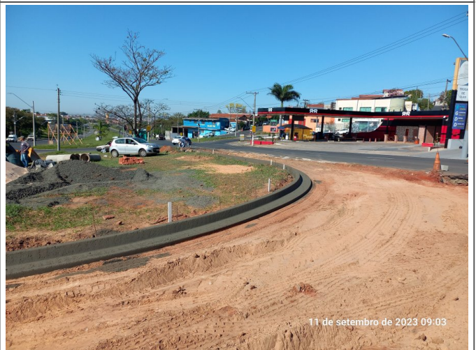
Execução de guia moldada in loco no canteiro central.
