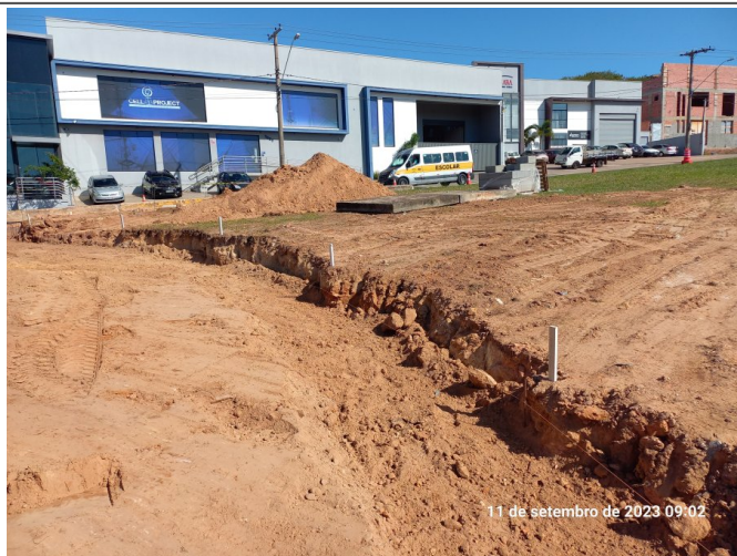
Locação do retorno em canteiro central.
