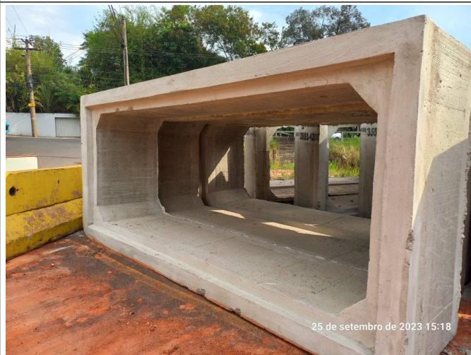
Aduelas com seção interna de 1,50 m x 4,00 m.
