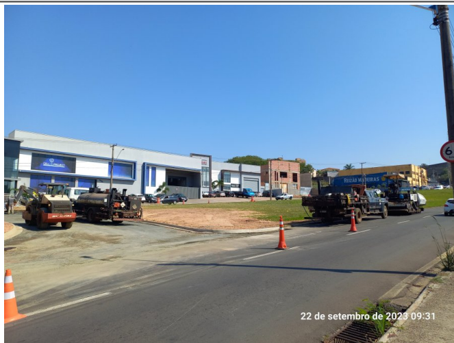
Execução do CBUQ do pavimento do retorno no canteiro central da via Luís Varga.
