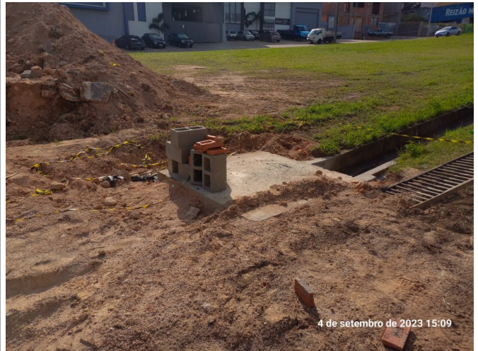
Execução de Poço de Visita (PV).
