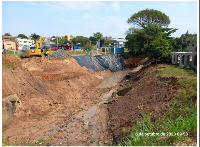
Escavações para instalação das aduelas.
