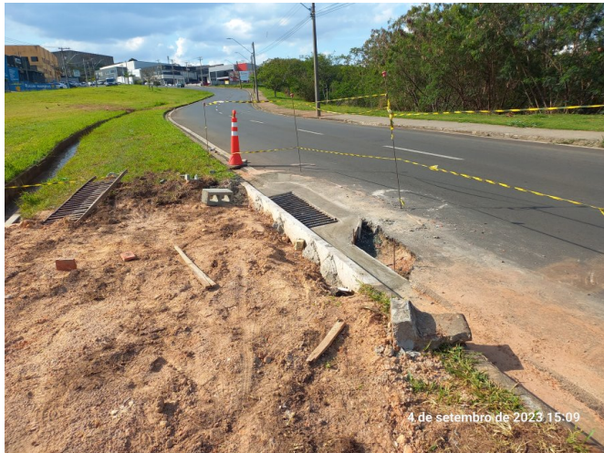
Execução de Boca de Lobo (BL).
