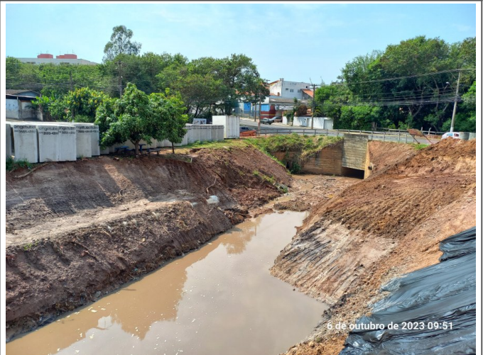
Escavações para instalação das aduelas.
