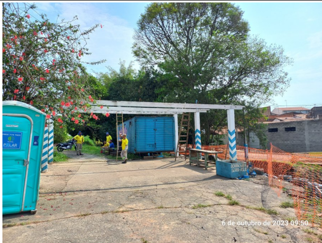
Remoção da estrutura da borracharia.
