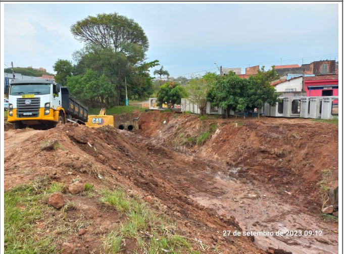
Movimentação de solo na travessia.
