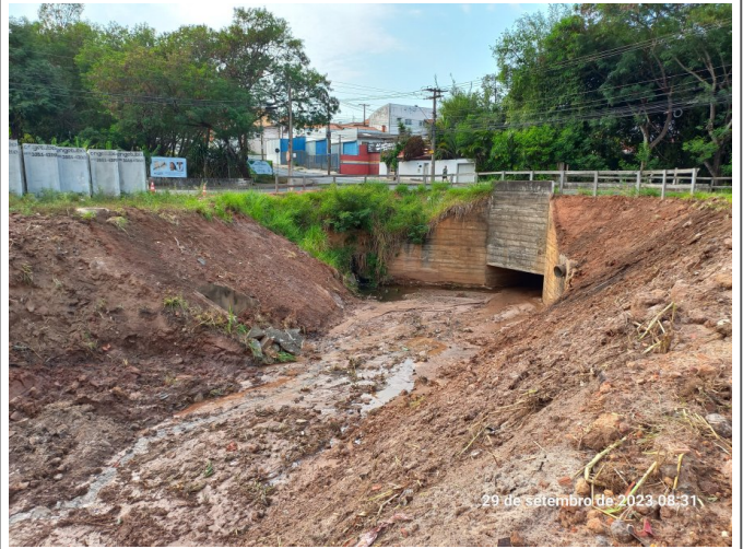
Movimentação de solo para instalação das aduelas.
