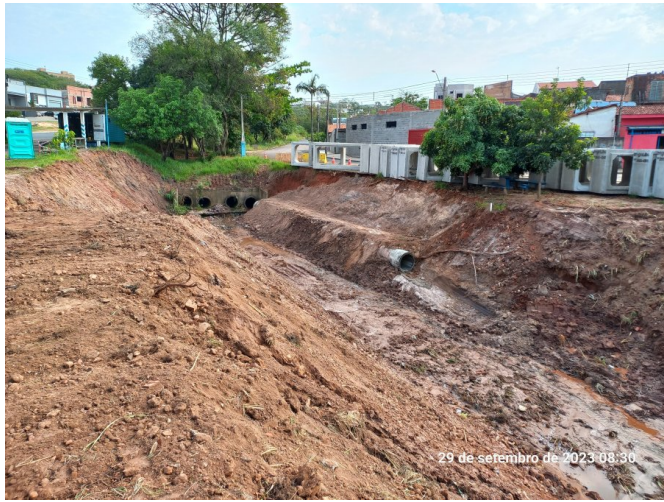
Movimentação de solo para instalação das aduelas.
