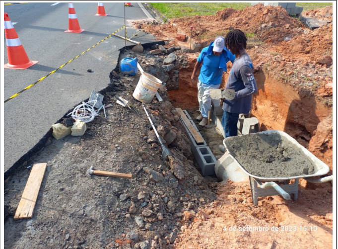
Construção de BL para adequação do sistema existente.
