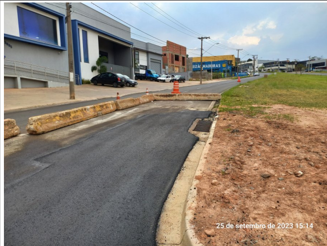
Lançamento de CBUQ no retorno.
