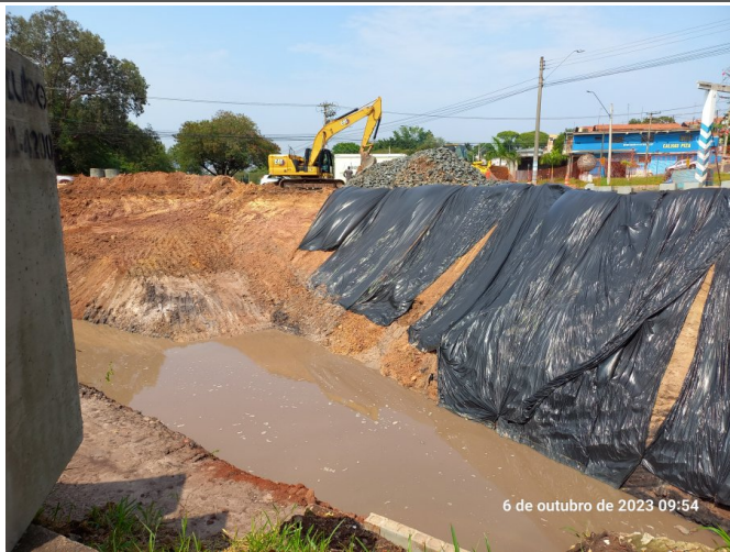
Escavações para instalação das aduelas.
