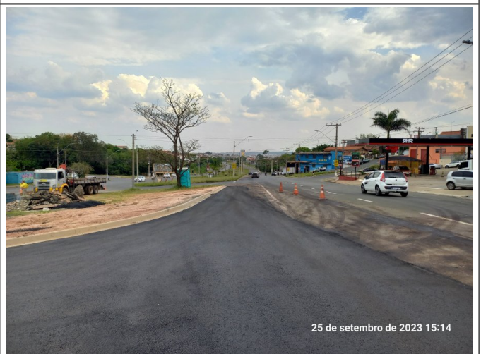
Lançamento de CBUQ no retorno.
