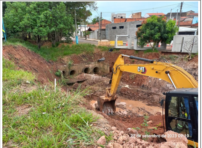
Movimentação de solo na travessia (tubulações de drenagem a serem substituídas por aduela).
