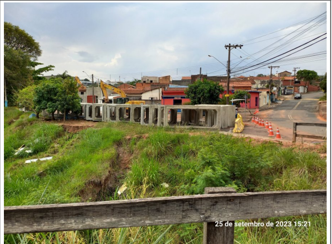
Interdição de parte da rua para disposição das aduelas, num total de 39.
