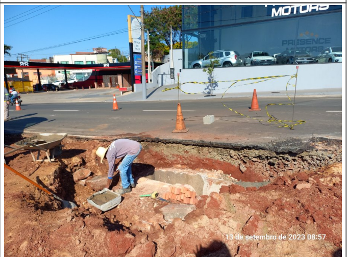
Execução de PV.
