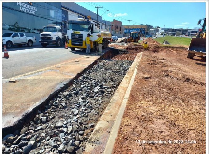
Lançamento de ração para base de pavimento.
