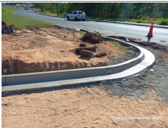
Execução de guia moldada in loco no canteiro central.
