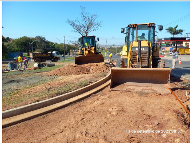
Abertura de caixa para pavimentação.
