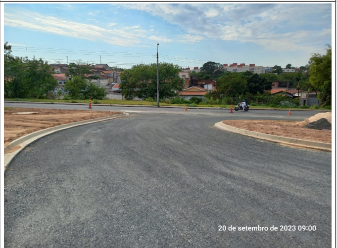
Base do pavimento do retorno no canteiro central da via Luís Varga.
