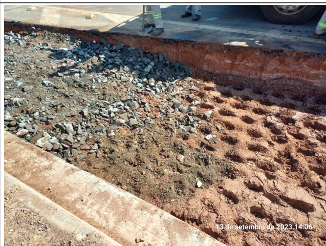
Compactação do solo e lançamento de ração para base de pavimento.
