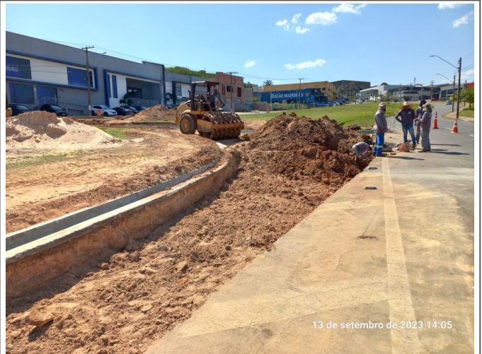
Abertura de caixa para pavimentação.
