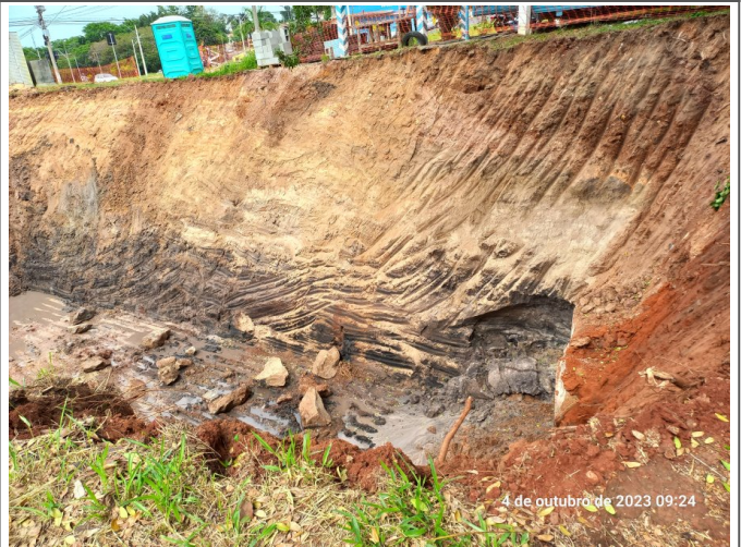
Movimentação de solo para instalação das aduelas.
