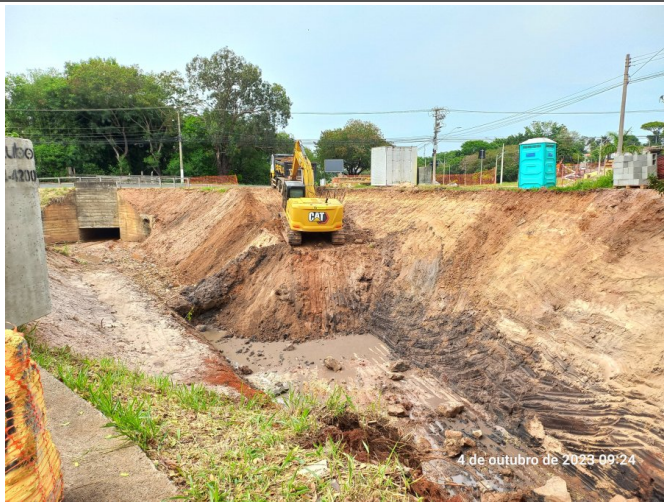
Movimentação de solo para instalação das aduelas.
