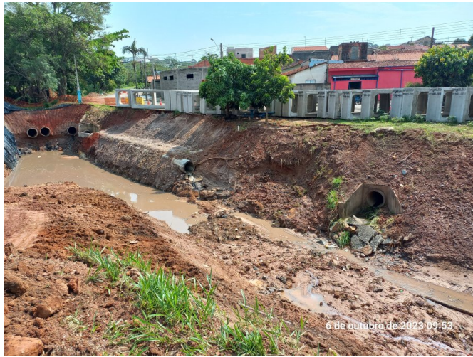
Canalização temporária de córrego para instalação das aduelas.
