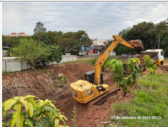
Movimentação de solo na travessia.
