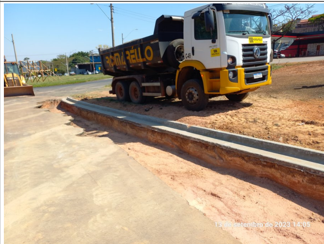
Abertura de caixa para pavimentação.
