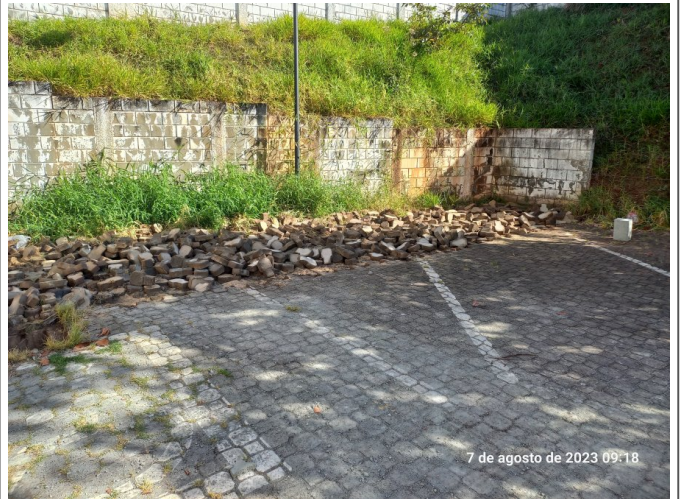
Remoção do pavimento intertravado aos fundos.
