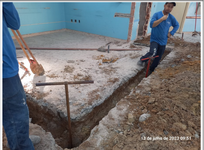
Abertura de vala para fundação no pavimento térreo.
