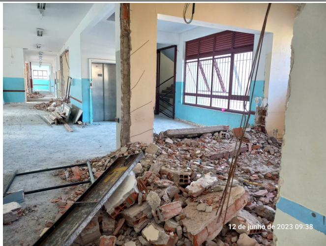
Remoção de parede no pavimento superior.
