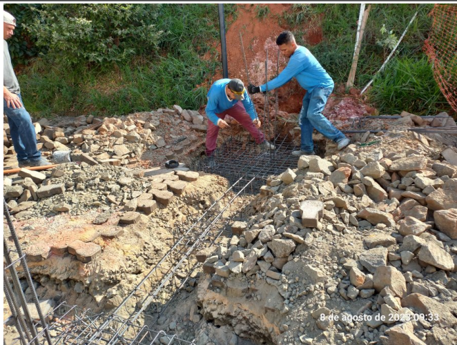
Execução de sapata de fundação para muro na área externa.
