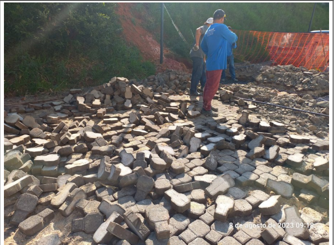
Remoção do pavimento intertravado aos fundos.
