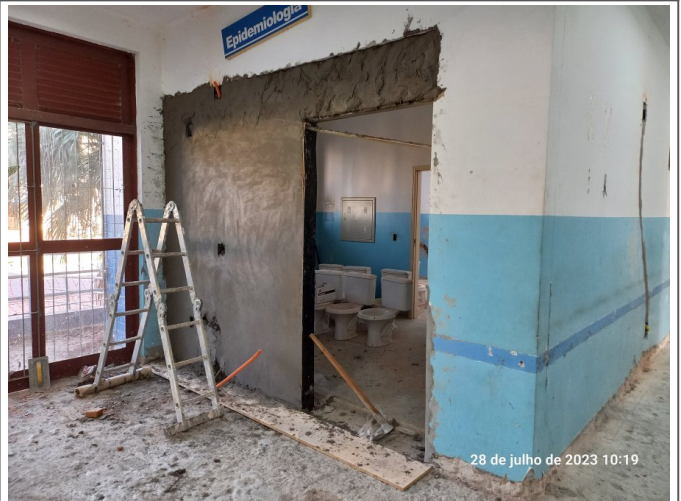
Reboco na parede de fechamento do pavimento térreo.
