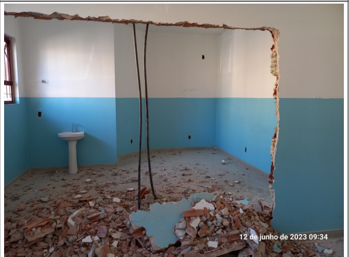
Remoção de parede no térreo.
