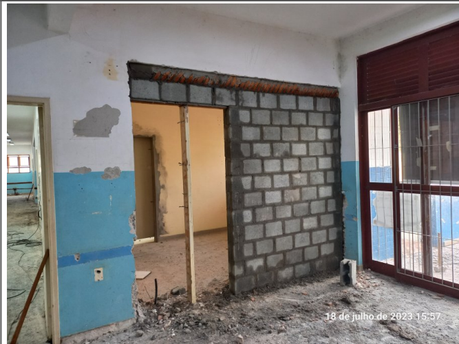
Fechamento de parede no pavimento térreo.
