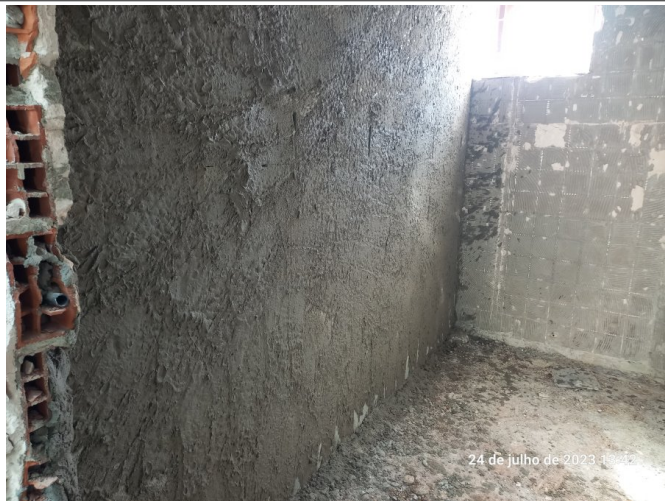
Chapisco e reboco na parede de fechamento do pavimento térreo.
