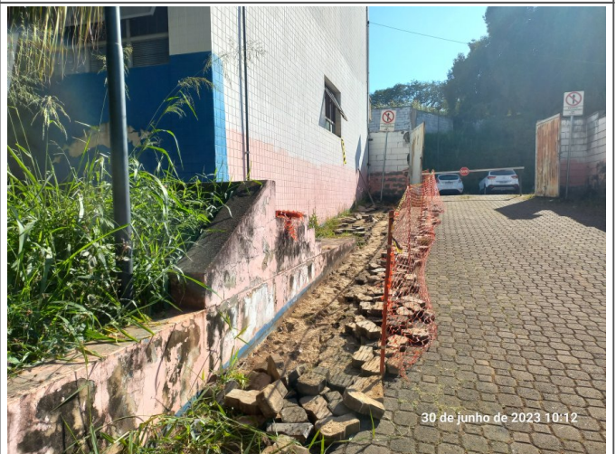
Abertura de vala para aterramento com cordoalha de cobre.
