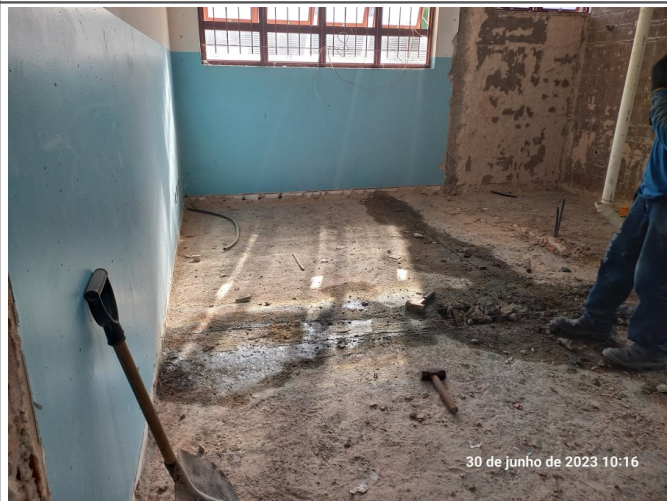
Abertura de vala para realização de fundação (estaca do tipo broca e viga baldrame).
