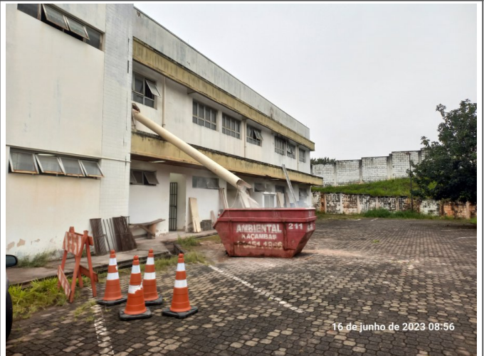
Tubo instalado para remoção de entulho do pavimento superior.
