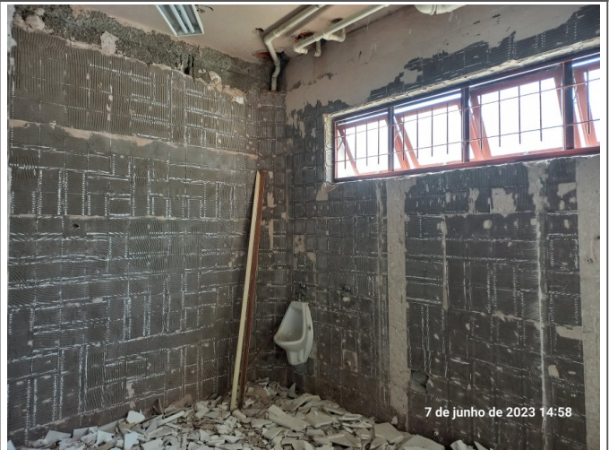
Remoção do revestimento cerâmico dos sanitários.
