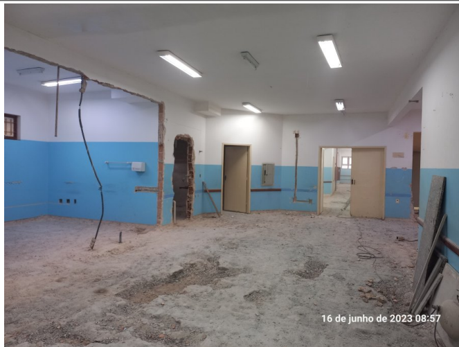
Térreo com entulho removido.
