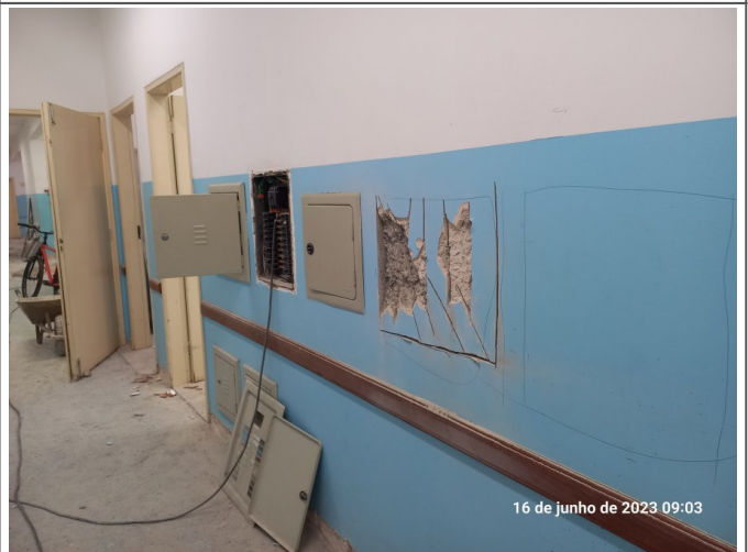
Corte em parede para instalação do quadro de distribuição.
