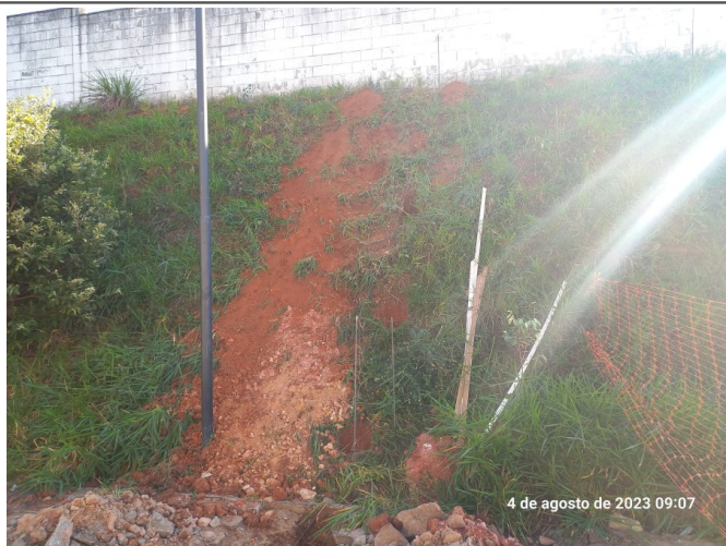
Escavação para execução da fundação na área do fundo.
