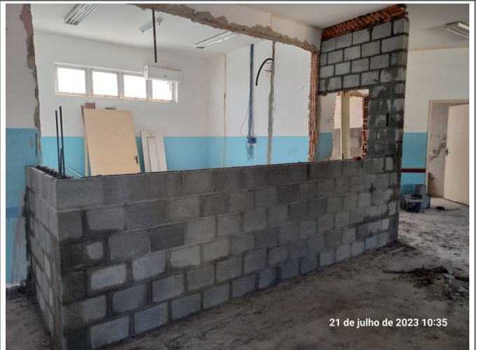
Fechamento de parede no pavimento superior.
