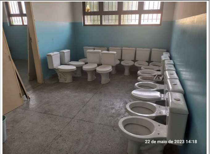
Remoção de louças cerâmicas.
