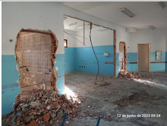
Remoção de parede no térreo.
