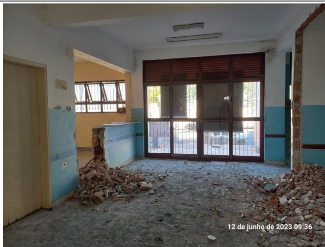
Demolição no térreo.
