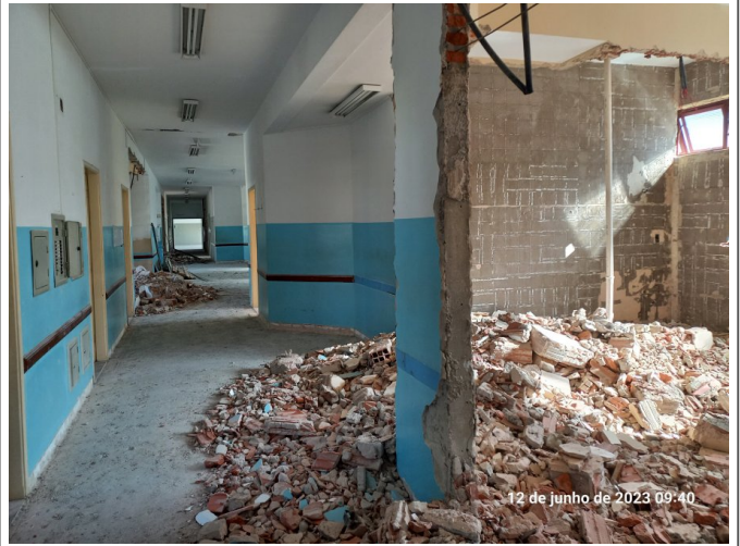
Remoção de parede no pavimento superior.
