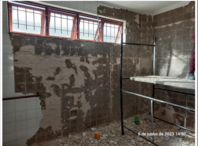
Remoção do revestimento cerâmico dos sanitários.
