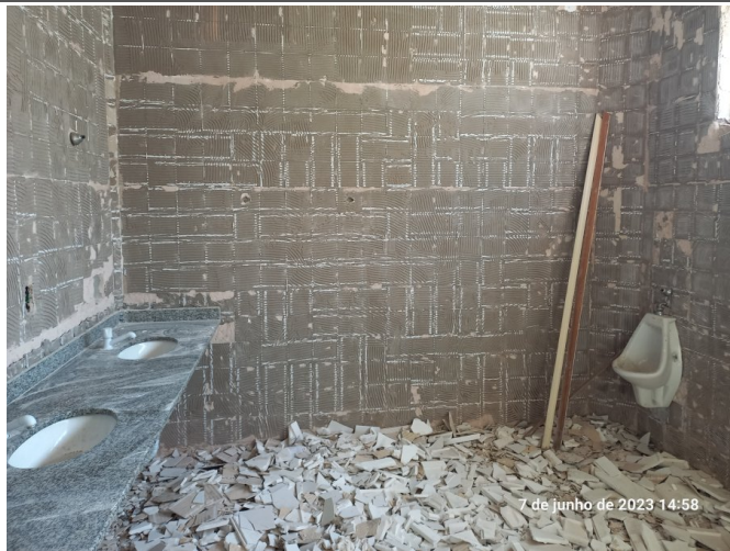
Remoção do revestimento cerâmico dos sanitários.
