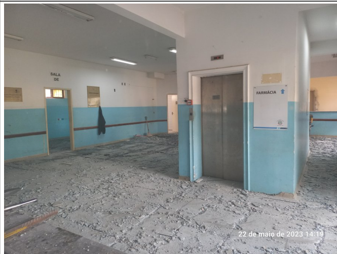
Remoção do piso granilite no térreo.
