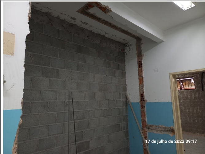
Fechamento de parede no pavimento térreo.
