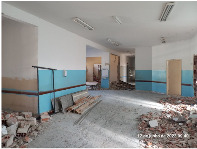
Demolição no pavimento superior.
