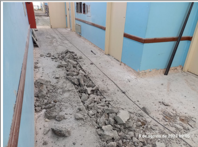
Corte de contrapiso do pavimento térreo para locação de eletroduto do sistema de cabeamento estruturado.
