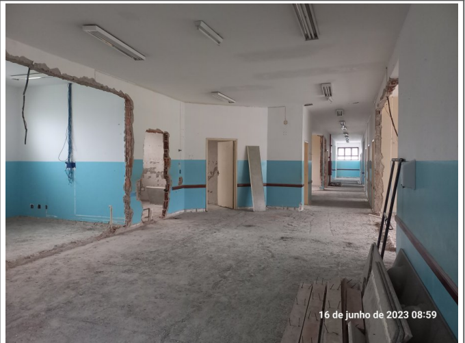
Pavimento superior com entulho removido.
