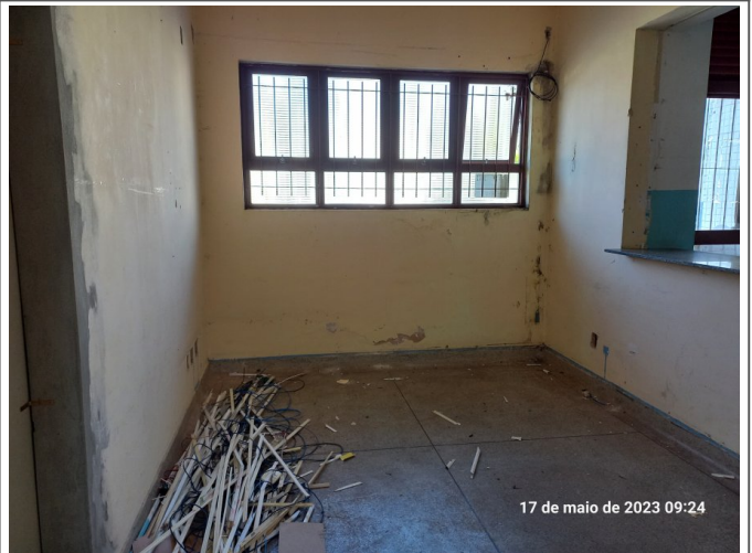
Remoção de tomadas e canaletas externas.
