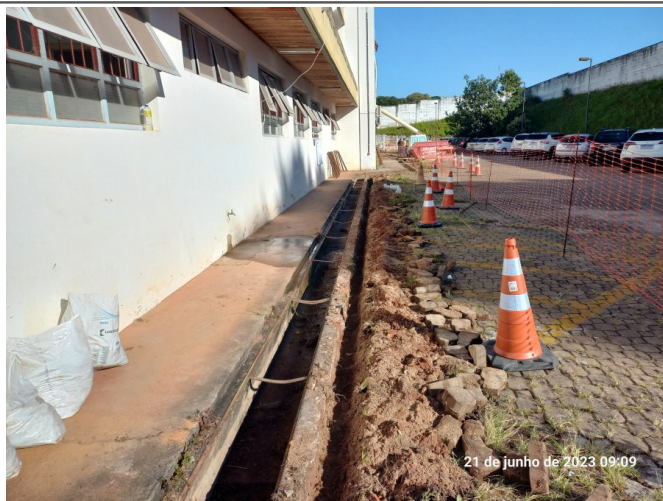
Abertura de vala para aterramento com cabo de cobre.
