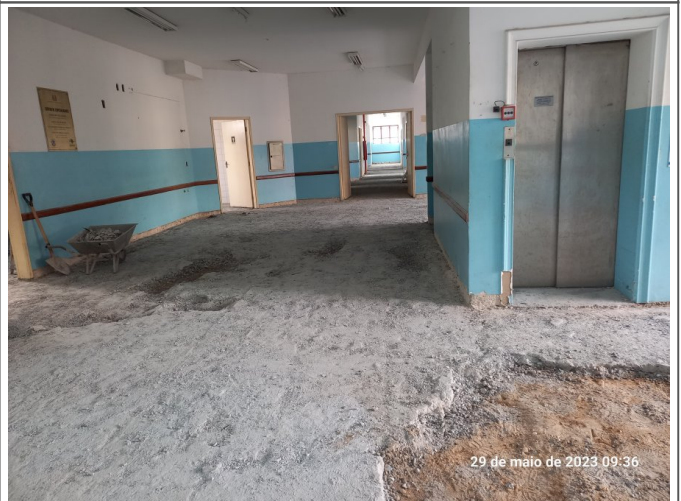
Remoção do piso granilite no térreo.
