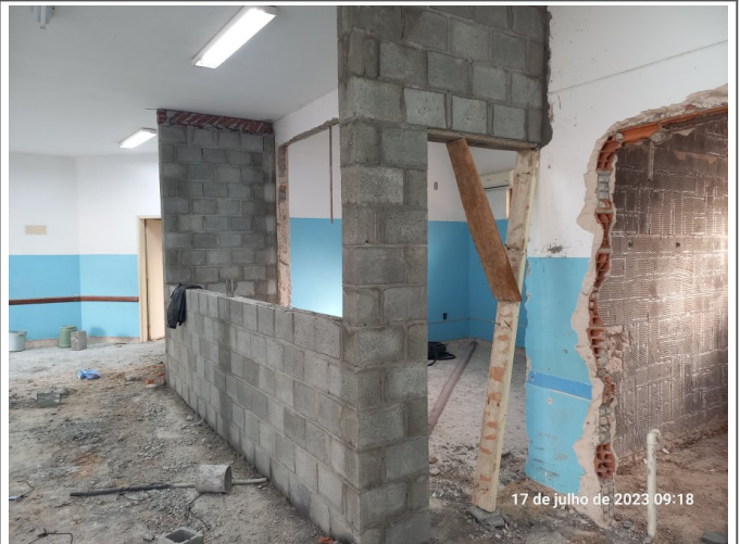
Fechamento de parede no pavimento térreo.
