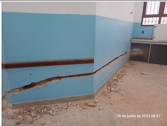
Corte de parede para instalação da rede elétrica.
