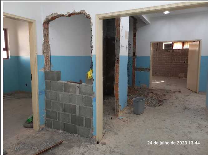
Fechamento de parede no pavimento térreo.
