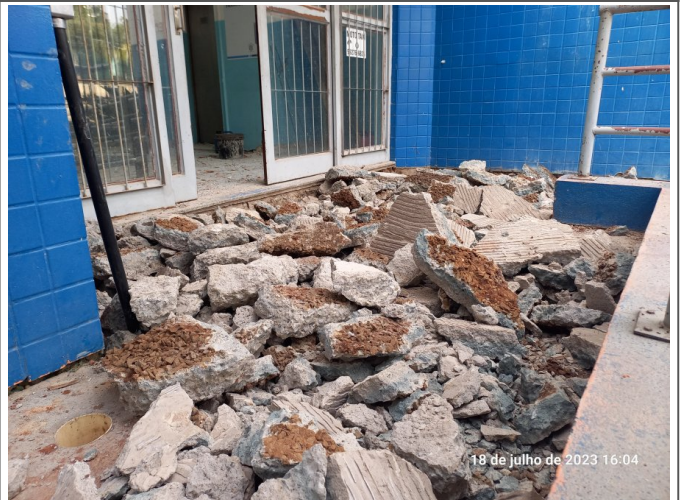
Demolição de piso cerâmico e concreto na entrada da edificação.
