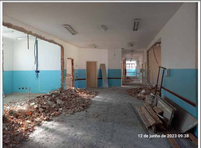
Demolição no pavimento superior.
