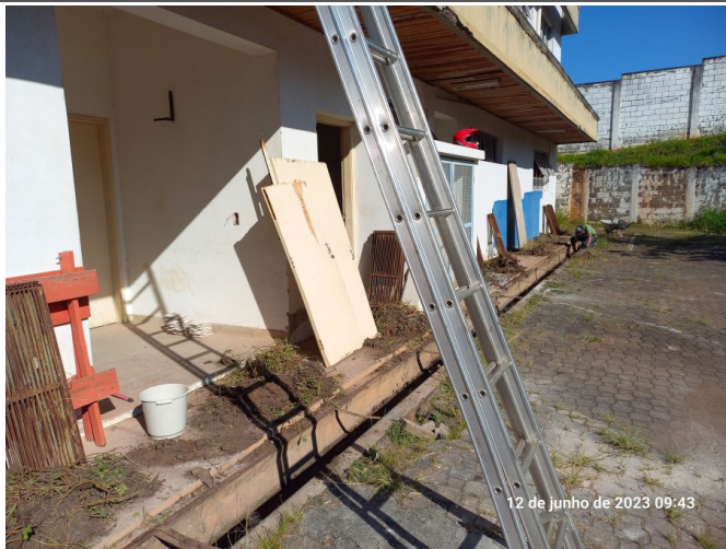
Limpeza de calha de drenagem de água pluvial.
