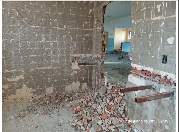
Remoção de parede, revestimento cerâmico e bancada em banheiro do térreo.
