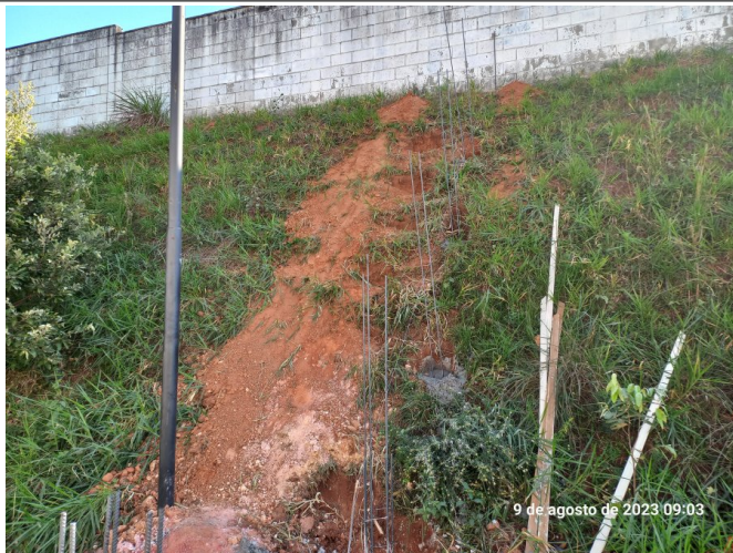
Execução de estaca para fundação do alambrado em talude aos fundos.
