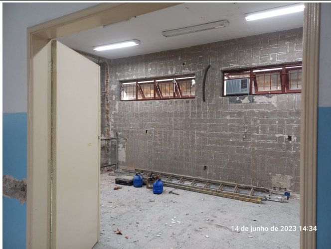
Remoção de revestimento cerâmico.
