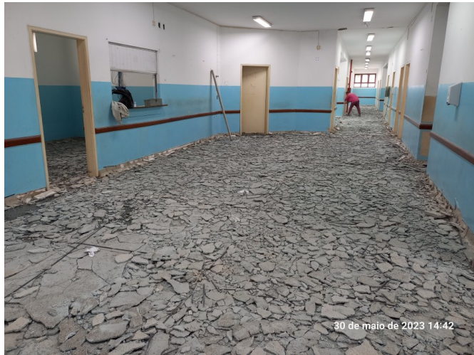
Remoção do piso granilite no piso superior.
