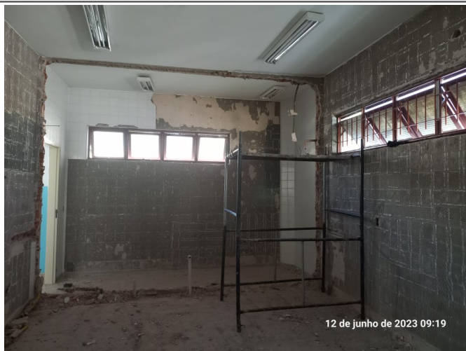
Remoção de parede no térreo.
