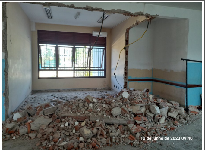
Remoção de parede no pavimento superior.
