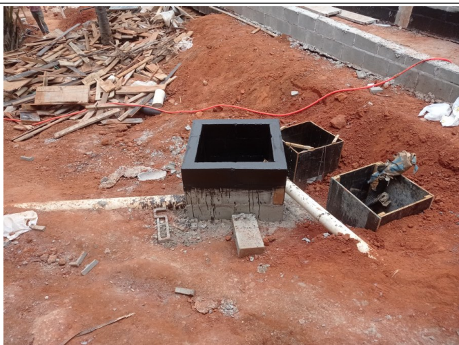
Caixa de esgoto
