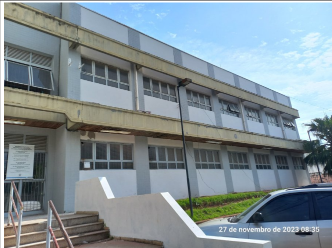
Execução da pintura da fachada.
