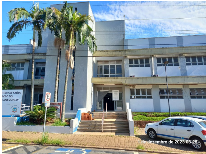
Execução da pintura da fachada.
