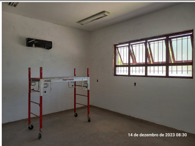
Execução da massa corrida nas paredes construídas.
