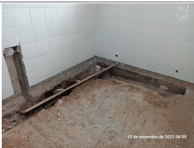
Execução da instalação hidráulica de esgoto predial.
