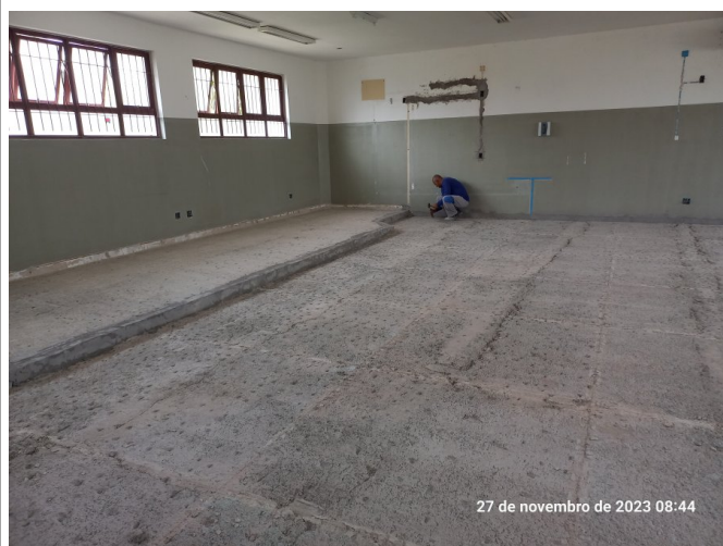
Execução de rugosidade para lançamento do granilite.
