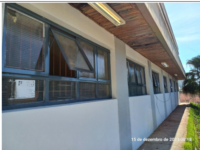
Início da pintura das esquadrias.
