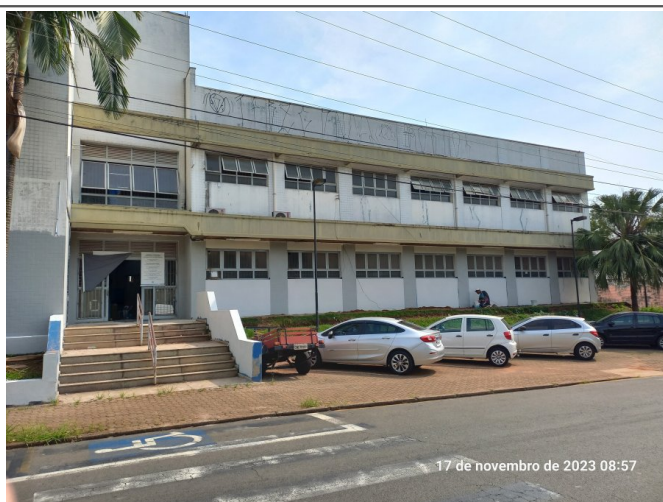
Início da pintura da fachada frontal.
