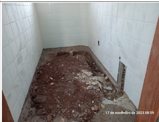
Execução da instalação hidráulica de esgoto predial.
