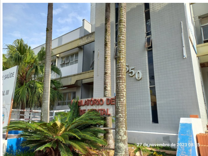
Execução da pintura da fachada.
