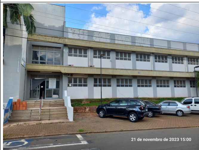
Início da pintura da fachada frontal.
