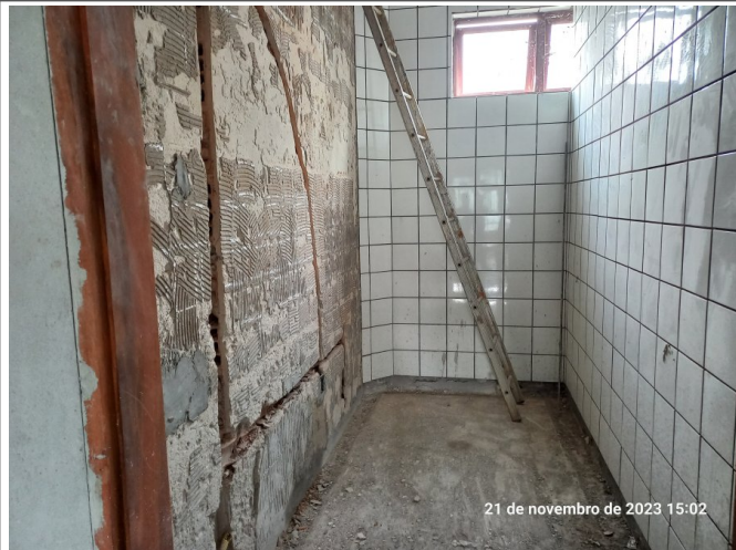
Execução da instalação hidráulica de água fria e de esgoto.
