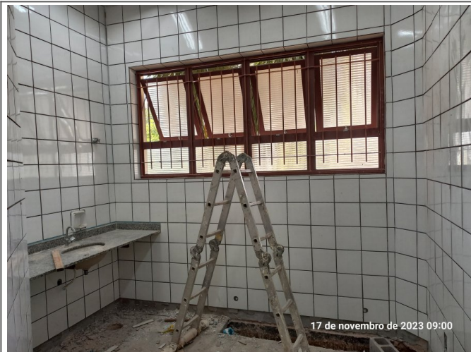
Execução do revestimento cerâmico.
