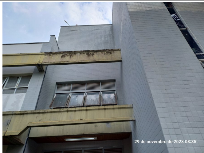
Execução da pintura da fachada.
