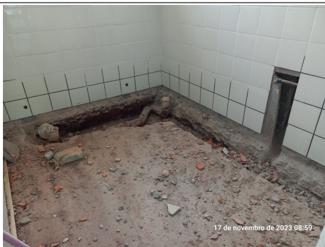
Execução da instalação hidráulica de esgoto predial.
