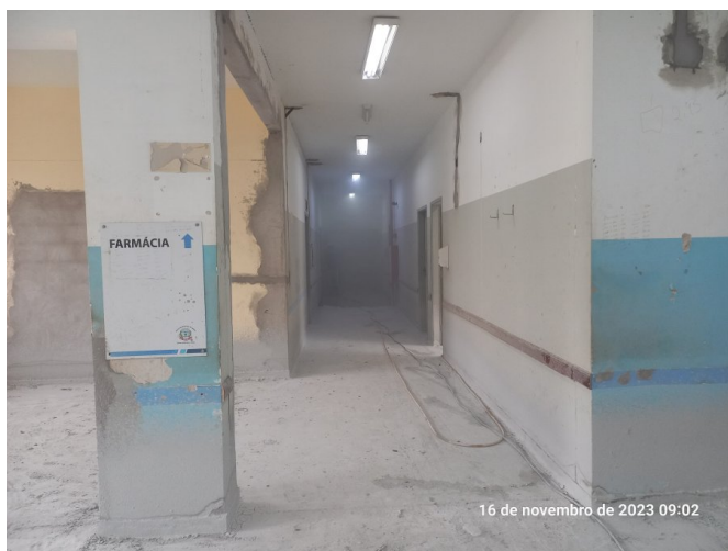
Polimento do granilite no pavimento superior.
