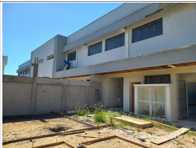
Pintura da fachada de fundo.
