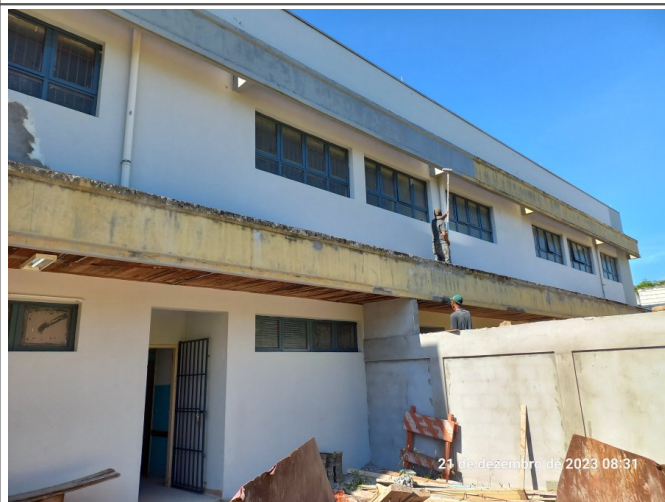
Pintura da fachada de fundo.
