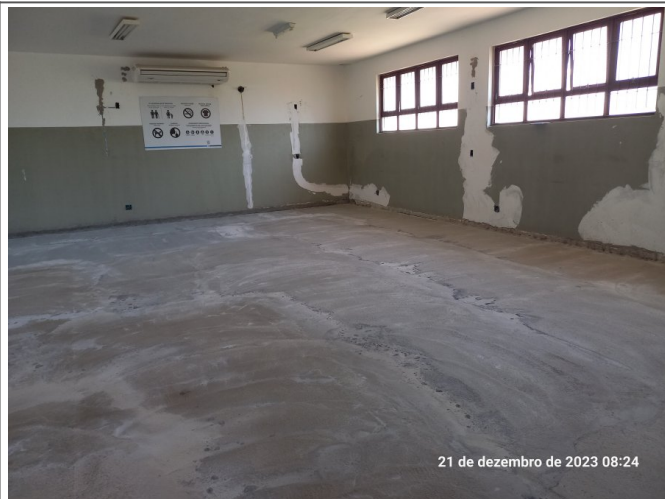
Execução do granilite na área da farmácia.
