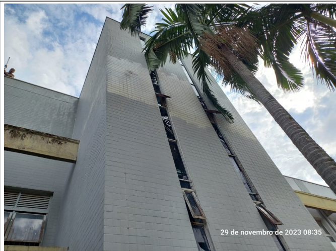
Execução da pintura da fachada.
