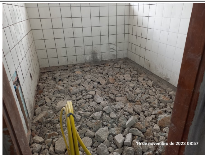
Demolição do contrapiso para execução da instalação hidráulica de esgoto predial.
