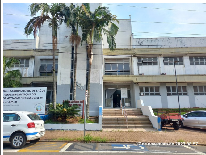
Início da pintura da fachada frontal.
