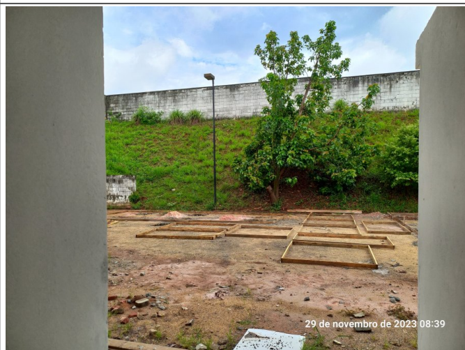
Marcação da área de concretagem ao fundo.
