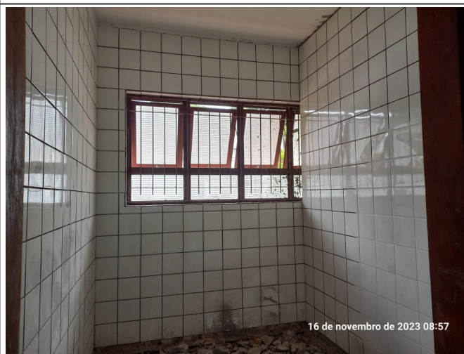
Execução do revestimento cerâmico.
