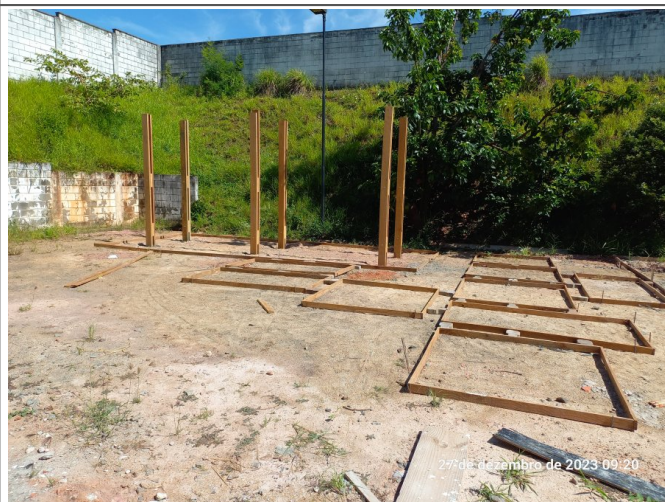
Execução do pergolado aos fundos.
