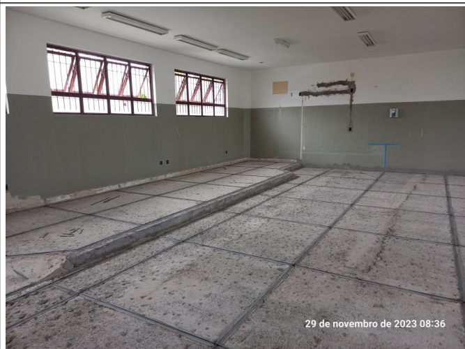
Marcação da junta de dilatação do granilite da área da farmácia.
