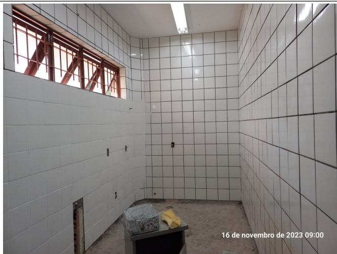
Execução do revestimento cerâmico.
