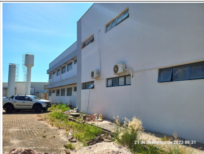
Pintura da fachada de fundo.
