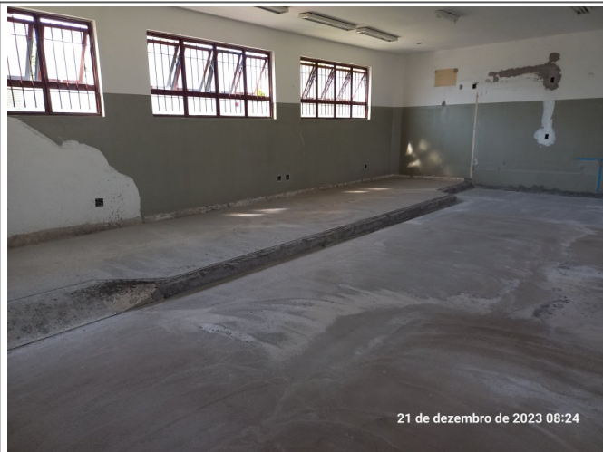
Execução do granilite na área da farmácia.
