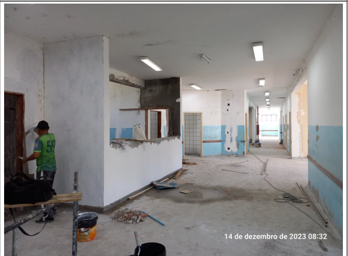
Execução da massa corrida nas paredes construídas.
