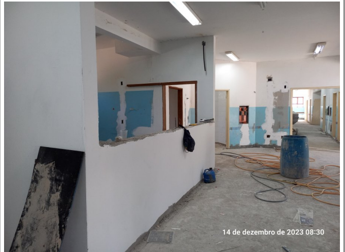
Execução da massa corrida nas paredes construídas.
