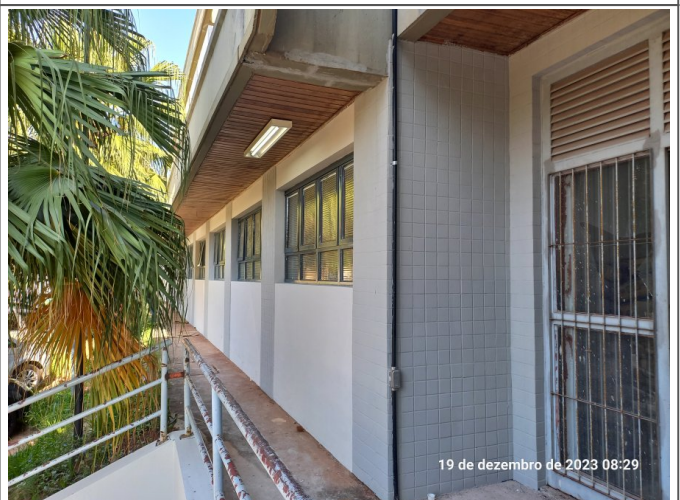
Pintura das esquadrias e fachada.
