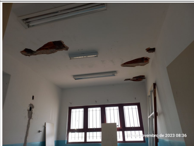
Furos na laje para execução da instalação hidráulica de esgotamento sanitário.
