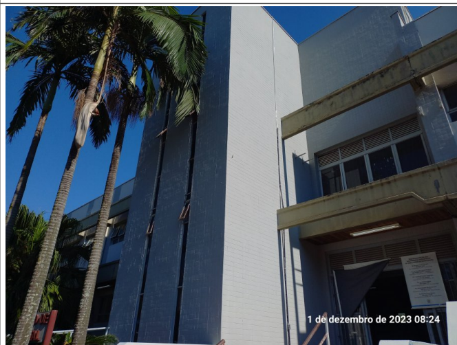
Execução da pintura da fachada.
