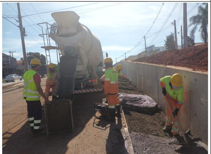
Canaletão em concreto armado modelo DER
