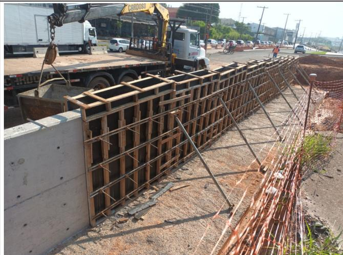
Forma de concreto de muro em L
