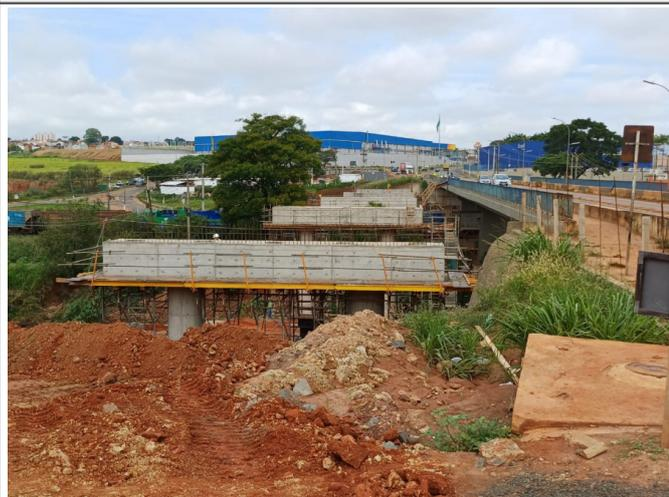
Travessas de concreto armado para apoio das longarinas
