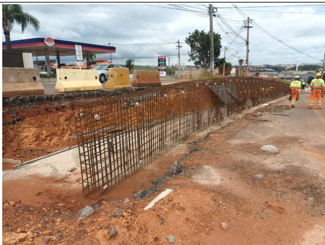
Muro em L em concreto armado
