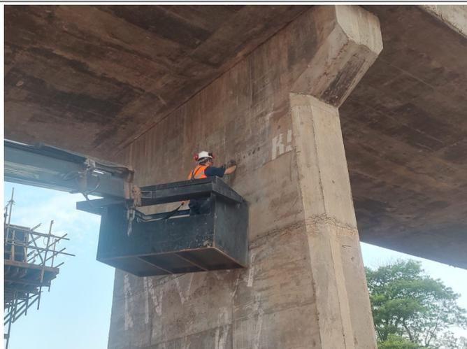
Análise de concreto e raio x de detecção de armadura do viaduto existente
