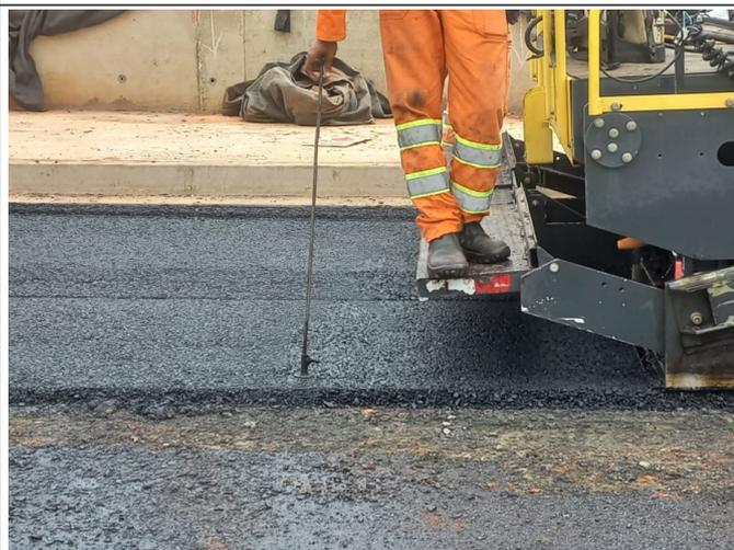
Pavimentação com controle de espessura.
