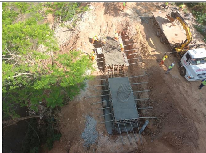
Concretagem de bloco de fundação
