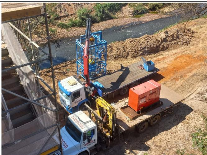
Teste dinâmico em estacas raiz
