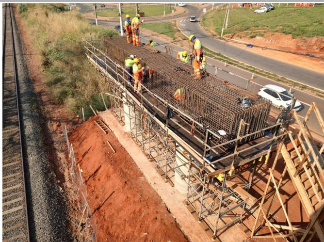
Travessa em concreto armado para apoio de vigas protendidas
