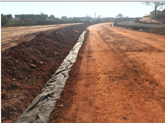
Dreno superficial para controle de umidade no subleito do pavimento
