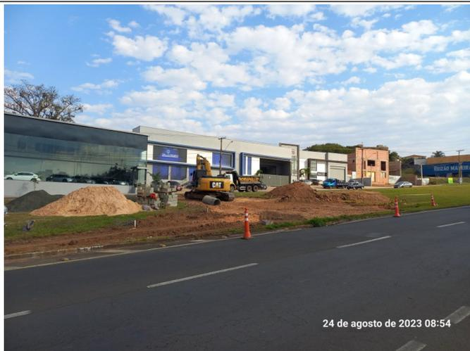
Escavação no canteiro central para instalação da rede de drenagem.
