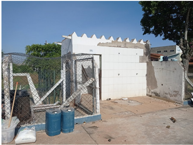
Demolição do depósito.
