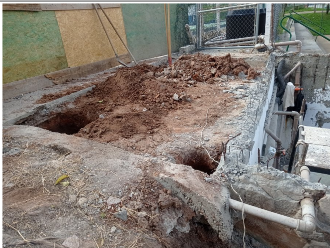
Execução da fundação.
