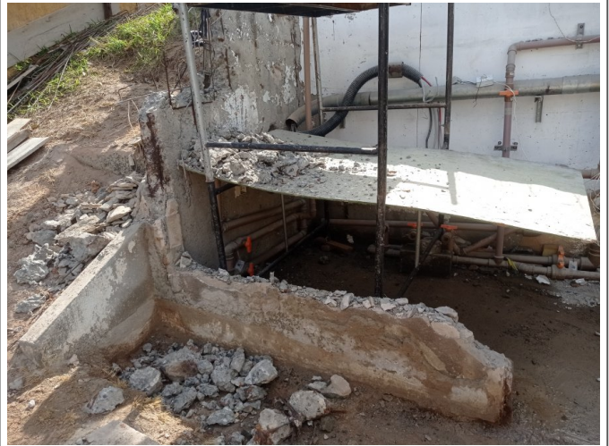
Demolição da casa de máquinas.
