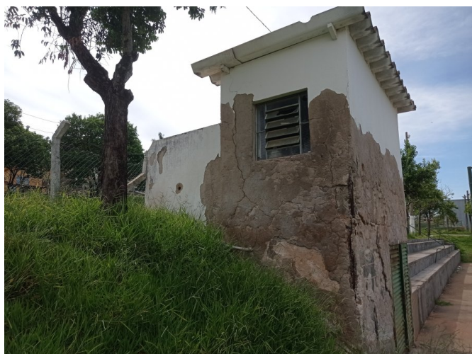
Vistoria do local da obra.
