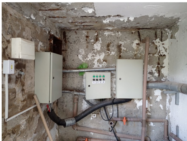
Vistoria do local da obra.
