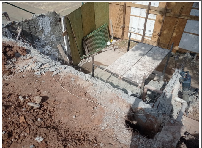
Execução da fundação.
