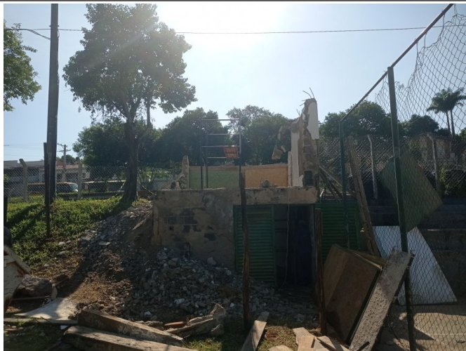
Demolição da casa de máquinas.
