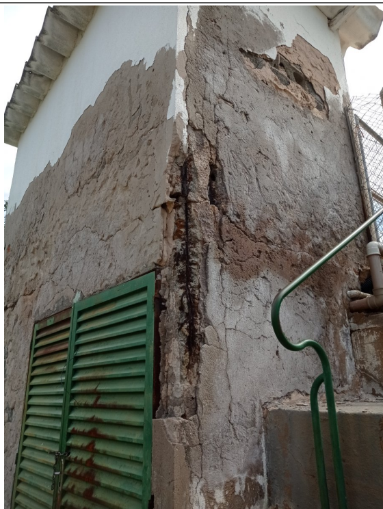
Vistoria do local da obra.
