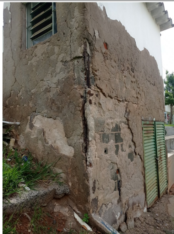
Vistoria do local da obra.
