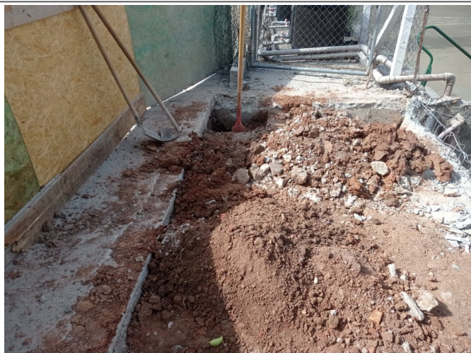
Execução da fundação.
