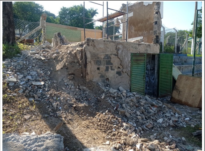
Demolição da casa de máquinas.
