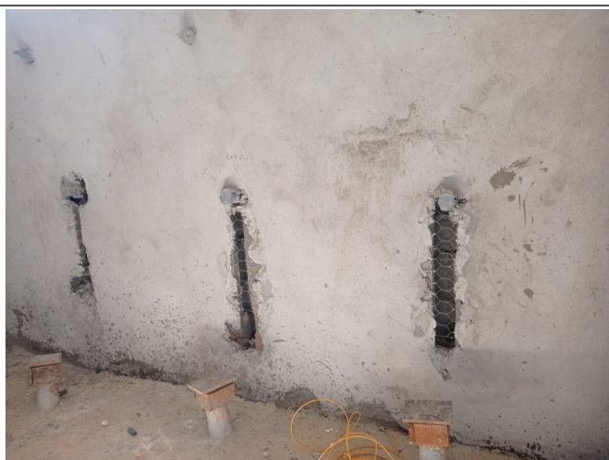
Revestimento argamassado e execução hidrossanitárias.
