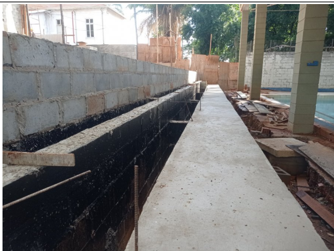
Concretagem e alvenaria das arquibancadas.
