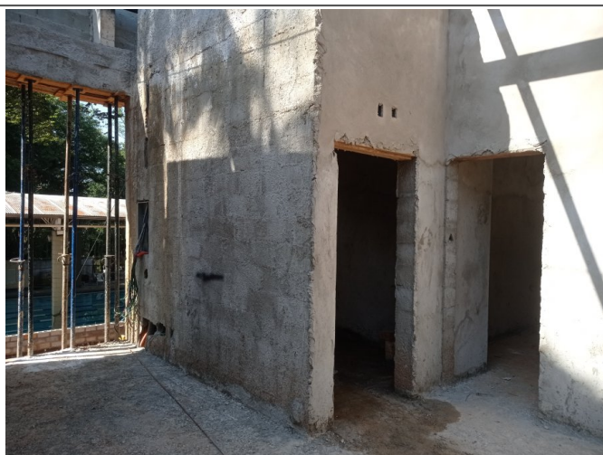
Revestimento argamassado, contrapiso.
