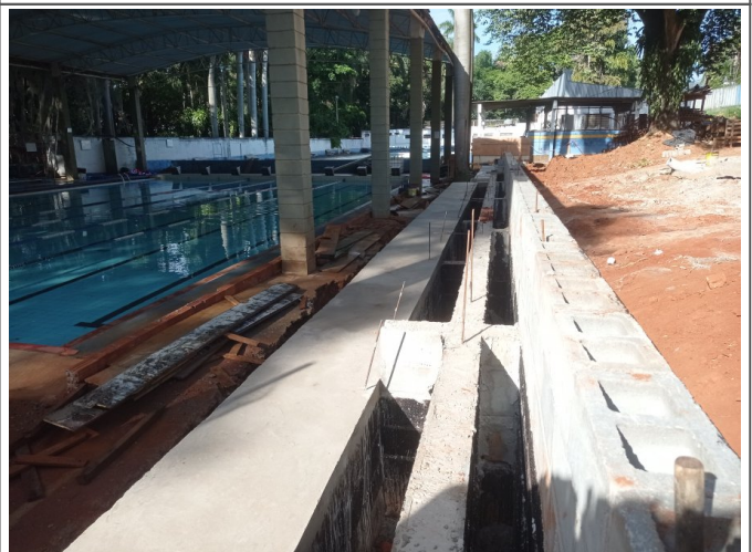
Concretagem e alvenaria das arquibancadas.
