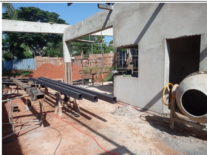
Revestimento argamassado e execução da estrutura metálica de cobertura.
