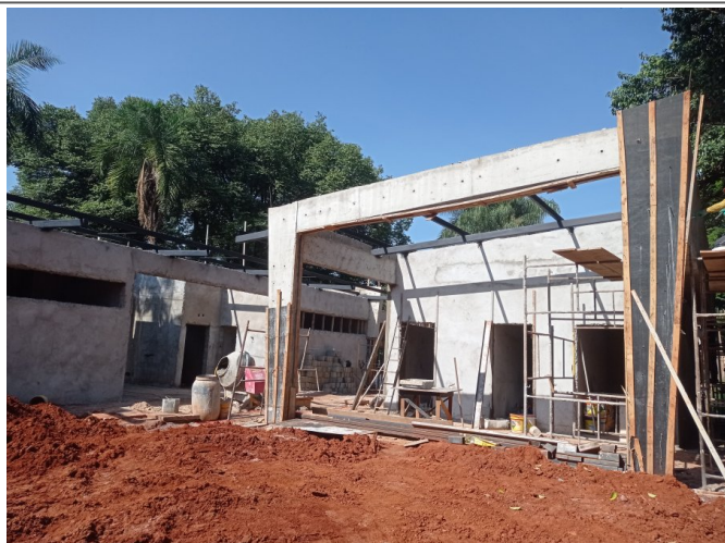
Revestimento argamassado e execução da estrutura metálica de cobertura. Terraplenagem.
