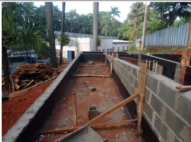
Alvenaria e estrutura do bicicletário e rampas de acesso.
