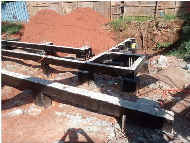
Impermeabilização e aterro da infraestrutura do bicicletário e rampas de acesso.
