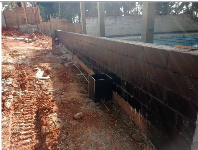
Impermeabilização alvenaria das arquibancadas, e locação das instalações hidrossanitárias e drenagem.
