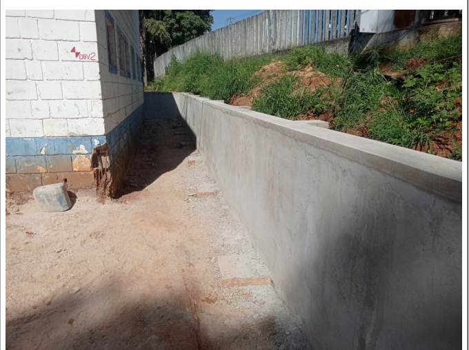
Revestimento argamassado do muro de arrimo.
