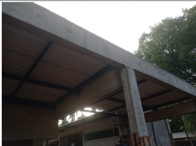
Execução da estrutura metálica e cobertura.
