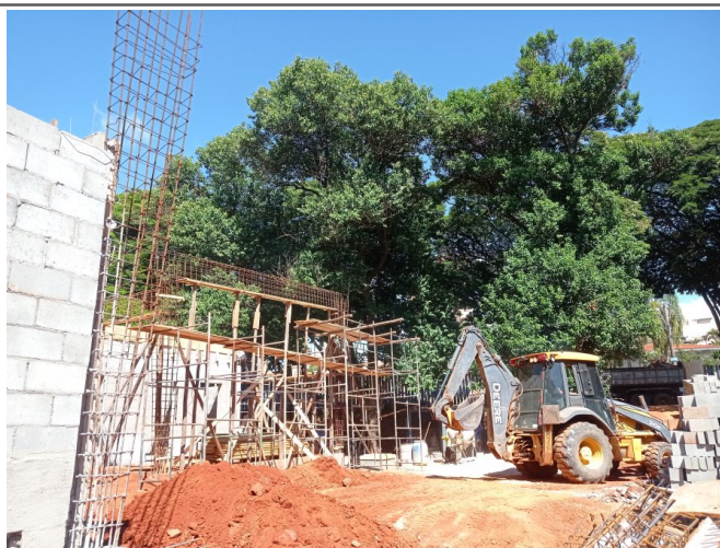
Execução da alvenaria, superestrutura, infraestrutura para instalações elétricas e hidrossanitárias. Terraplanagem.
