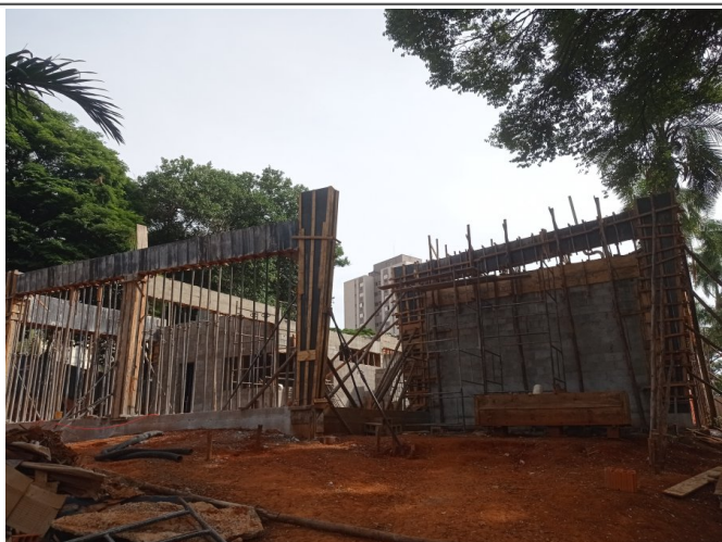
Execução da alvenaria, superestrutura, infraestrutura para instalações elétricas e hidrossanitárias
