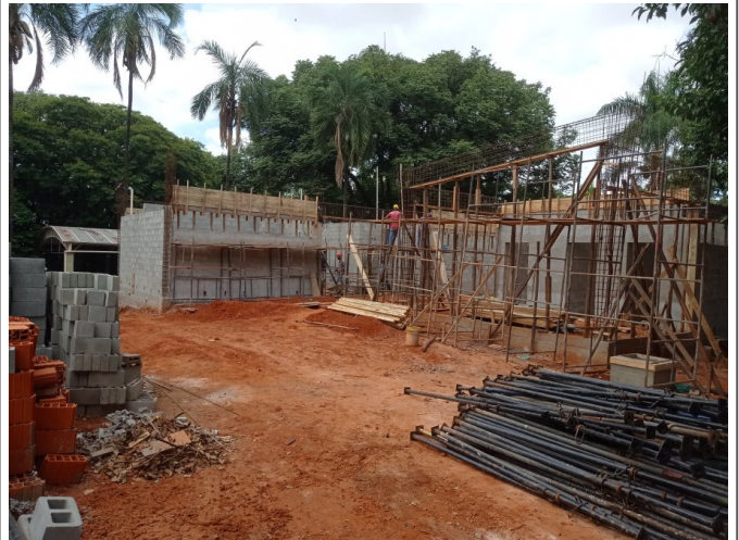
Execução da alvenaria, superestrutura e lajes, infraestrutura para instalações elétricas e hidrossanitárias.
