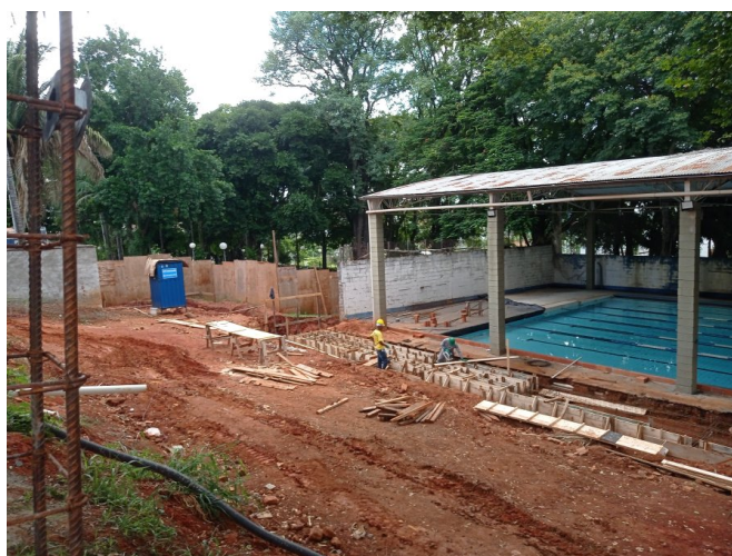
Execução da fundação das arquibancadas.
