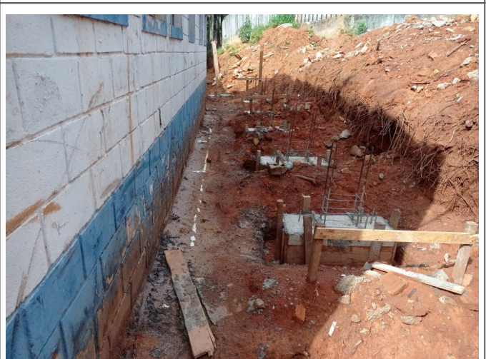
Execução da fundação do muro de arrimo.
