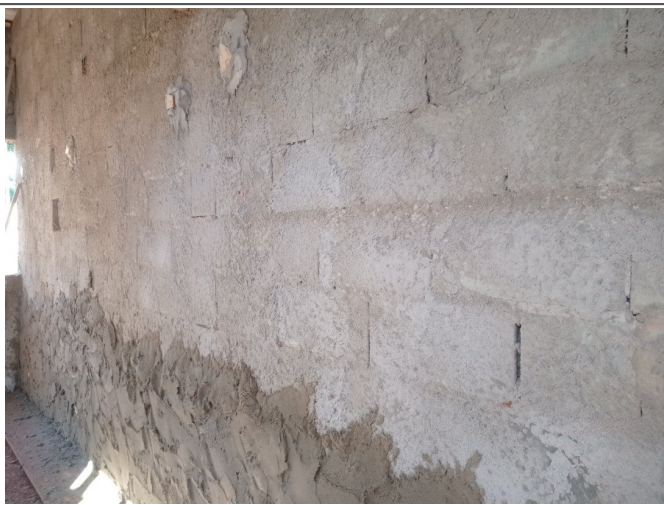
Revestimento argamassado.
