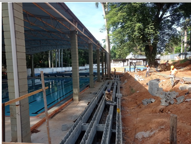
Execução das alvenarias das arquibancadas.
