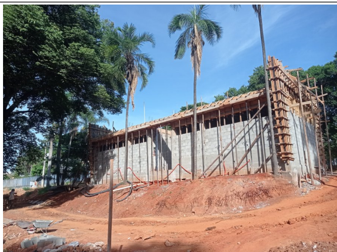
Execução da alvenaria e superestruturas, infraestrutura para instalações elétricas e hidrossanitárias.
