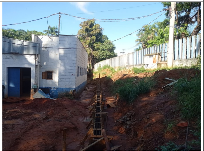
Execução da fundação do muro de arrimo.
