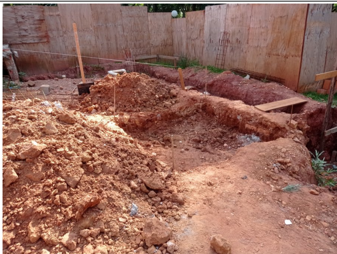
Infraestrutura para instalações hidrossanitárias.
