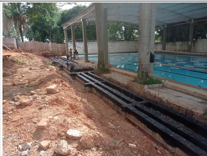
Impermeabilização da fundação das arquibancadas.
