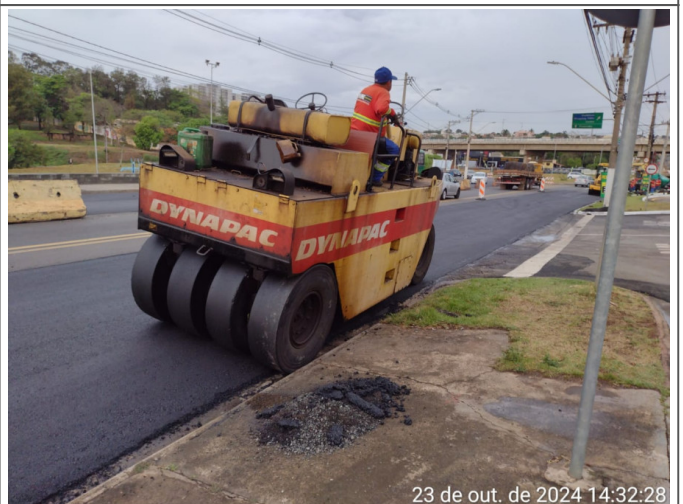
Execução de Camada de CBUQ.
