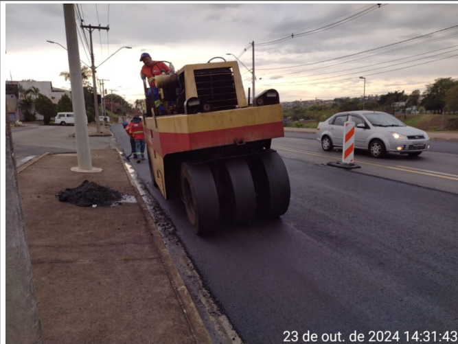
Execução de Camada de CBUQ.
