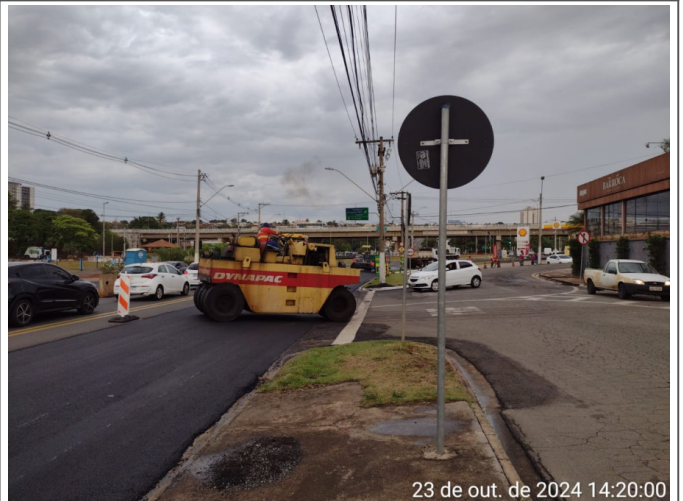
Execução de Camada de CBUQ.
