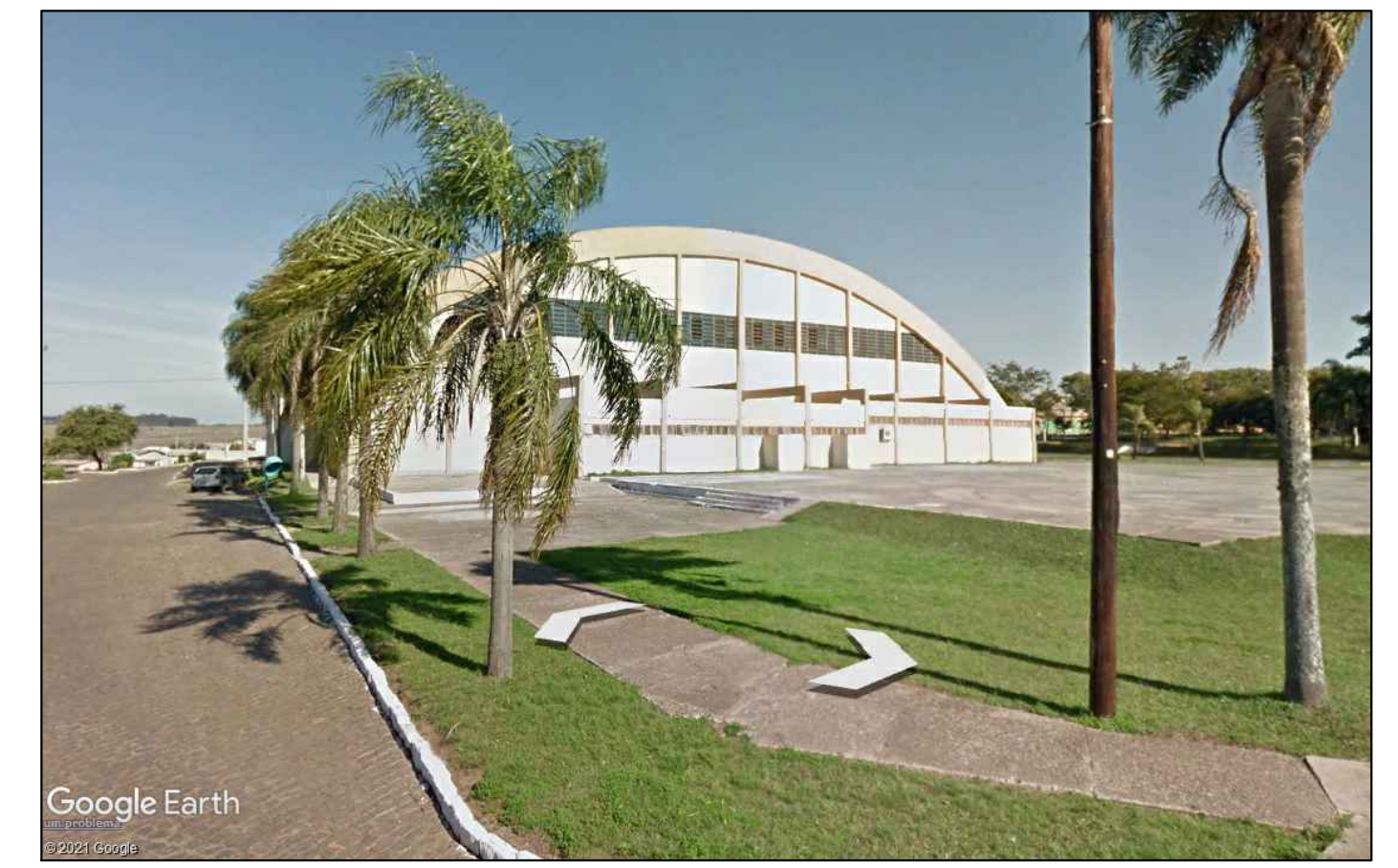
Vista Frontal do Prédio
