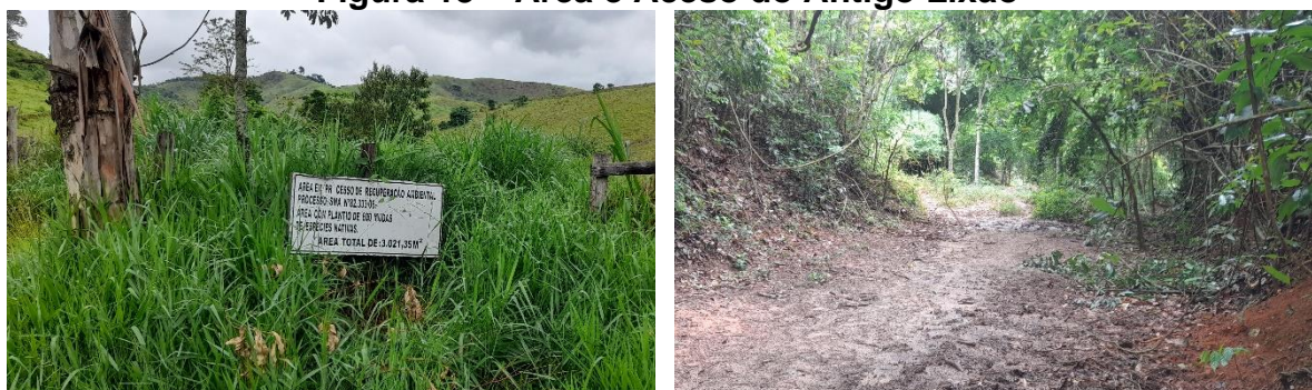
Figura 13 – Área e Acesso do Antigo Lixão
