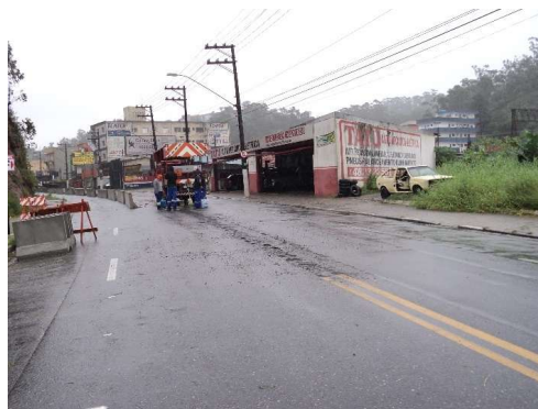
Remoção de sinalização horizontal - Método de queima
