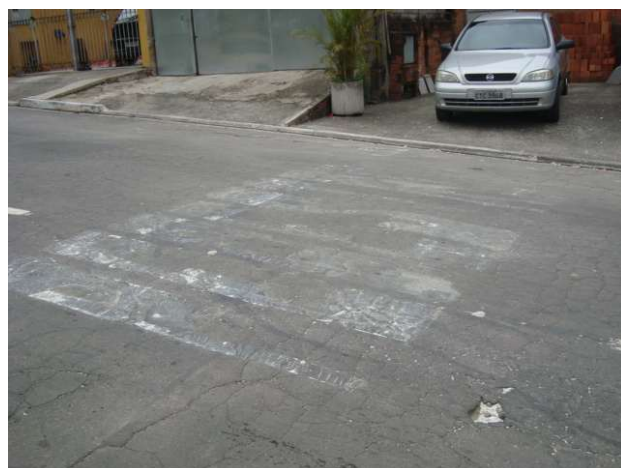
Remoção de sinalização horizontal - Método de fresagem
