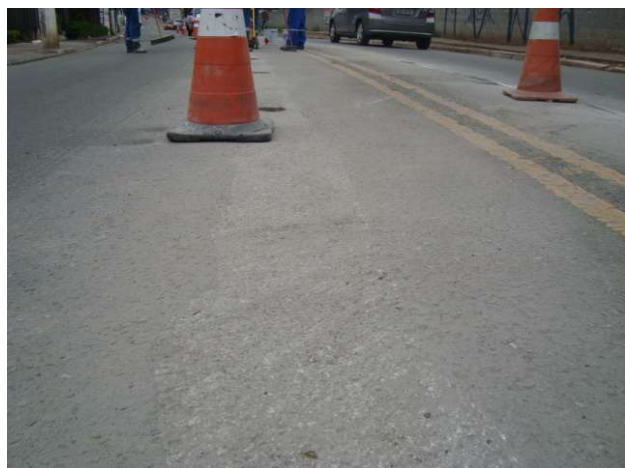
Remoção de sinalização horizontal - Método de fresagem
