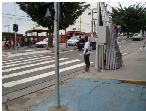
Controlador de tráfego
