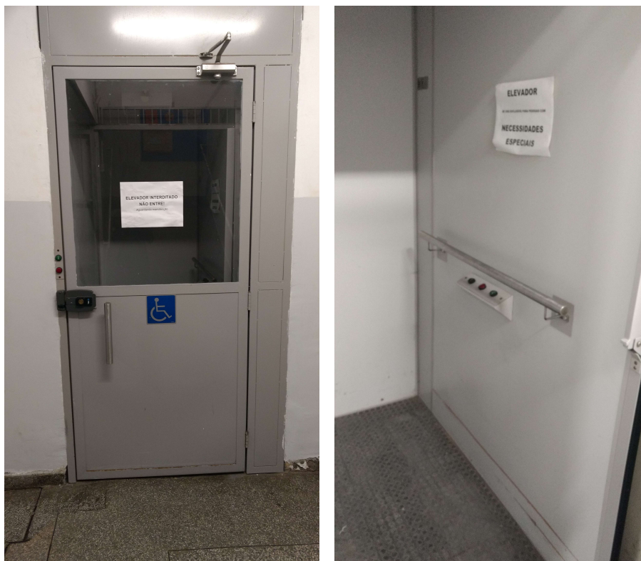
FOTO 3 e 4– Elevador EMEB Profª Rosa Scavone
