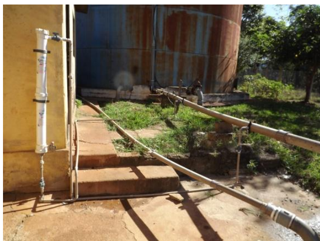
Foto 3.21 – Adutora do Poço Carolina Varanda – Ponto de Aplicação.
