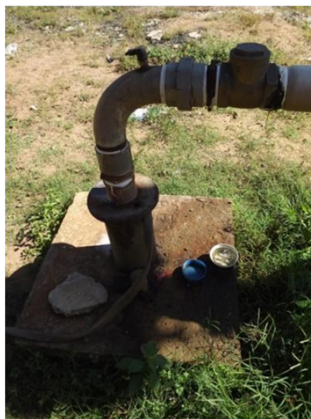
Foto 3.10 – Detalhe do Poço João Furtado.
