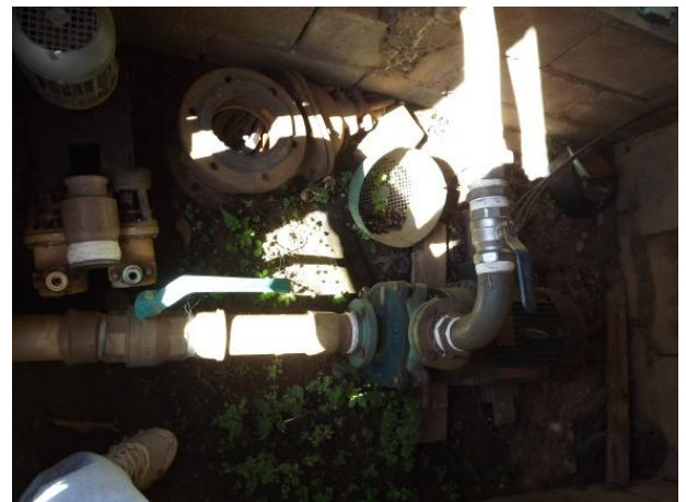
Foto 3.38 – Detalhe do Booster.
