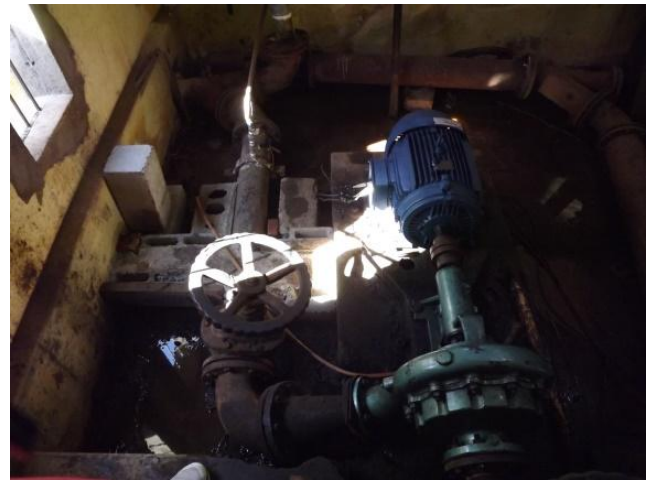
Foto 3.36 – EEAT Alfredo Teixeira – Vista Geral do Conjunto Motobomba.
