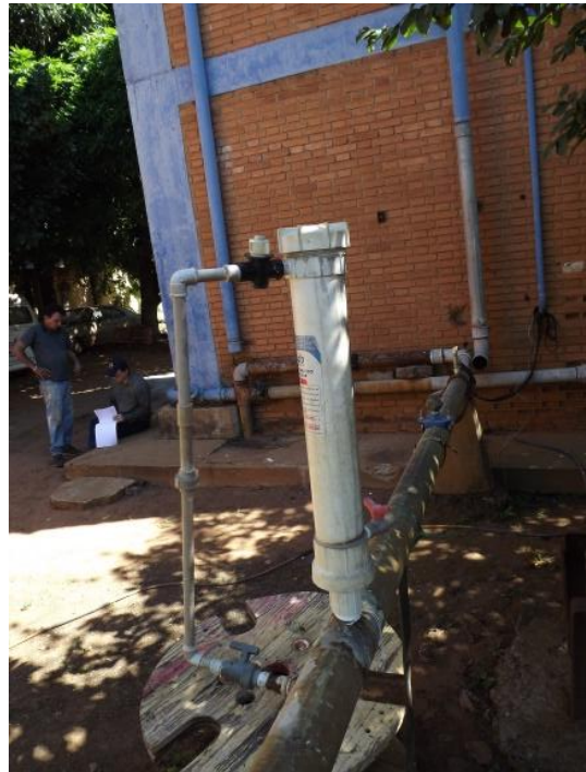
Foto 3.24 – Adutora do Poço Bento Quirino – Ponto de Aplicação.
