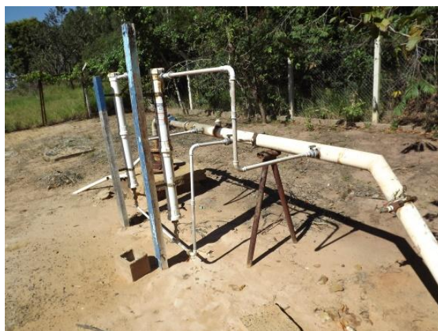
Foto 3.22 – Adutora do Poço Jardim da Saúde – Ponto de Aplicação.
