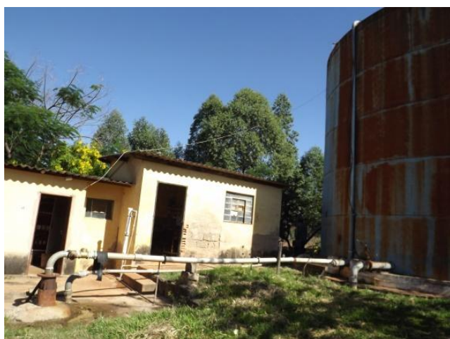
Foto 3.5 – Poço Carolina Varanda e Adutora.
