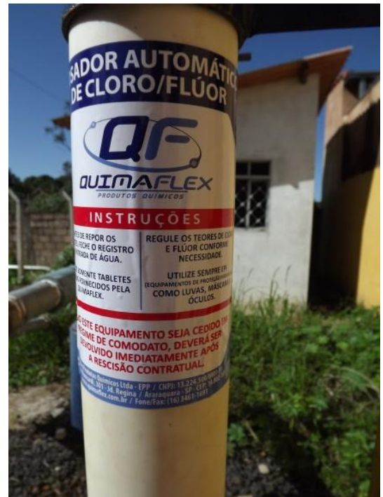
Foto 3.16 – Detalhe do Dosador Automático (Poço 22 de Abril II)
