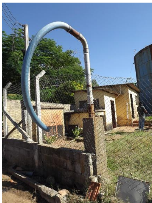
Foto 3.31 – RAP Carolina Varanda – Derivação para o abastecimento de caminhão-pipa.
