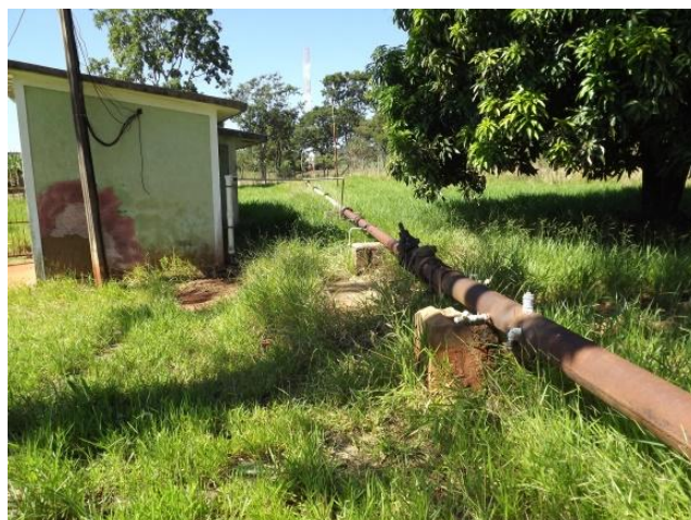
Foto 3.12 – Adutora do Poço Santa Isabel.
