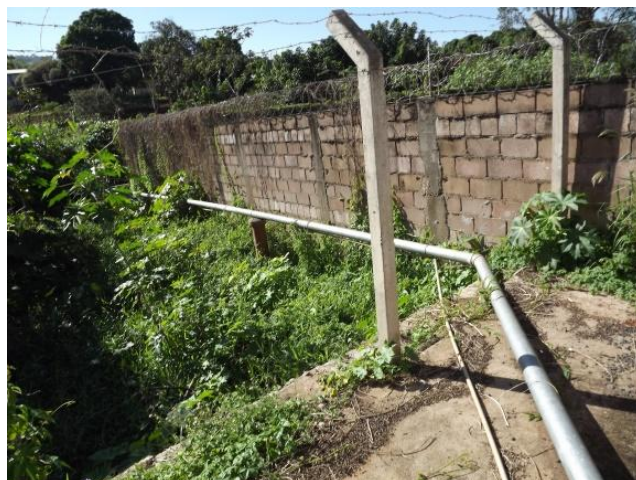
Foto 3.4 – Adutora do Poço 22 de Abril II.
