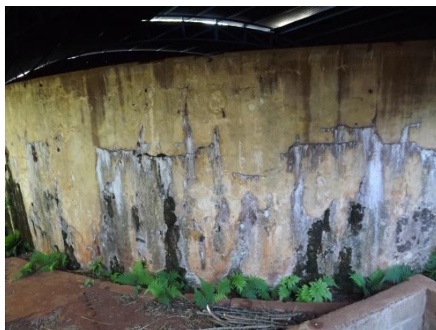
Foto 3.28 – RSE Augusto Paulino Gouvêa – Precário estado de conservação.
