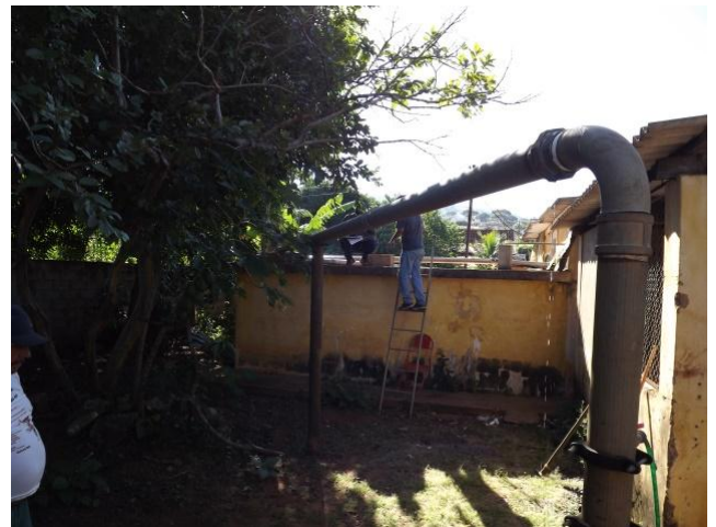
Foto 3.2 – Adutora do Poço Alfredo Teixeira.
