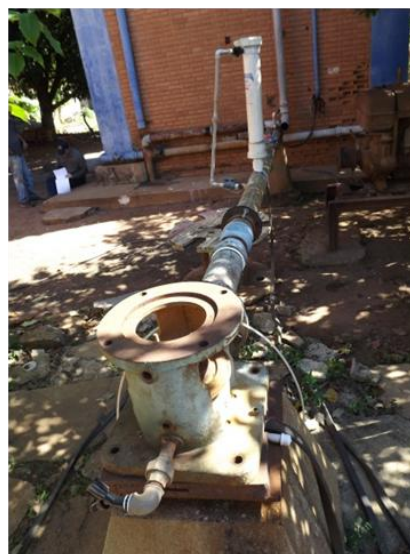
Foto 3.14 – Adutora do Poço Bento Quirino.
