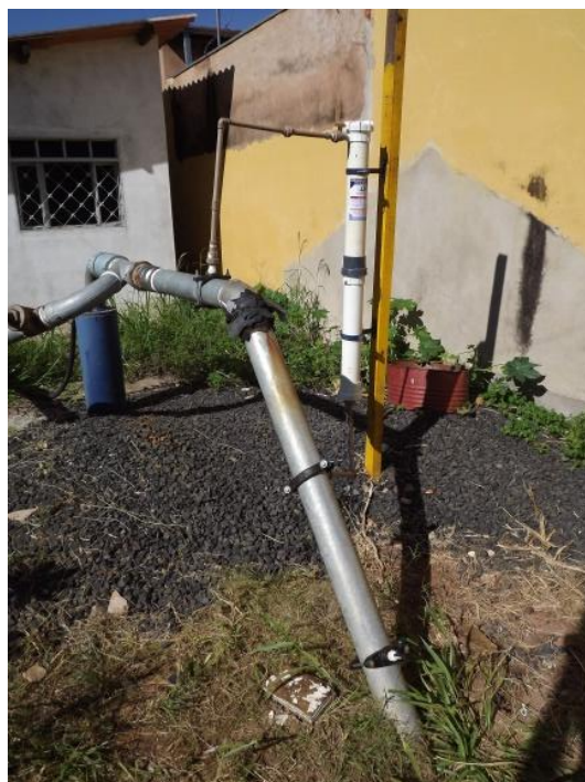
Foto 3.20 – Adutora do Poço 22 de Abril II – Ponto de Aplicação.
