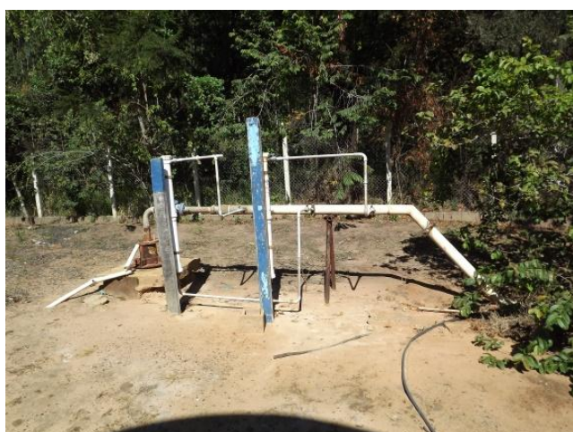
Foto 3.7 – Poço Jardim da Saúde e Adutora.
