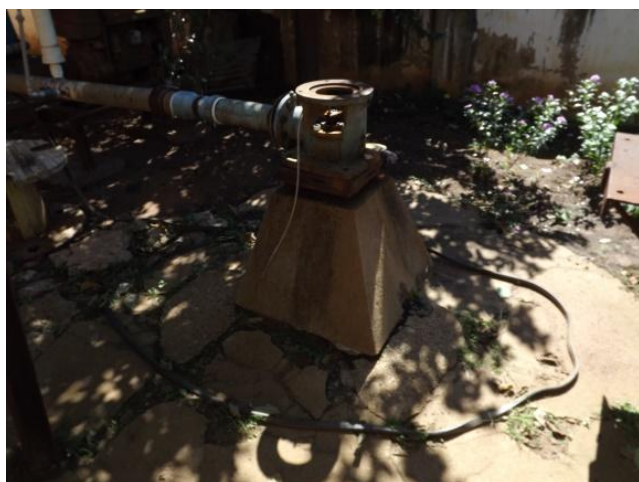
Foto 3.13 – Poço Bento Quirino.
