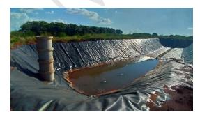
Figura 130 - Vala aberta com Iona de impermeabilização.
