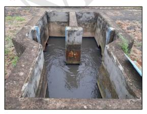
Figura 105 – Caixa divisória de esgoto para as lagoas aeradas.
