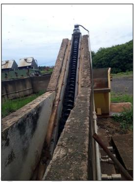
Figura 102 – Eixo de bomba Parafuso..
