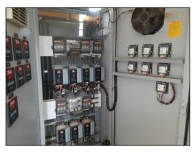
Figura 108 – Painel elétrico dos aeradores.
