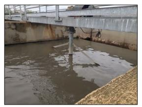
Figura 101 - Adensador de Iodo.
