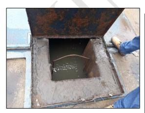
Figura 68 – Gradeamento da EEE Verona que encontrava-se sobrecarregado
