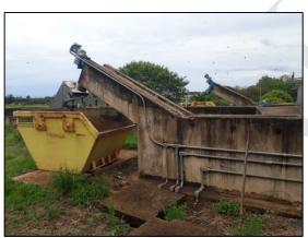
Figura 103 – Descarte de Iodo dos adensadores.
