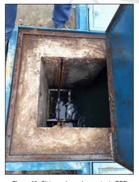
Figura 62- Sistema de gradeamento da EEE Cardoso
