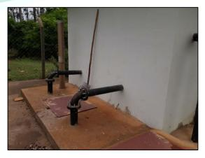
Figura 70 – Poço único de sucção da EEE Perobeira
