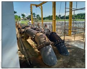
Figura 16 – A esquerda tubulação de adução tratada e a direita de água bruta
