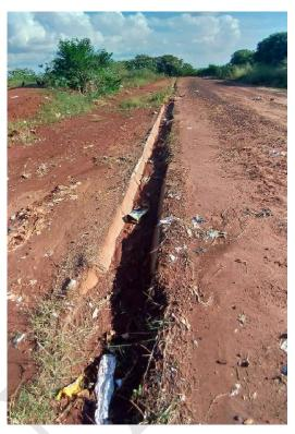
Figura 133 – Canaletas de drenagem pluvial.
