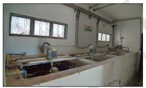
Figura 26 – Tanques de Cal Hidratada
