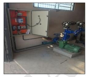
Figura 87 – Bombas e painel elétrico da EEE Vila Esperança Fonte: SAE, 2019.
