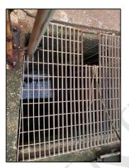
Figura 91 - Caixa de passagem com gradeamento mecanizado.
