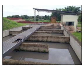
Figura 114 – Tanque de contato.
