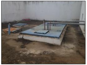
Figura 85 — Poços de sucção de esgoto da EEE Canaã
