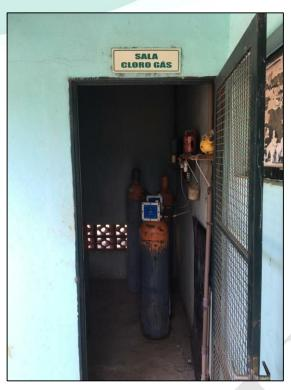
Figura 28 - Local de armazenamento de cloro gás
