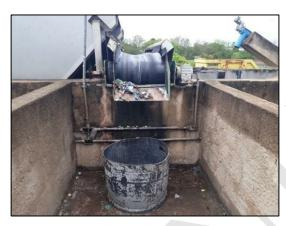
Figura 97 – Esteira de coleta de resíduos retidos no gradeamento
