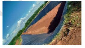
Figura 129 – Vala aberta com Iona de impermeabilização.
