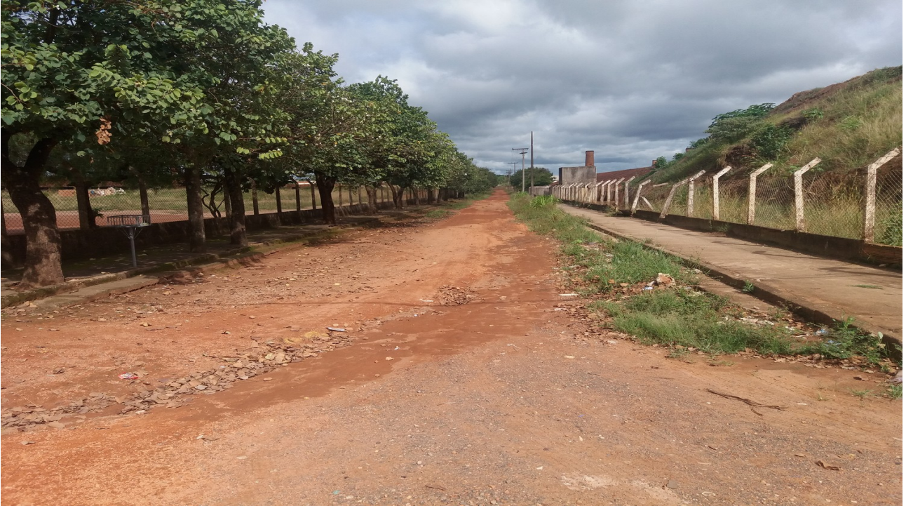
- Trecho da Avenida Municipal
