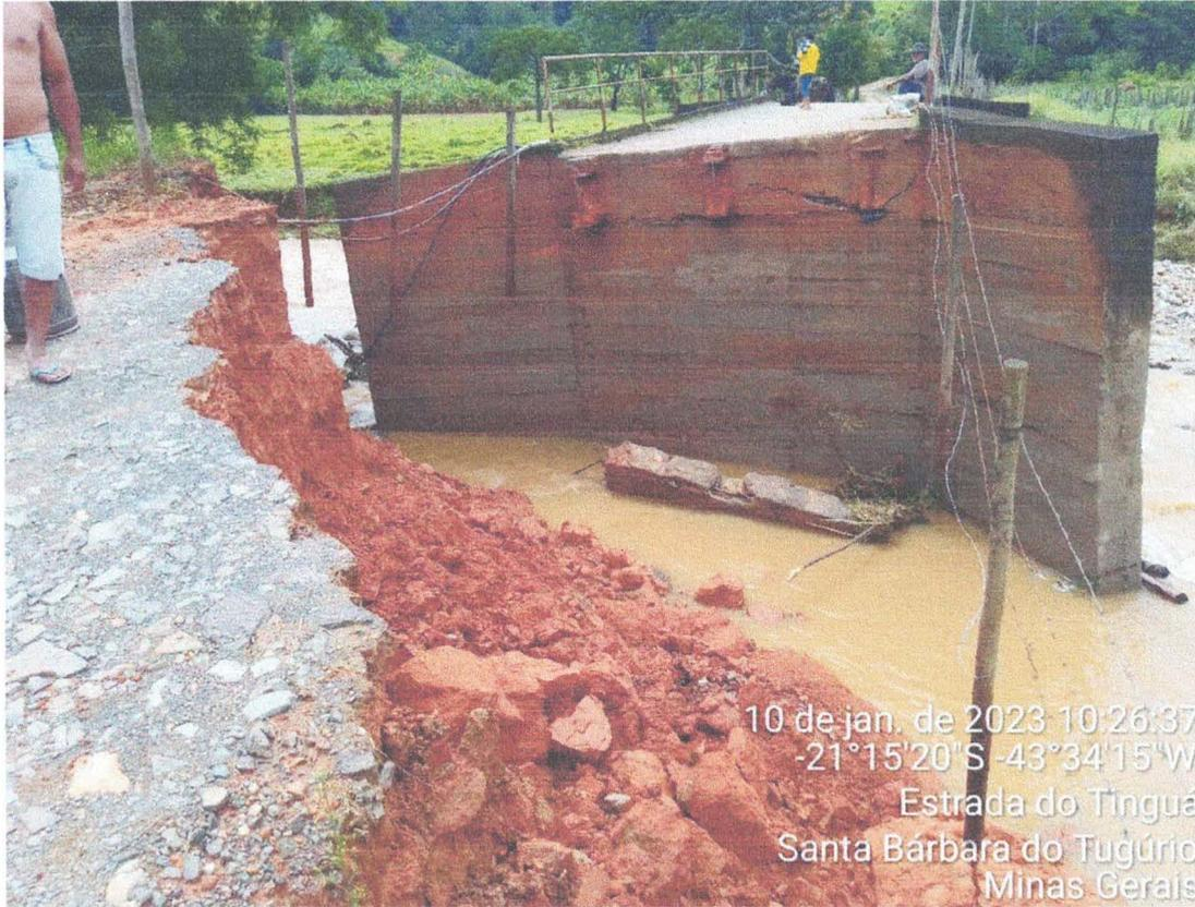
Imagem 10: Aterro de ponte destruído pela enchente ocasionada pela forte chuva do dia 09. A ponte é o principal acesso a comunidade Fernandes I e Tinguá.
