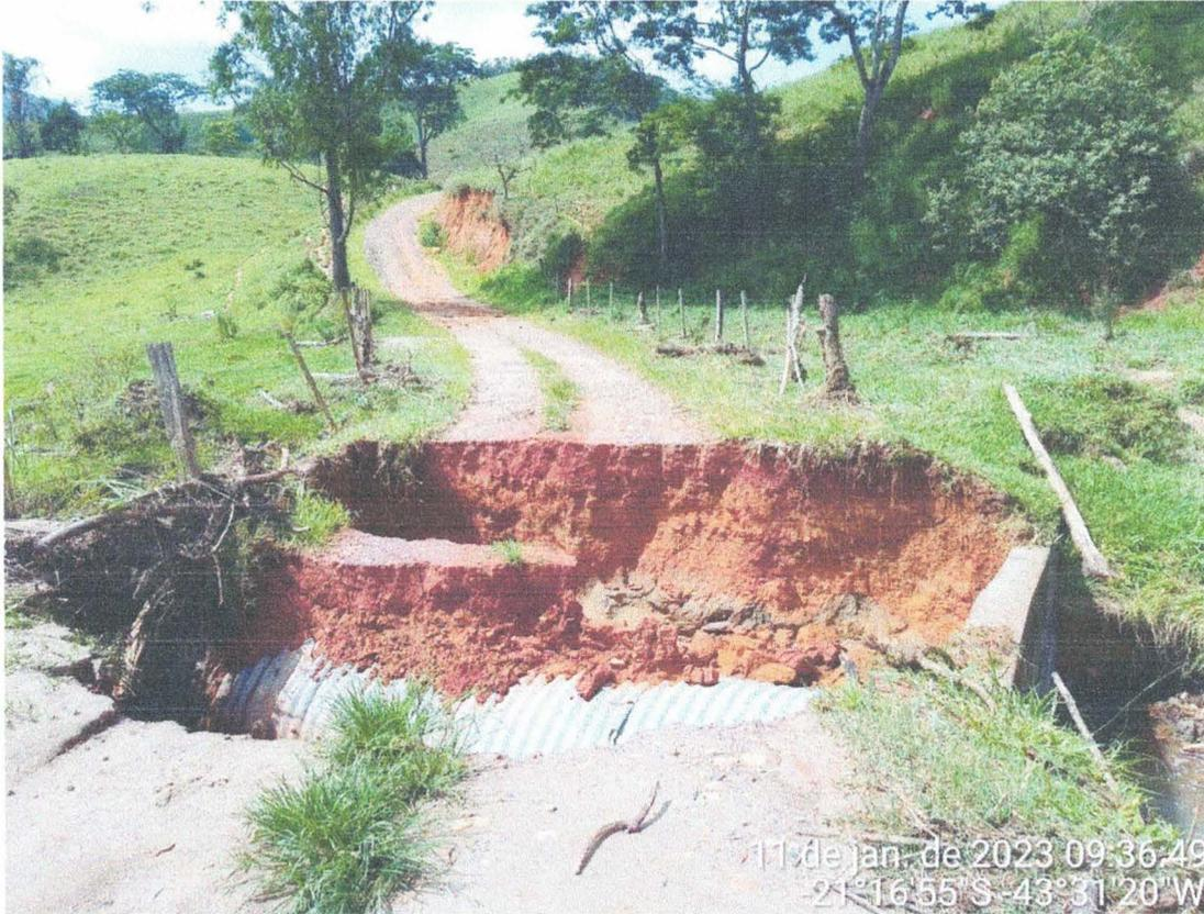
Imagem 12: Aterro e estrutura de contenção do tubulão foram destruídos na estrada de acesso da comunidade rural Japão.
