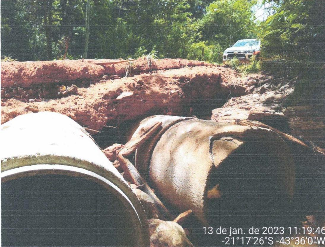
*Imagem 15: Manilhas quebradas pelas fortes chuvas do dia 09 no alto da comunidade Serra. A água está escoando por entre as manilhas e debaixo da terra da estrada tem manilhas quebradas. Como as próximas chuvas a comunidade ficará sem acesso.*
