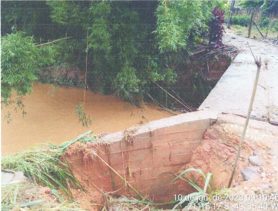
Imagem 6: Processo de desassoreamento do talude de aterro da ponte na comunidade Serra
