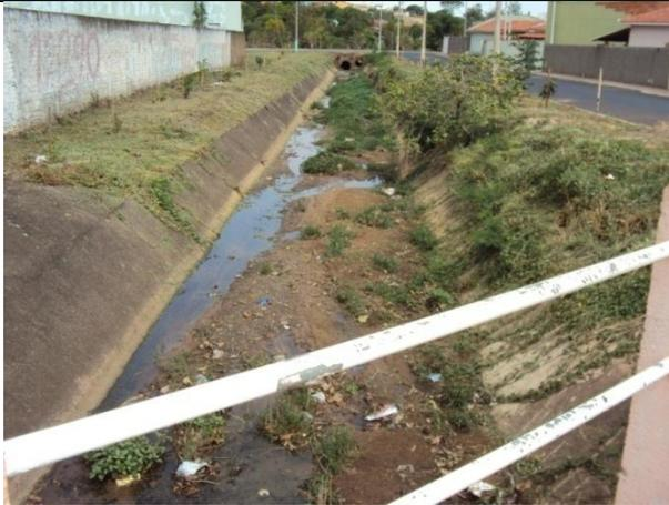
Assoreamento do córrego e modificação do tipo de revestimento do canal, na P 10 (Rua Sete de Setembro com Rua Onofre I. Barbosa)
