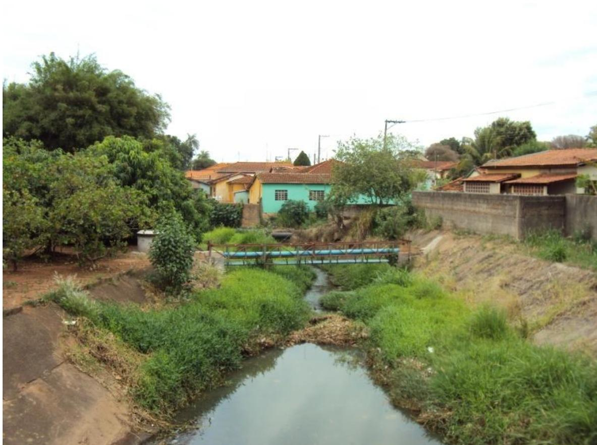
**Figura 77: Falta de manutenção modificando a calha do Córrego Cajuru no trecho 1.18 a 1.19, vista da P19 localizada na rua Dr. José Alves Martins dos Santos.**
