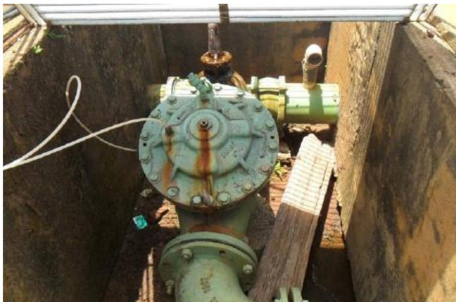
**Figura 66: Válvula de controle afluyente; extravasa água bruta excedente em galeria pluvial.**
