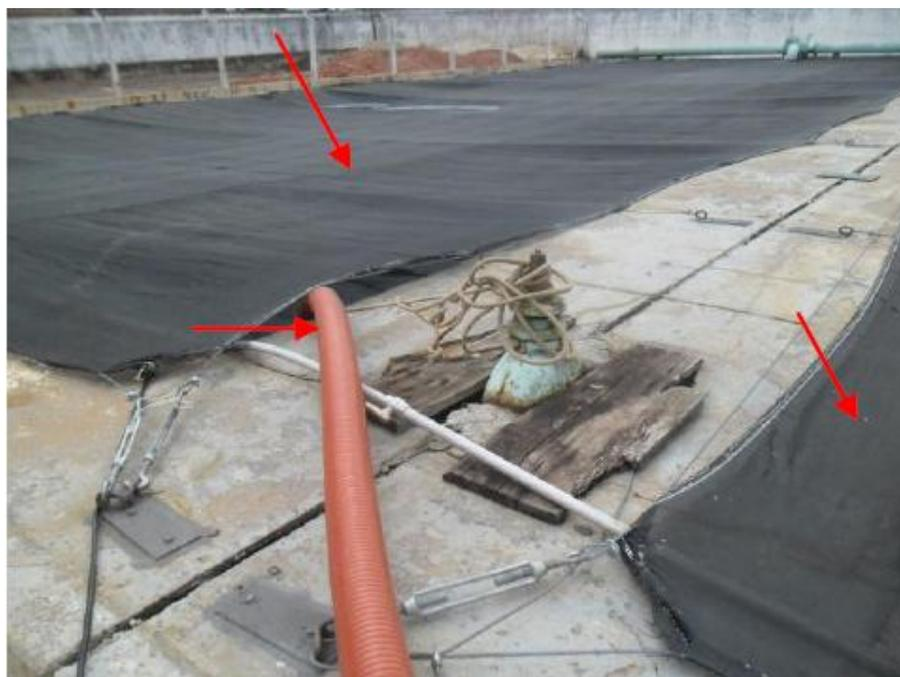
**Figura 59: Instalação de sistema precário de reforço de recalque de água para o poço de sucção da estação elevatória de água tratada a partir dos reservatórios semi-enterrados.**
