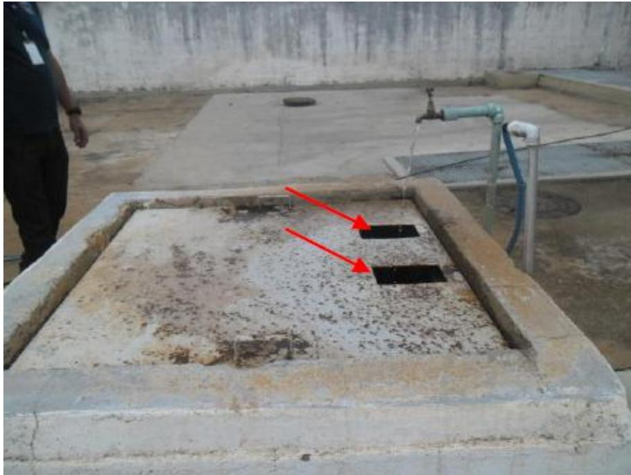
**Figura 57: Tampa do poço de sucção com aberturas que possibilitam exposição a fontes de contaminação.**
