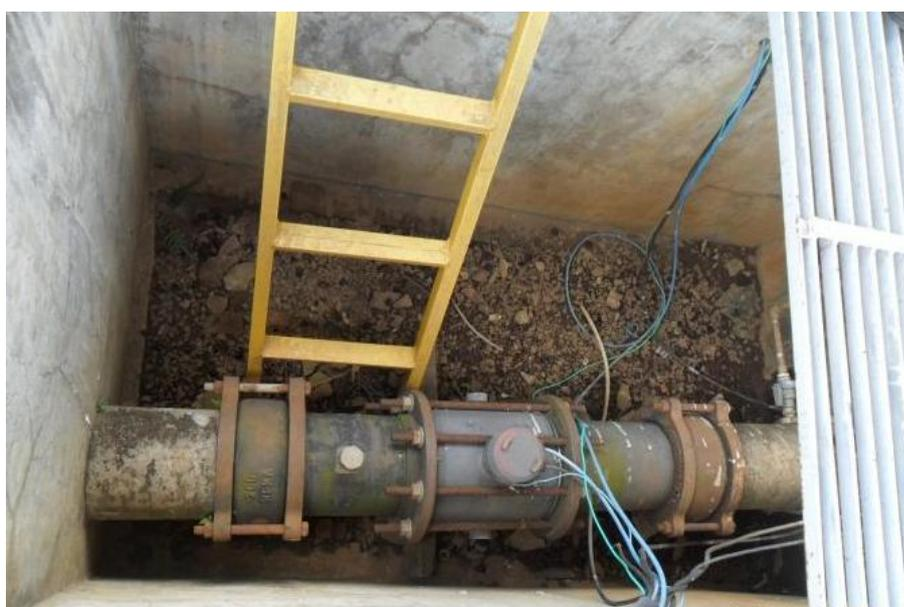
**Figura 67: Macromedidor de água bruta, instalado à jusante da válvula de controle afluyente.**
