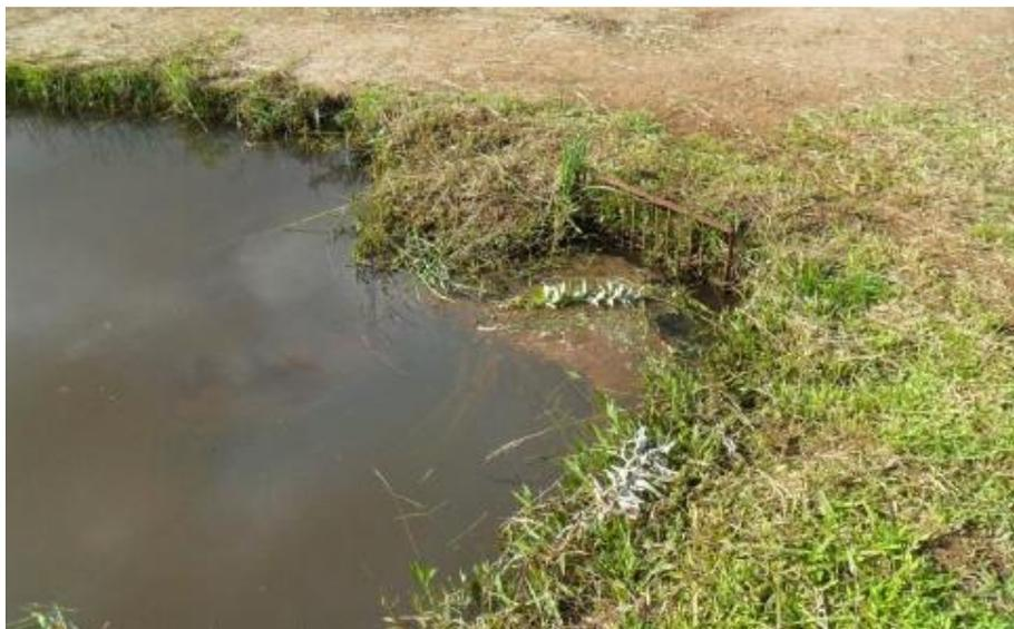
**Figura 48: Captação – tomada d'água da tubulação de adução de água bruta, com gradeamento.**
