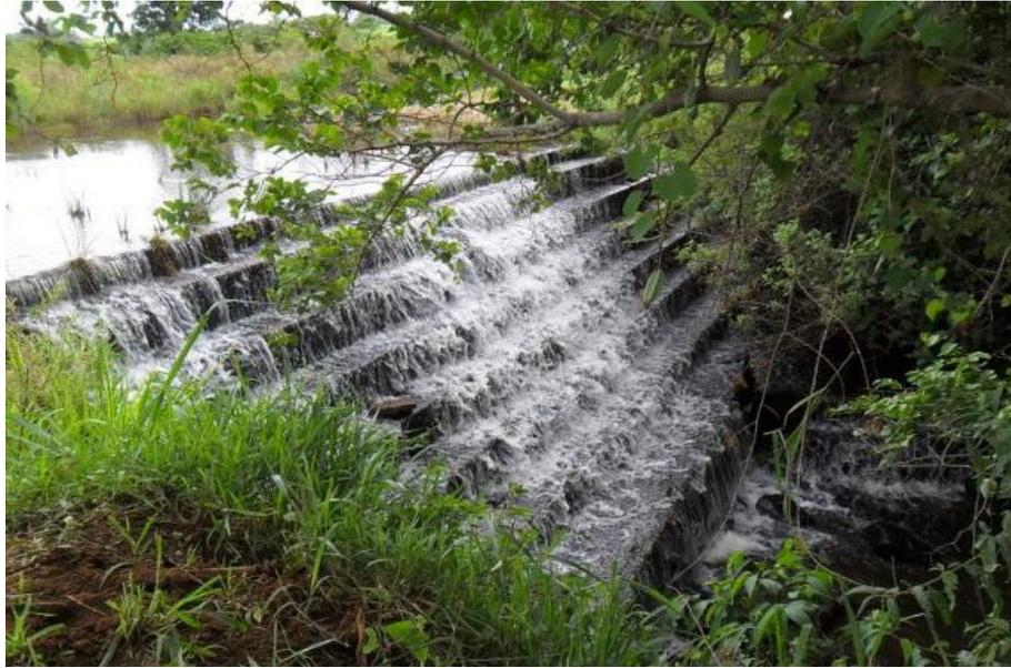
**Figura 47: Captação – barragem de nível; a adução de água bruta é realizada sob ação da gravidade.**
