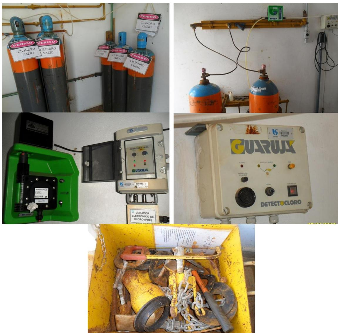
**Figura 71: Armazenamento de cilindros de cloro-gás, liquefeito sob pressão; Cilindros de cloro-gás em operação e equipamentos de segurança coletiva; Dosadores de cloro-gás; Detalhe do detector de cloro-gás; Kit de emergência para estancar vazamentos em cilindros de cloro-gás.**
