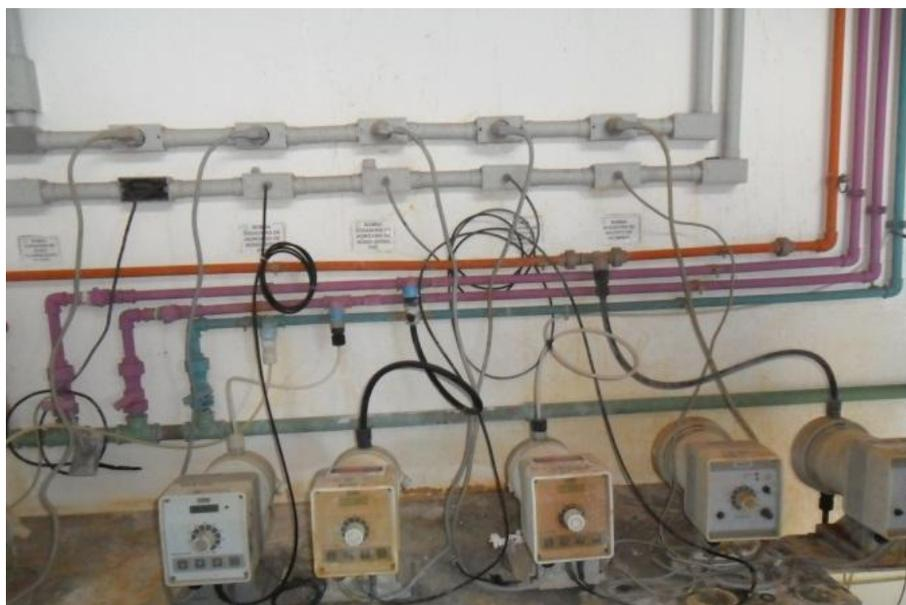
**Figura 72: Dosadoras de flúor, soda cáustica e sulfato de alumínio.**
