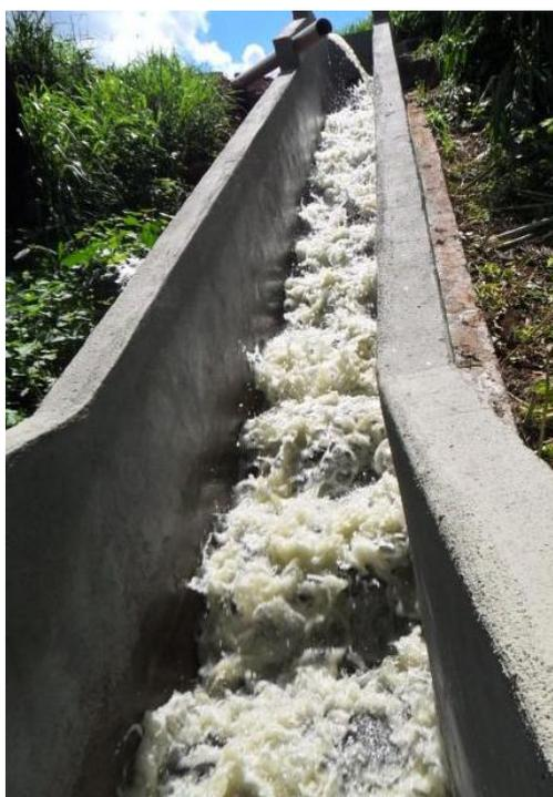
**Figura 100: Vista de jusante da escada de aeração do efluente final.**
