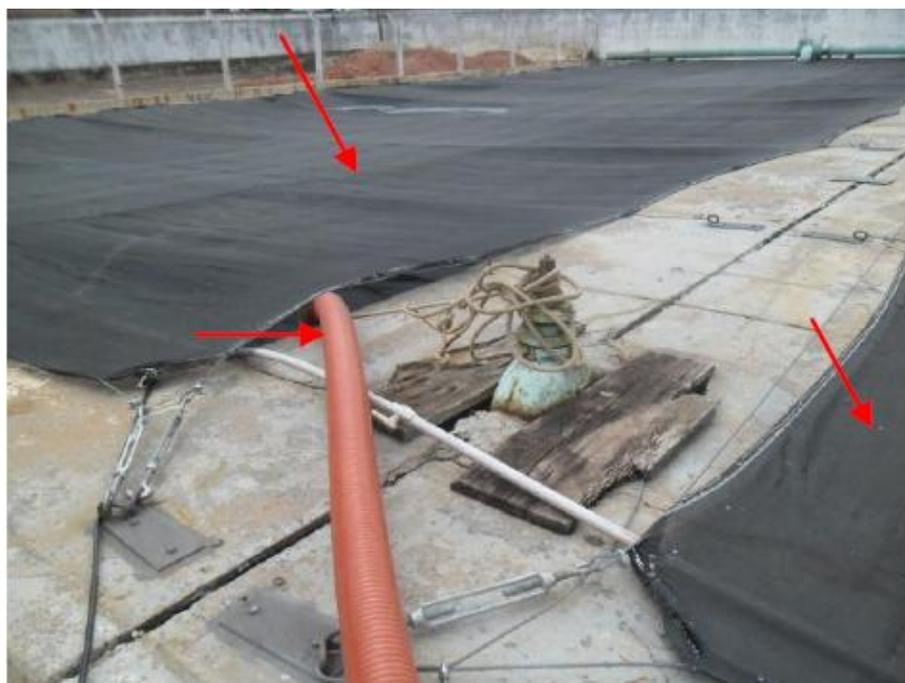
**Figura 61: Reservatórios semi-enterrados - inexistência de laje de cobertura e proteção precária com sombrites.**
