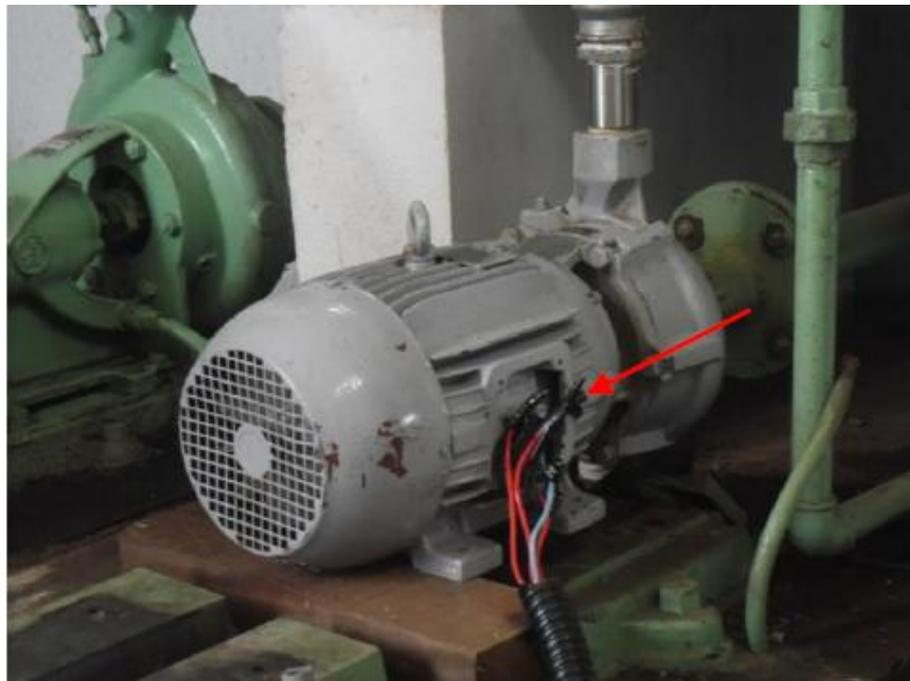
**Figura 58: Caixa de ligações elétricas do motor expostas, sem proteção.**
