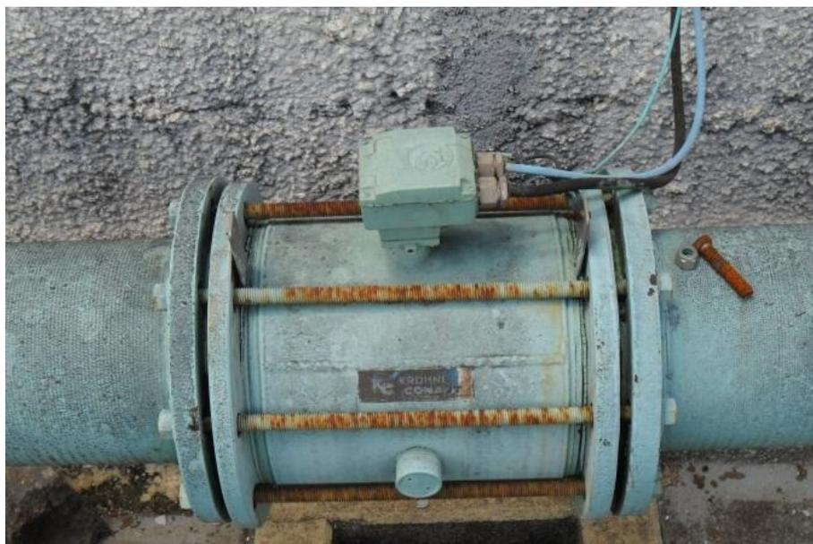
**Figura 77: Macromedidor de água tratada.**
