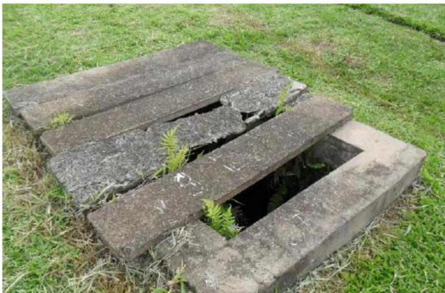
**Figura 49: Captação - caixa de passagem (retenção de areia) da adutora de água bruta.**
