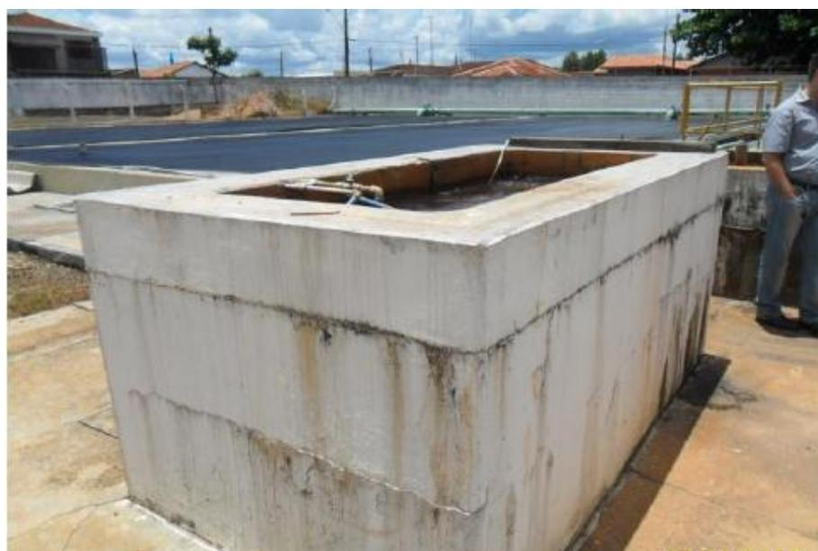
**Figura 65: Tanque de amortização e aplicação de produtos químicos na água bruta.**
