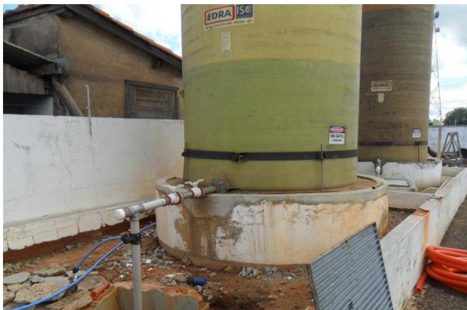
**Figura 64: Soda cáustica e sulfato de alumínio.**
