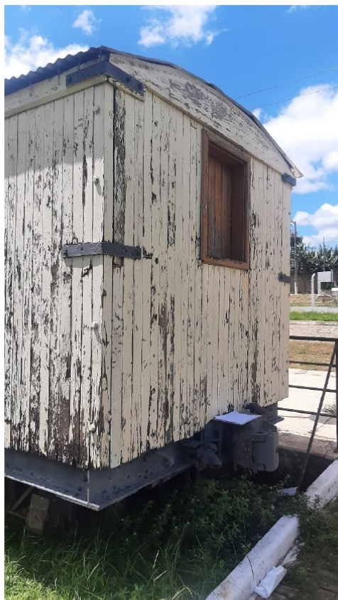
Foto 5 - Antigos Vagões da Cia Mogiana – Detalhe do vagão dormitório (camada pictórica danificada) Dezembro/2022 - Foto: Fábio de Castro Alves
