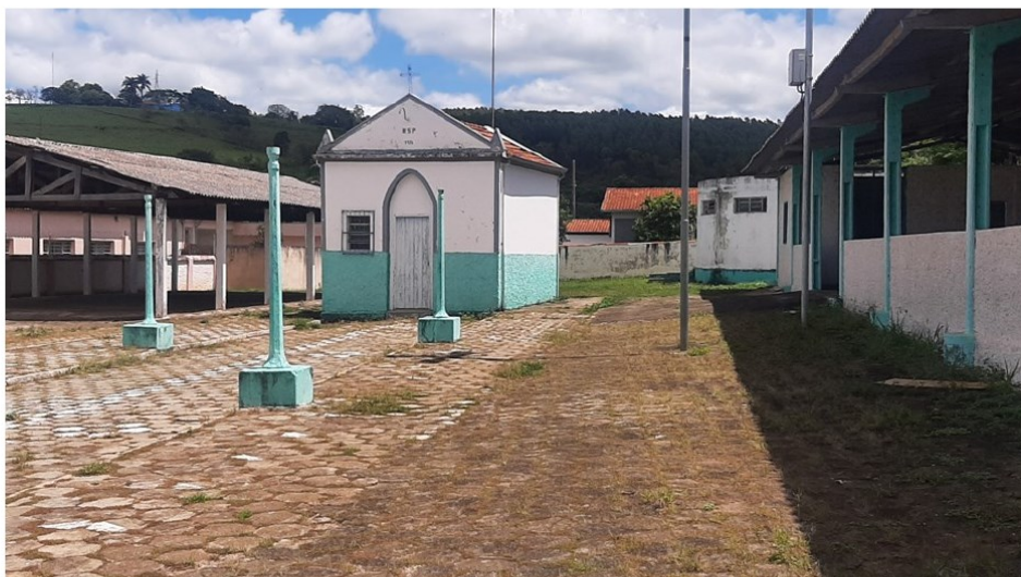
Foto 19 - Capela de Nossa Senhora da Penha – Visão geral – passeios externos por onde nascem gramineas, descaracterizando o bem. Dezembro/2022 - Foto: Fábio de Castro Alves
