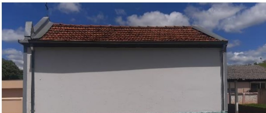
Foto 4 - Capela de Nossa Senhora da Penha - Detalhe da cobertura (lado esquerdo) Dezembro/2022 - Foto: Fábio de Castro Alves
