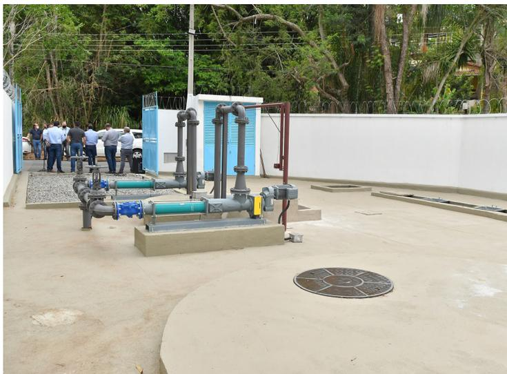
Foi inaugurada a Estação Elevatória de Esgotos da Vila São José, que tem capacidade para atender 400 imóveis, com bombeamento de até 10 m<sup>3</sup>/hora. O esgoto é encaminhado para o coletor central com destino à Estação de tratamento de Esgotos, que fica no bairro dos Leais. O investimento da Companhia de Saneamento Básico do Estado de São Paulo (Sabesp) é de R\$
