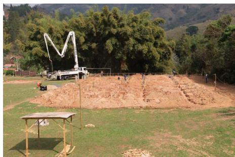
A empresa Infratécnica, vencedora do processo licitatório, executa obras de fundação, com concretagem das ligas baldrame e estacas de um dos lados do prédio da creche escola em construção no Bairro das Três Barras. Depois de concluída a primeira parte, a empresa iniciará a preparação para a concretagem da segunda parte do prédio.
