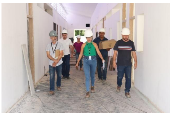
Foto 01 – Acompanhamento da construção da creche-escola “EMEB Prof. Doraci R. Silingardi”)
