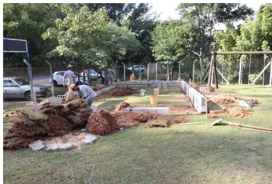
Foto 05 – Construção de caixa de areia - EMEB e Especial Profª Olga de Souza Vichi).
