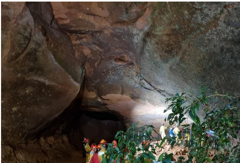
Foto 02. Notar estruturas de descontinuidade do arenito no teto da Gruta e geometria irregular da superfície.
