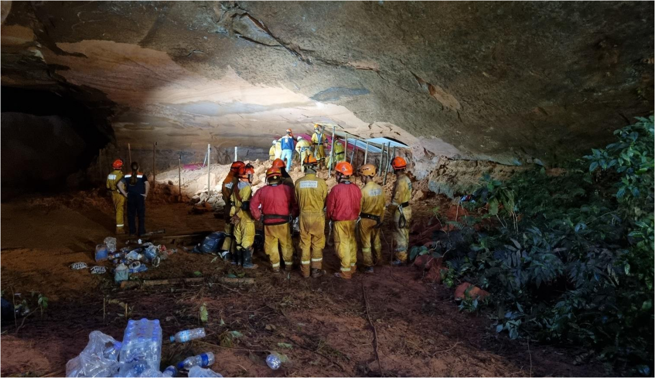
Foto 01. Vista geral do local onde ocorreu o deslocamento de blocos de rocha. Notar estruturas favoráveis aos deslocamentos (fraturas, fissuras e acamamento), mancha de umidade, geometria da cavidade e estruturas de contenção (pranchas de madeira e escoras) formando “células” para aumentar a segurança das equipes.
