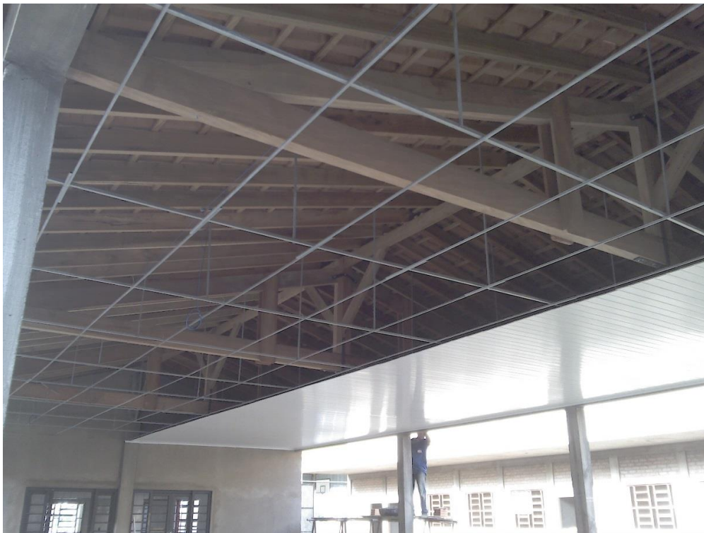
Foto 01 da execução do forro de PVC
