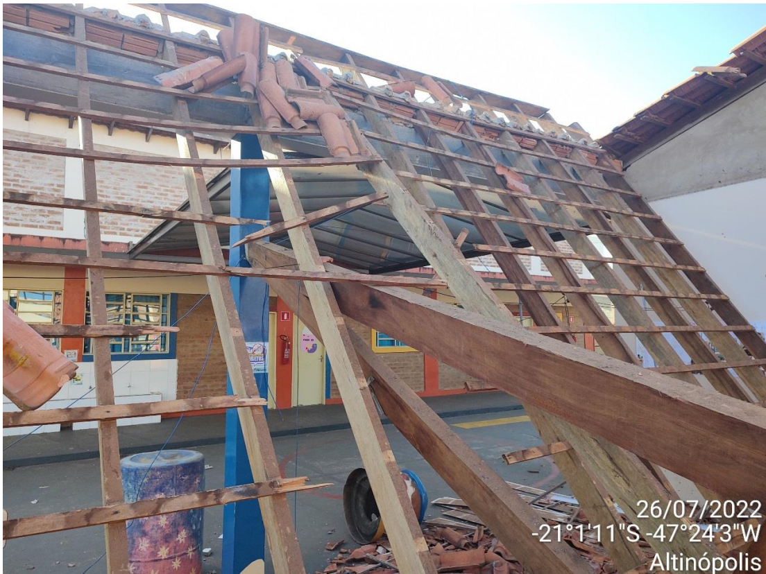
Foto 10 Desencaixe da tesoura dos apoios
