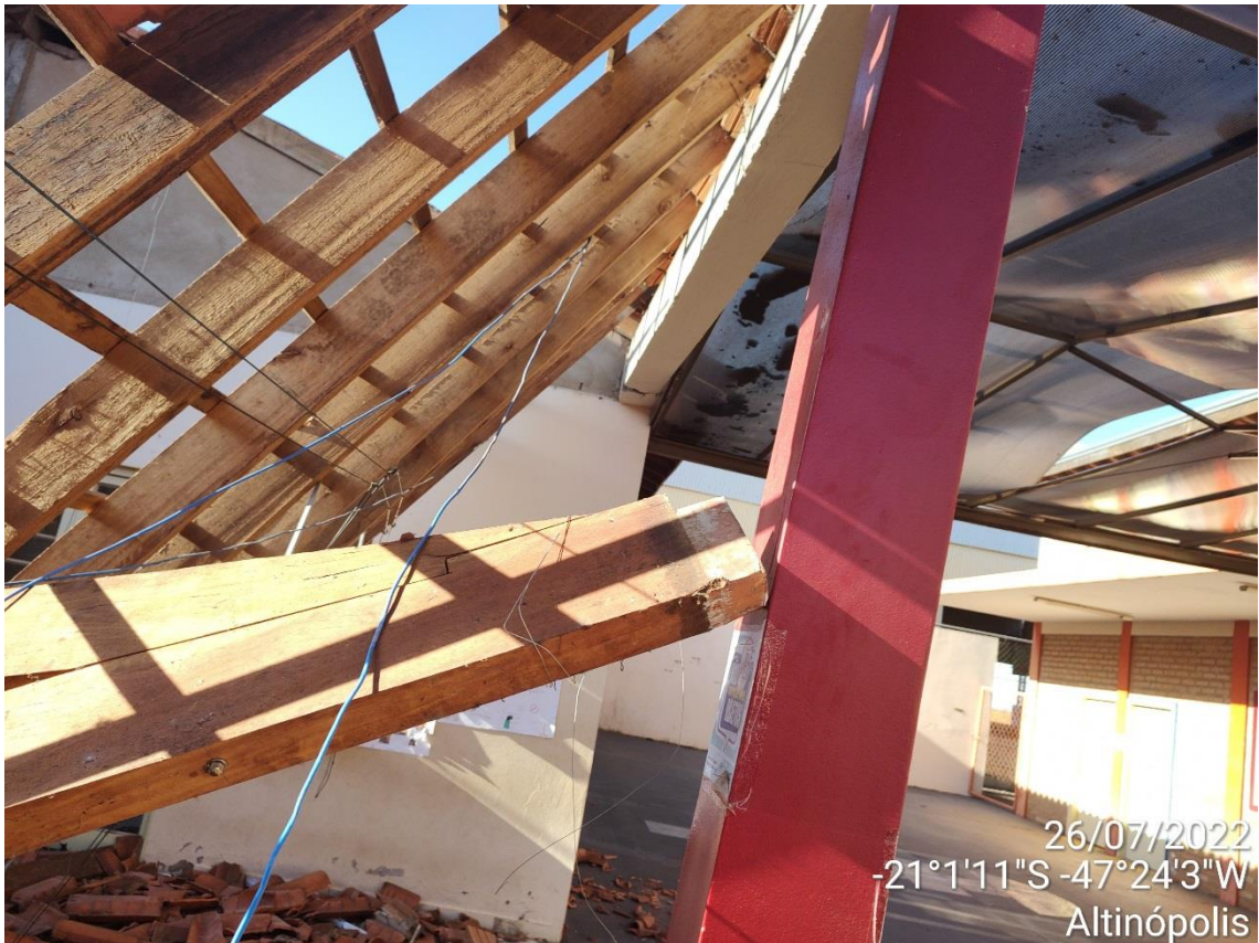
Foto 11 Desencaixe da tesoura dos apoios
