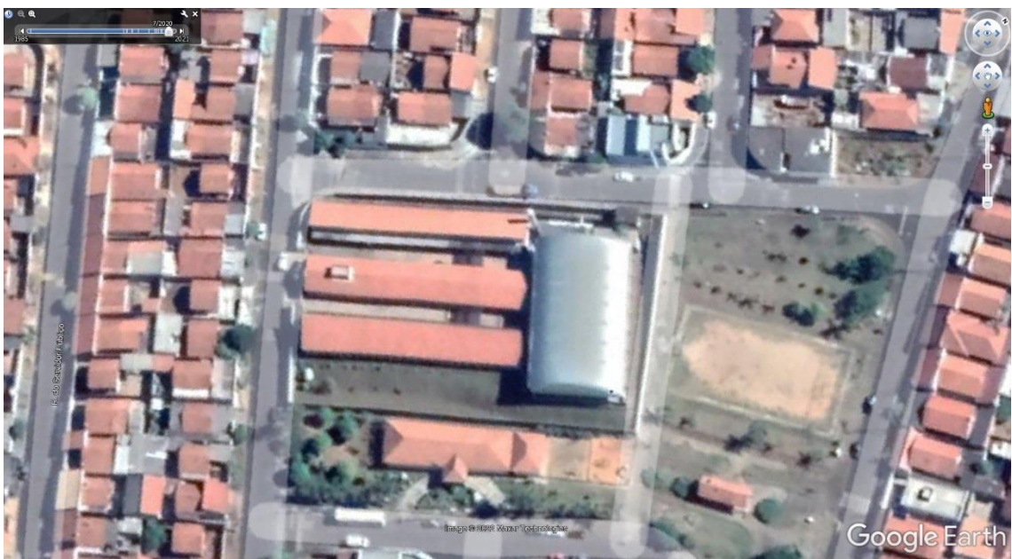
Foto 08 de 07/2020 pode se notar que existe cobertura ligando o pátio e as salas de aula
