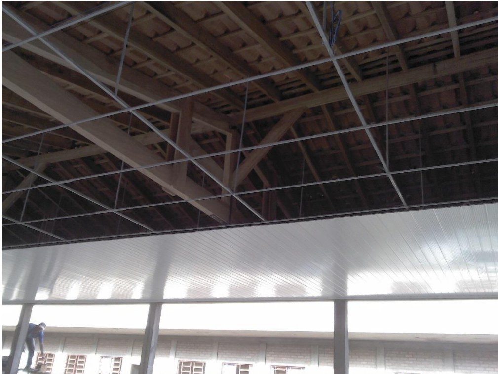
Foto 02 da execução do forro de PVC
