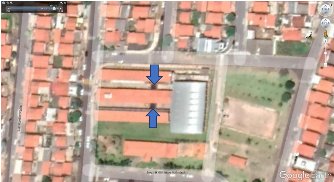
Foto 07 de 11/2018 pode se notar que existe cobertura ligando o pátio e as salas de aula
