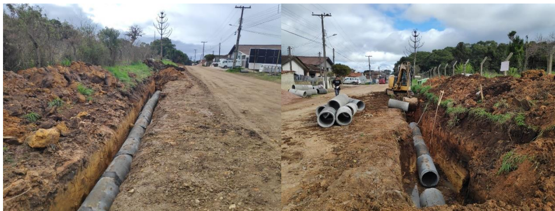
Fotos - Execução da drenagem.
