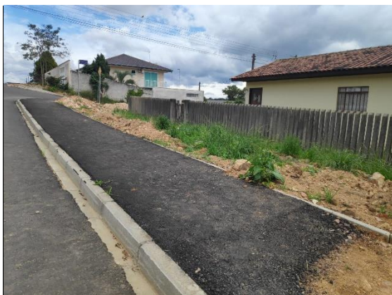
Fotos - Execução da pavimentação da pista e calçada.
