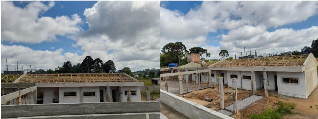
Fotos - Execução da cobertura.
