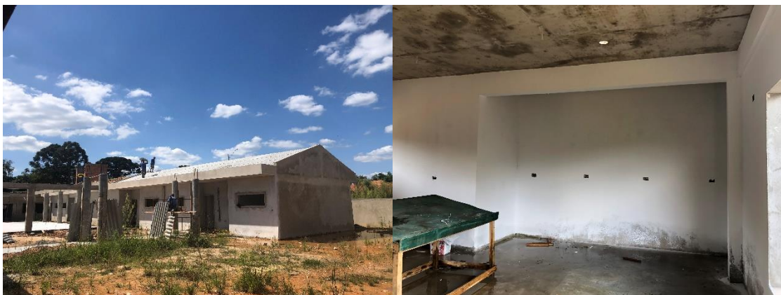
Fotos - Execução da cobertura e emassamento das paredes internas.
