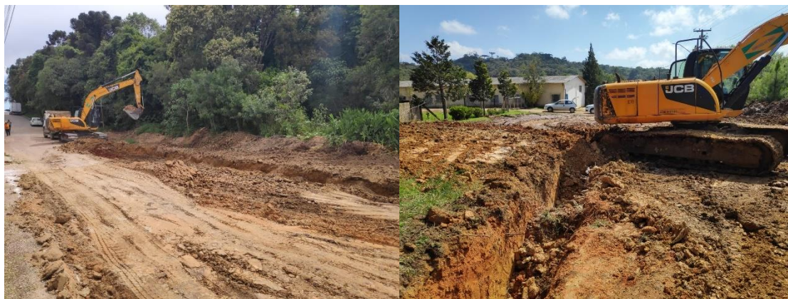
Fotos - Execução da drenagem.
