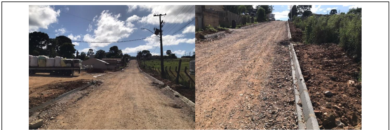
Fotos - Execução da cobertura.
