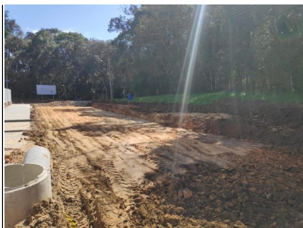
Fotos 01/02 - Regularização da pista e assentamento do meio-fio.
