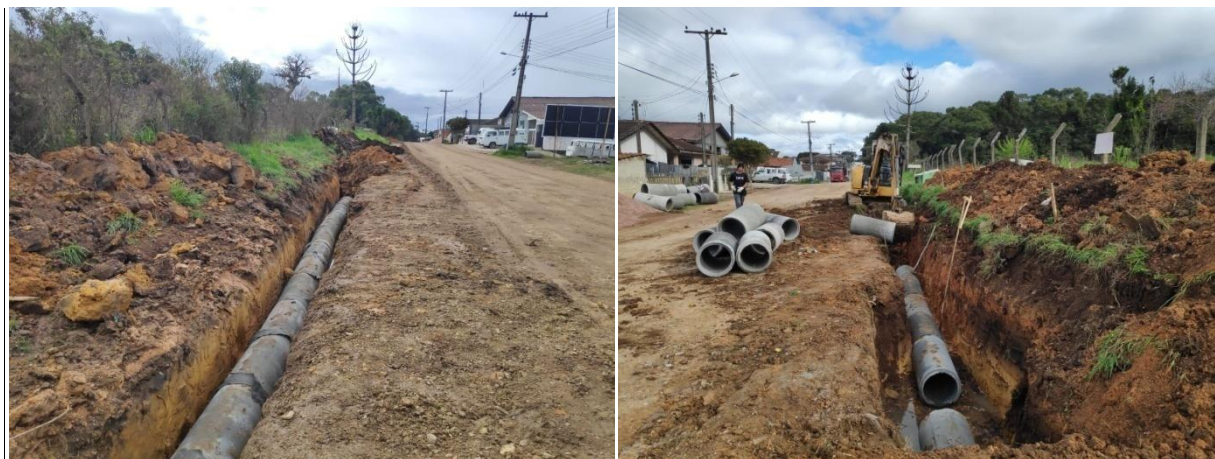
Foto 01/02 - Execução da drenagem.
