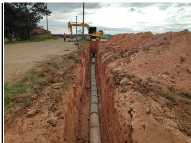
Fotos 01/02 - Execução da drenagem.
