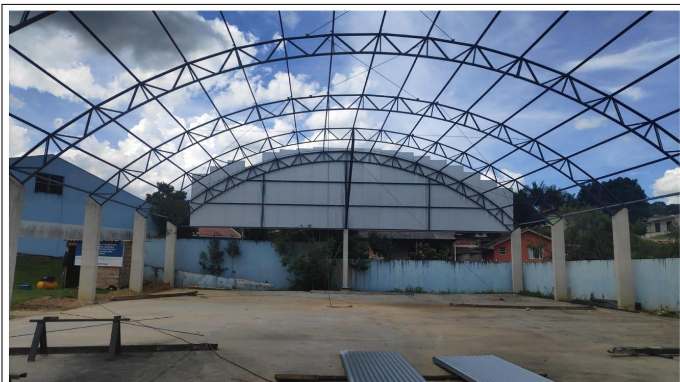
Fotos - Execução da cobertura metálica.
