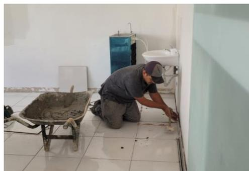
Fotos - Execução bancadas e colocação da cerâmica.
