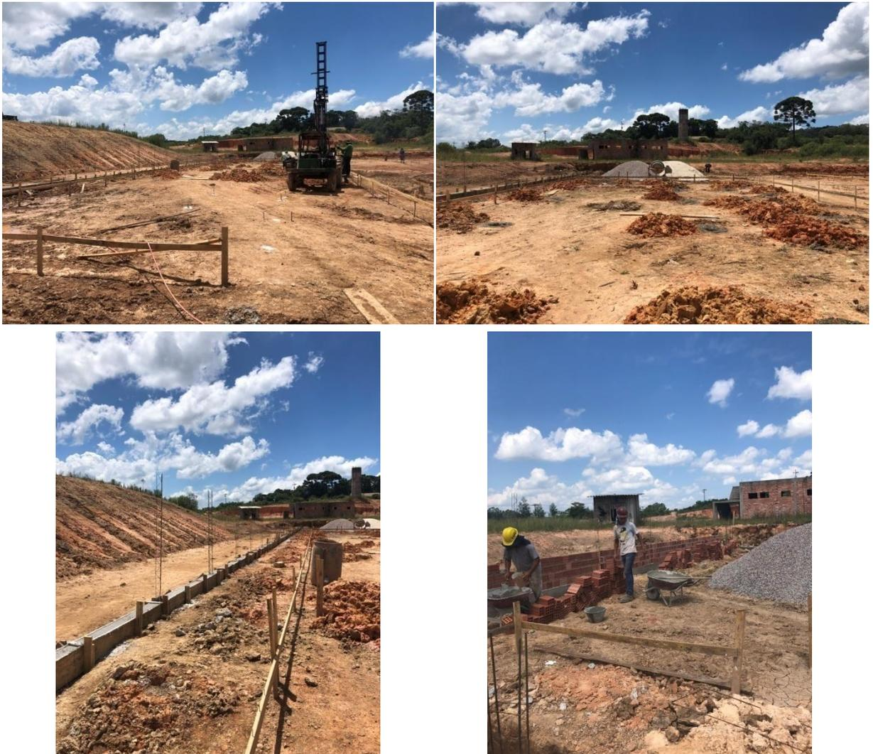
Foto 01/02 - Execução e concretagem das estacas. 03/04 Fundação do muro e execução da alvenaria.
