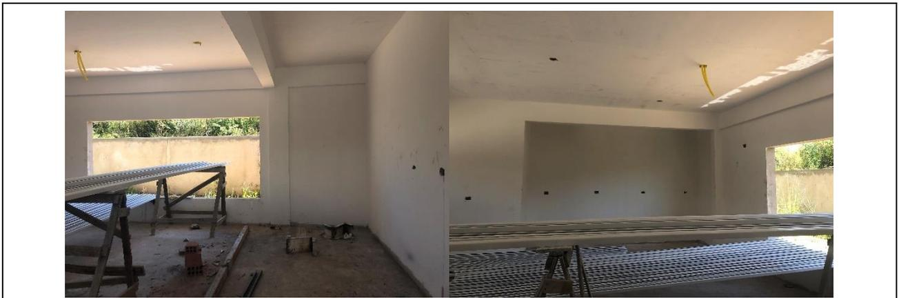
Fotos - Emassamento paredes internas.
