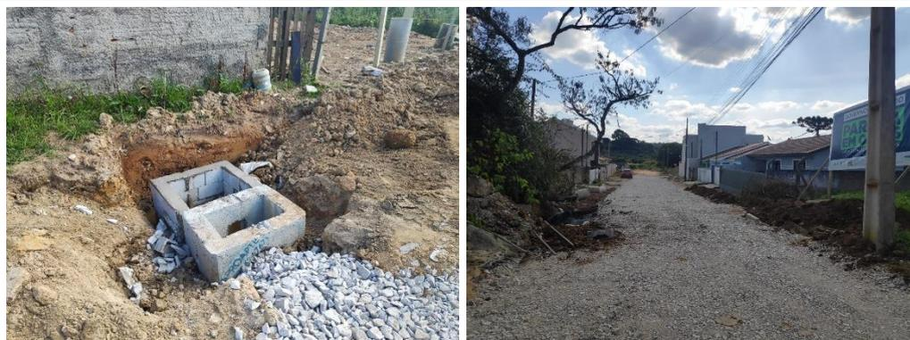
Fotos - Execução de drenagem e regularização da pista.
