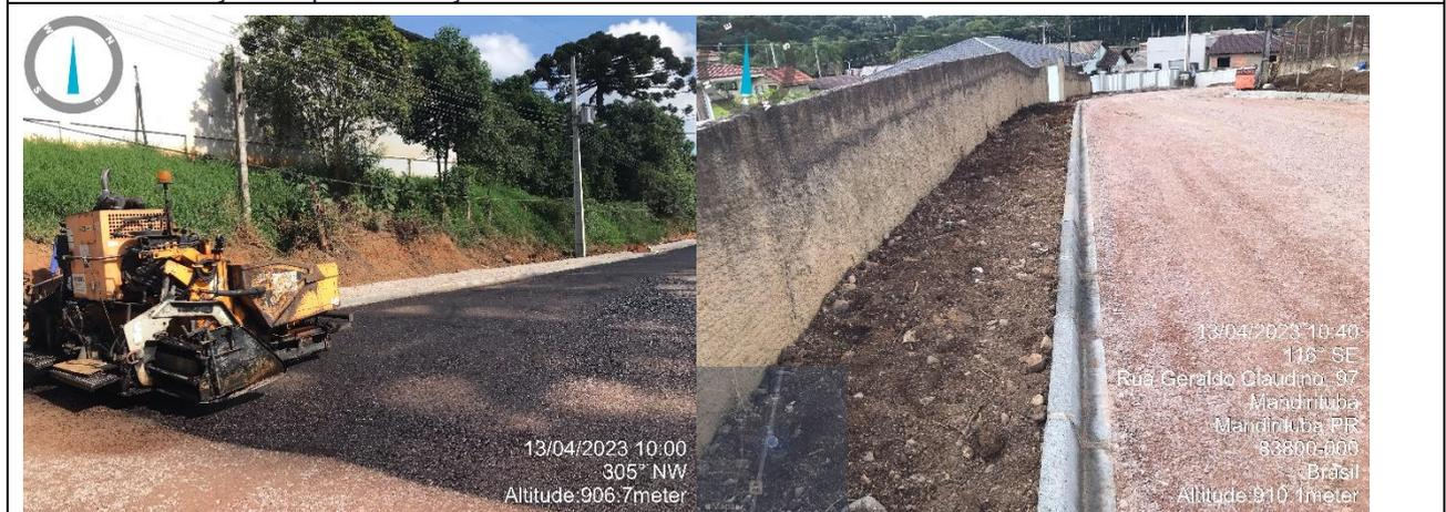
Fotos - Execução da pavimentação e regularização da pista.
