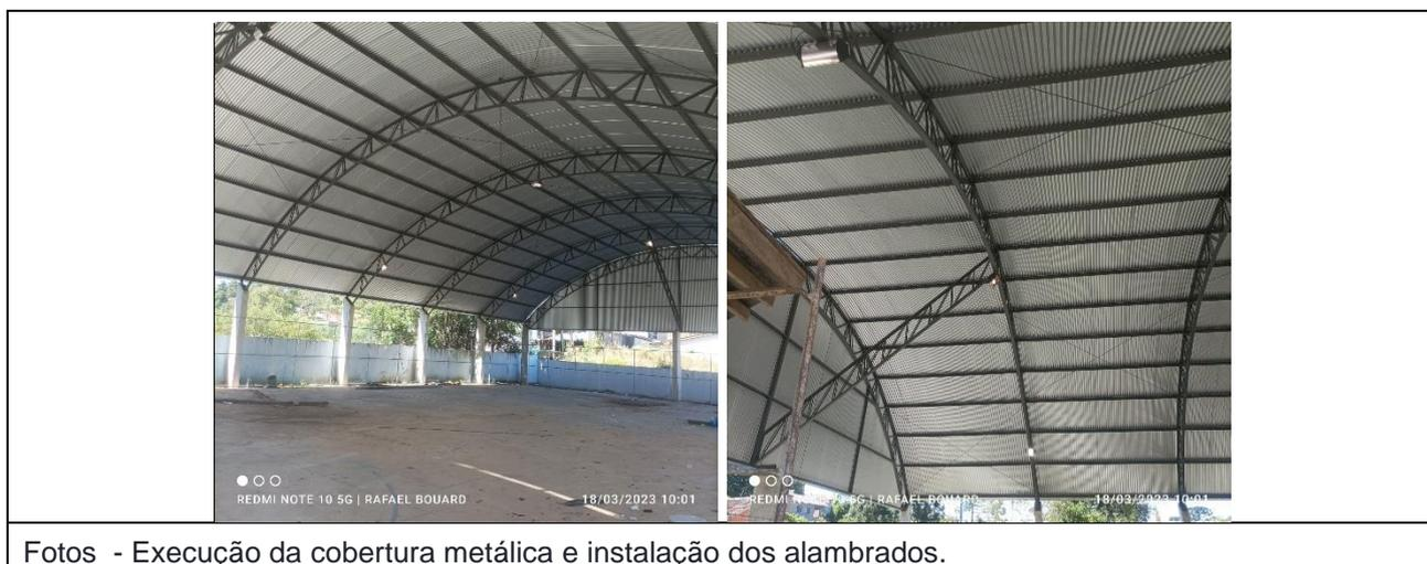
Fotos - Execução da cobertura metálica e instalação dos alambrados.
