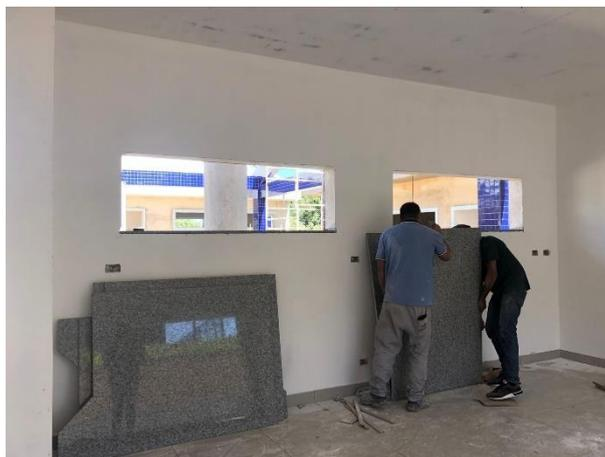
Fotos - Fachada e instalação de bancadas.
