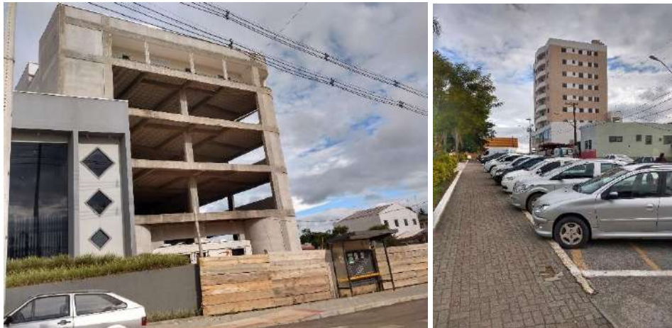
Figura 3-26 – Fotos da visita da área urbana: Edificações de cinco e oito andares
