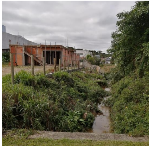
Figura 5-3 – Afluente do Rio dos Patos, com intervenção na APP e erosão do talude.
