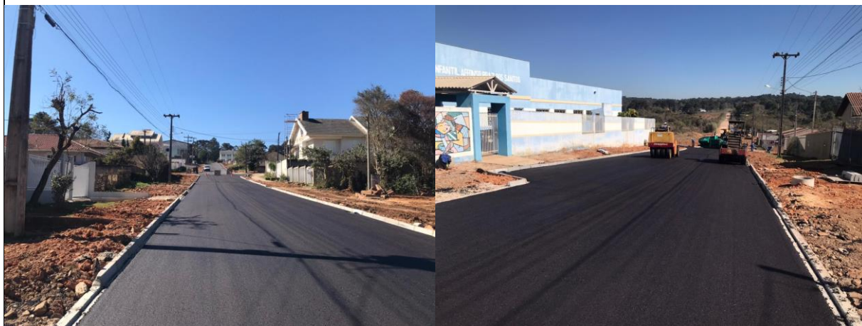
Foto 01/02 – Assentamento do meio-fio e execução da base.
