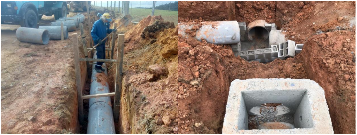
Foto 03/04 – Execução da drenagem.
