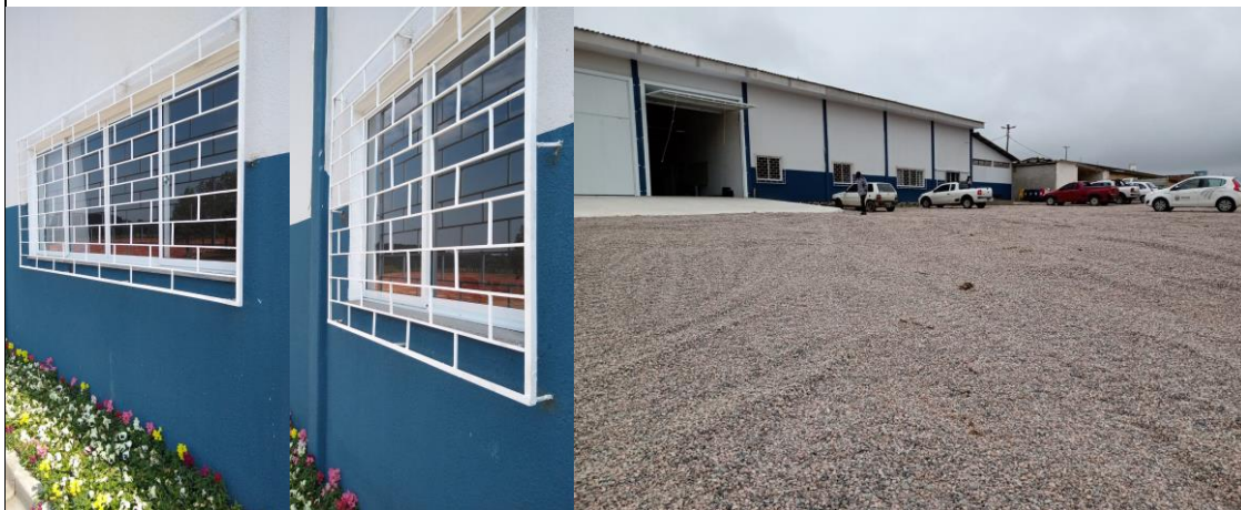
Foto 01/02 – Finalização das grades e estacionamento em brita.
