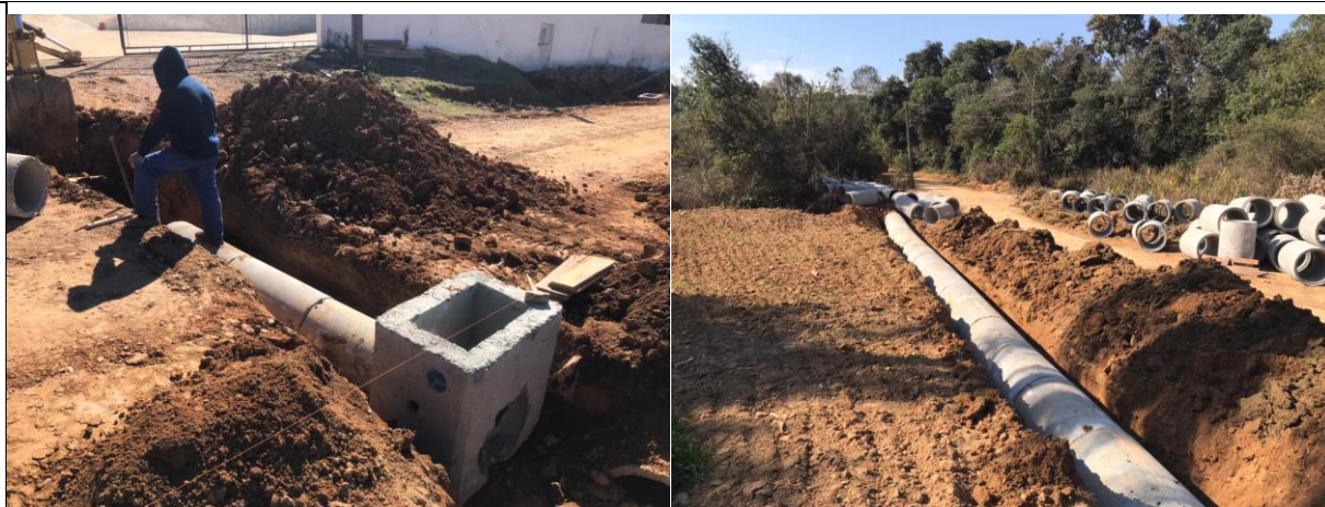
Foto 01/02 – Execução da drenagem.
