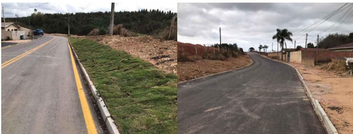
Foto 01/02 - Execução do pavimento.
