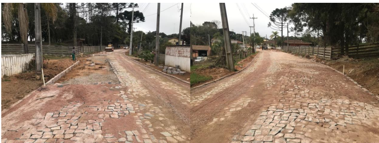
Foto 01/02 - Execução do pavimento.
