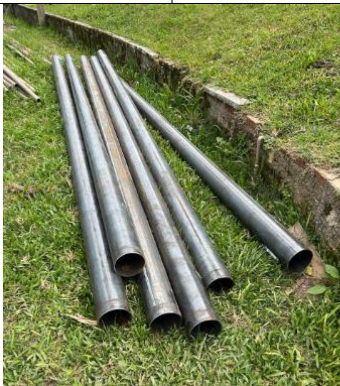
Tubos para revestimento para perfuração do poço de Caí de Baixo.
