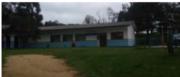
FACHADA POSTO DE SAÚDE ALFREDO RIEKE SOBRINHO
