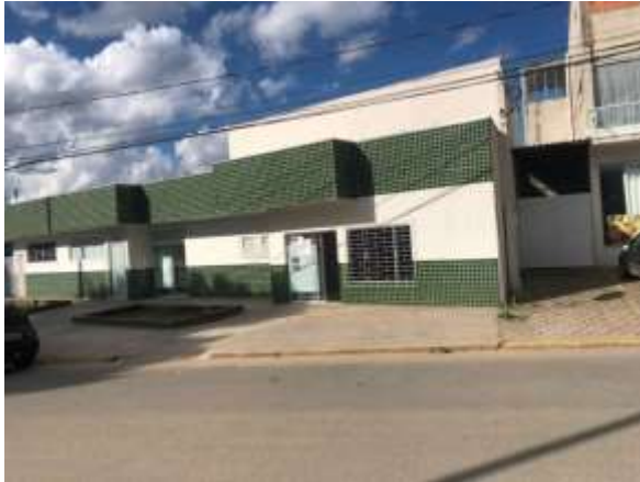
FACHADA POSTO DE SAÚDE ELSIO DE ASSIS
